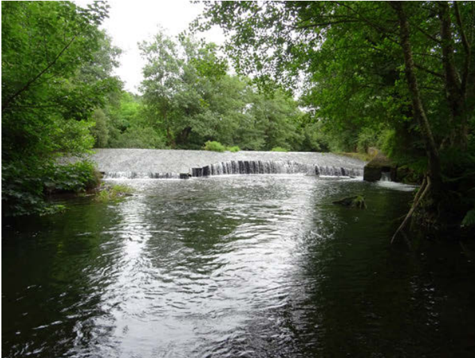
Foto 7: Azud de derivación con escala para peces localizado en las proximidades de la desembocadura del río Porcia (Zona 3).
