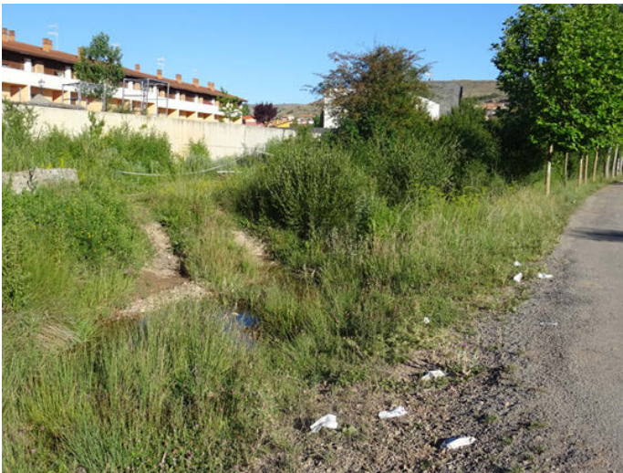
Foto 15. Estructuras longitudinales de protección frente a inundaciones en Cedrillas
