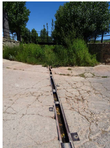
Foto 16. Vado de hormigón con cauce de aguas bajas en Cedrillas
