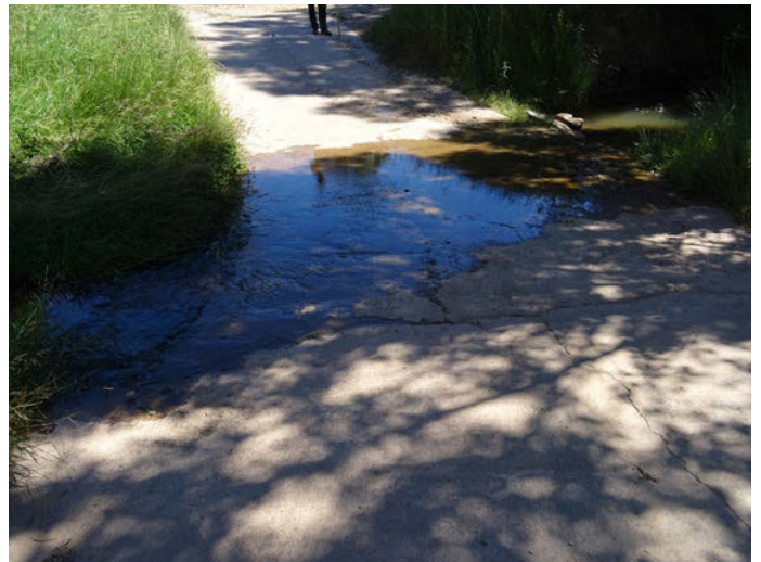
Foto 22. Vado para el cruce de una margen a otra en Cedrillas
