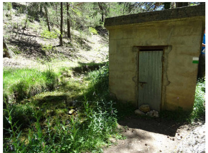
Foto 6. Caseta de antigua captación de agua ocupando el DPH en el tramo alto de la RNF
