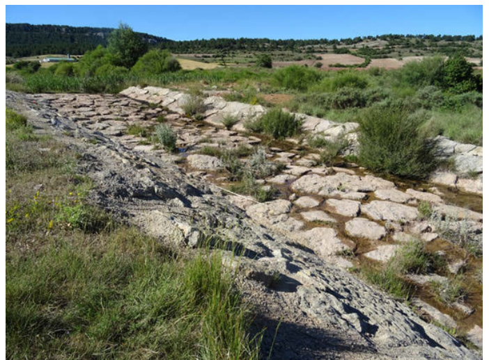
Foto 12. Azud de mampostería de 30 metros de longitud en la vega del Mijares
