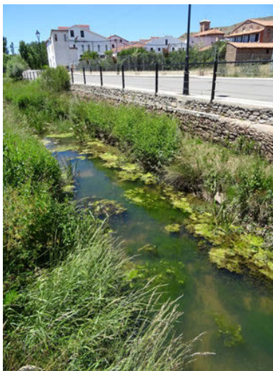
Foto 17. Obra longitudinal de estabilización de la carretera a su paso por Cedrillas
