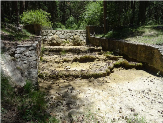
Foto 7. Dique de retención de sólidos en el merendero del Pinar, tramo de cabecera de la RNF
