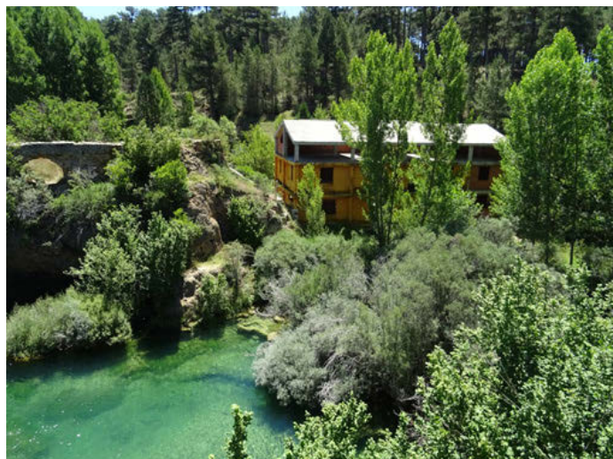
Foto 8. Imagen del edificio a medio construir que ocupa el lugar del antiguo Molino de San Pedro.
