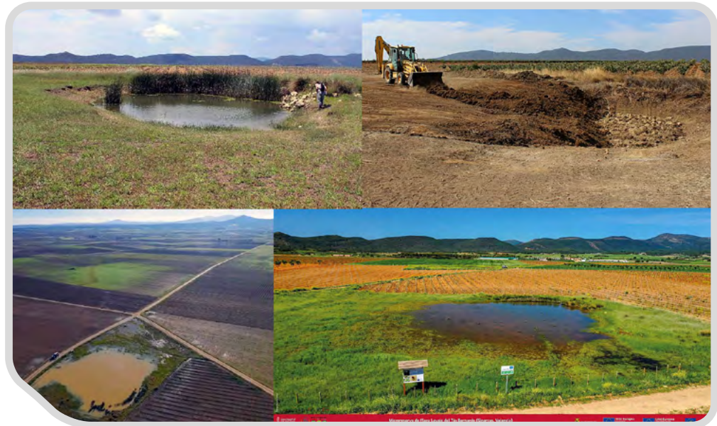
Figura 4. Las Microrreservas de Flora facilitan la ejecución de grandes proyectos de restauración. En la MRF Lavajo del Tío Bernardo (Sinarcas, Valencia) se restauró el perfil de una laguna temporal que había sido excavada en los años 70. Las imágenes muestran el estado inicial, el desarrollo de los trabajos y el estado final de la laguna pocos meses después de finalizada la obra. En la parte inferior derecha, póster de la serie "Hábitats Protegidos de las Comunidad Valenciana" que atiende los objetivos de formación y divulgación que también promueve el proyecto de las Microrreservas.
