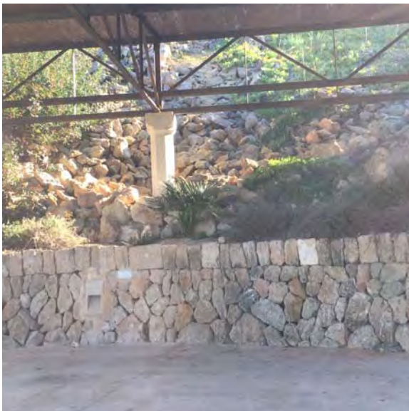
Foto 17.- Es Caló de la Reina. Muretes de mampostería existentes, similar a la tipología que se pretende emplear.
