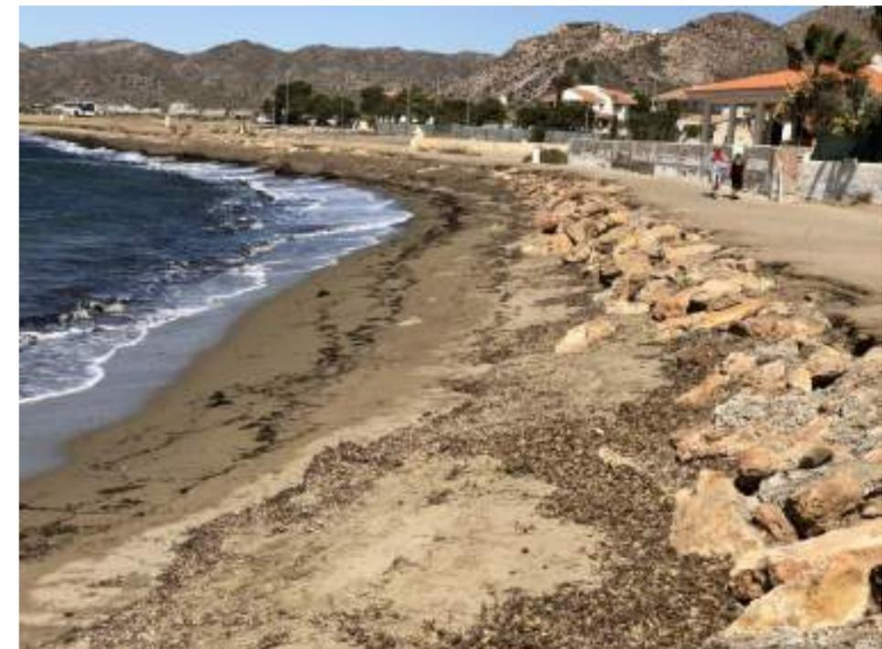
Figura 2. Escollera existente a retirar vertida irregularmente
