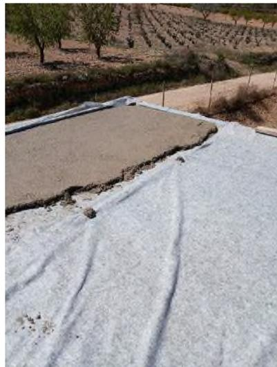
Material utilizado para impermeabilización de las cubiertas
