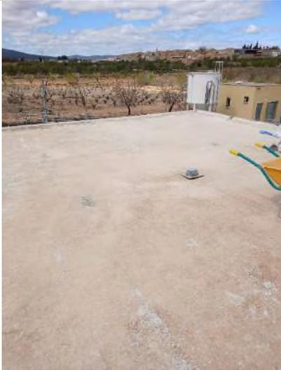
Renovación impermeabilización en edificio de control: eliminación cubierta anterior
