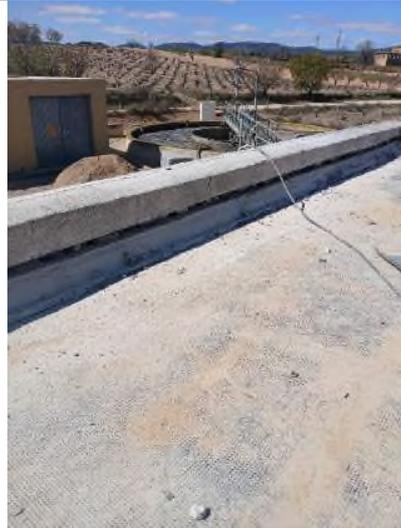
Renovación impermeabilización en edificio de pretratamiento: eliminación cubierta anterior
