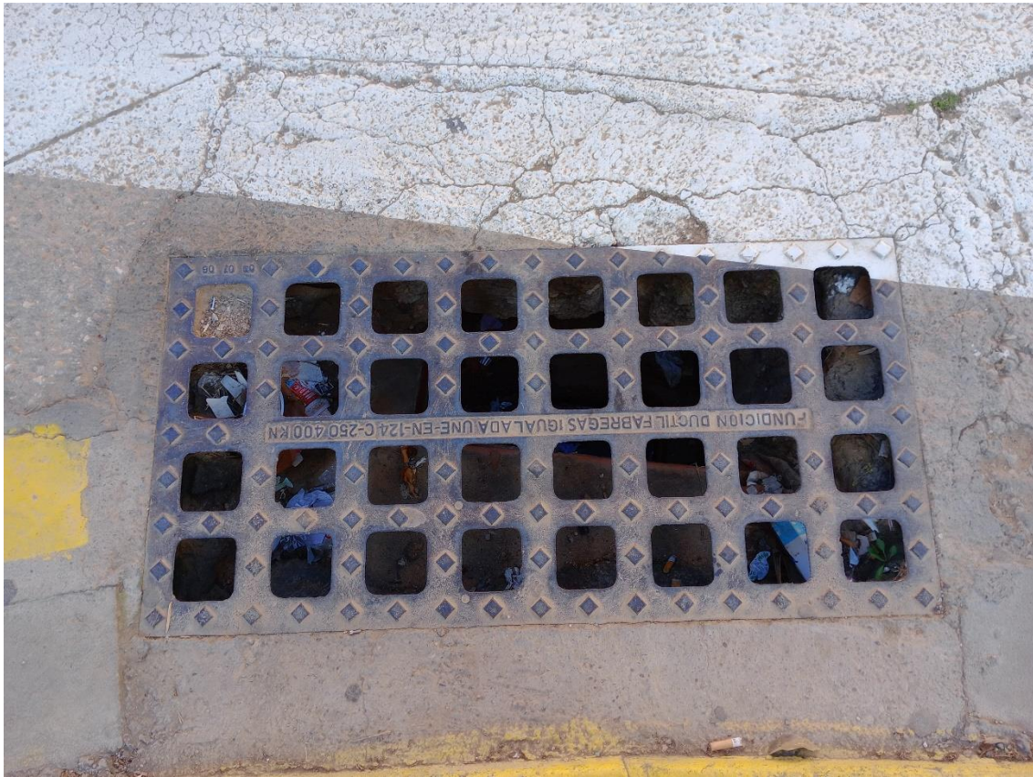
5. C/ CUENCA. DETALLE DE ATERRAMIENTO
