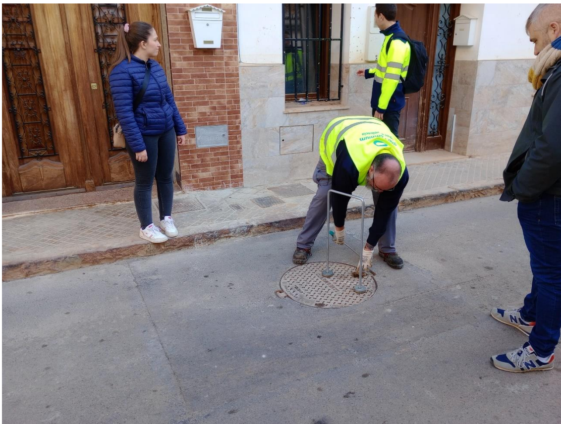
7. C/ LA PAU. ARQUETA OPERATIVA POR LIMPIEZA RECIENTE
