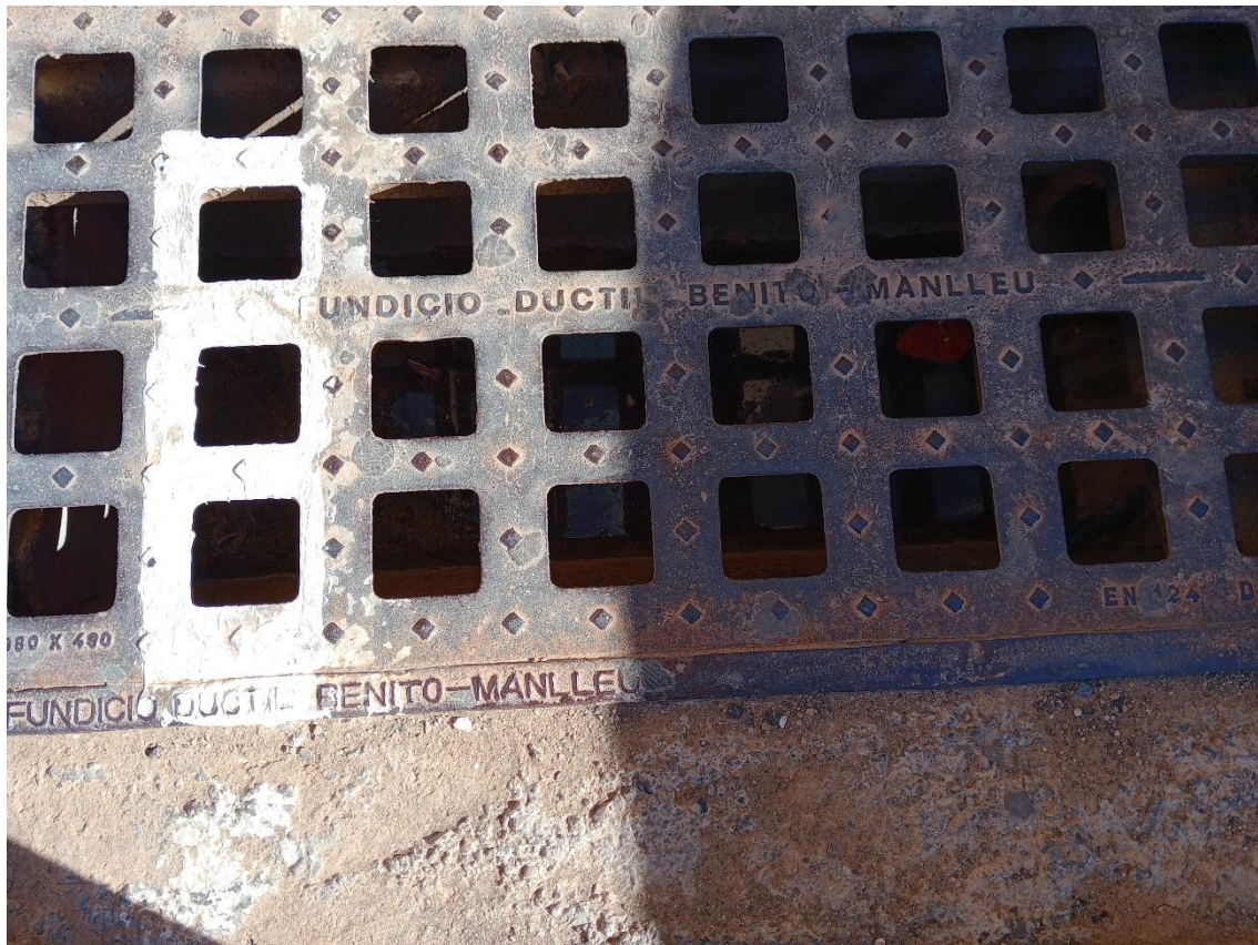
3. C/ CUENCA. DETALLE DE ATERRAMIENTO EN IMBORNAL
