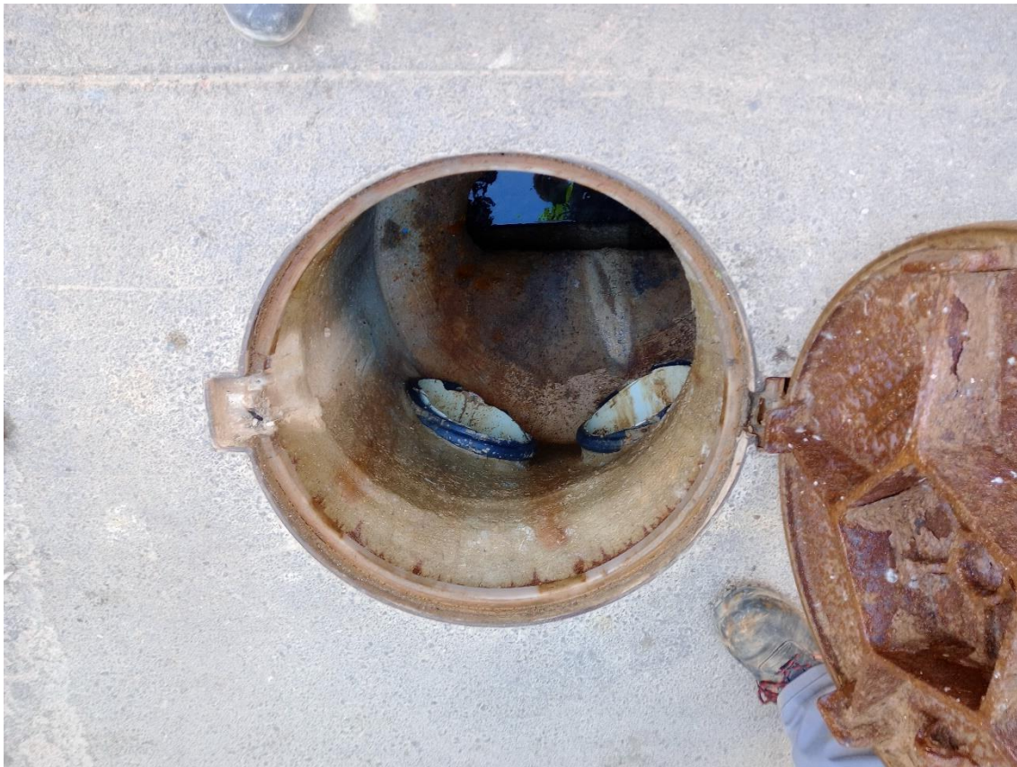
7. C/ LA PAU. DETALLE DE REGISTRO OPERATIVO
