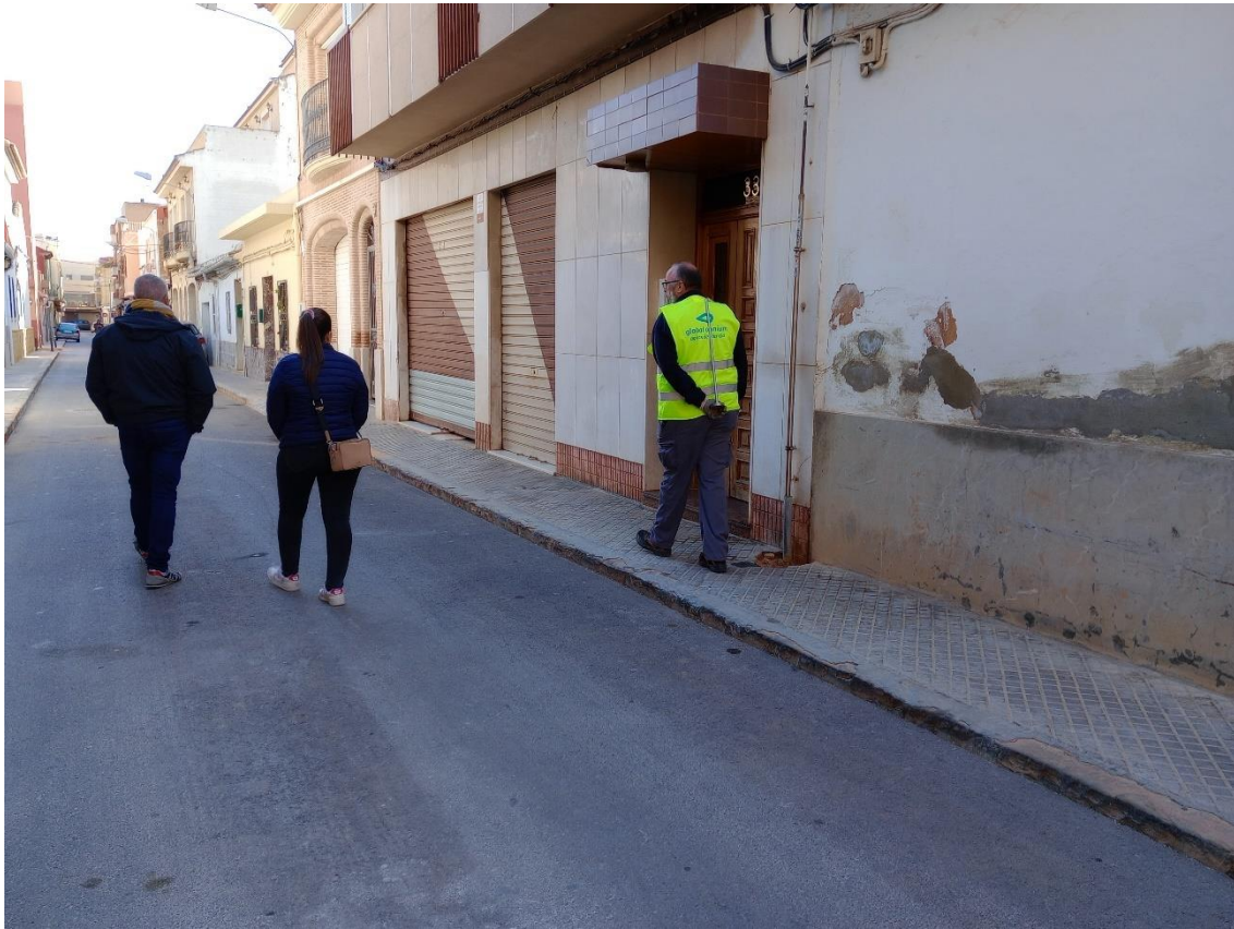
7. C/ LA PAU. DETALLE DEL NIVEL DE AGUA ALCANZADO
