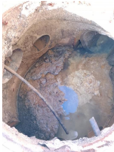
C/ Albacete. Detalle de tapa con hundimientos y arqueta casi colmatada.
