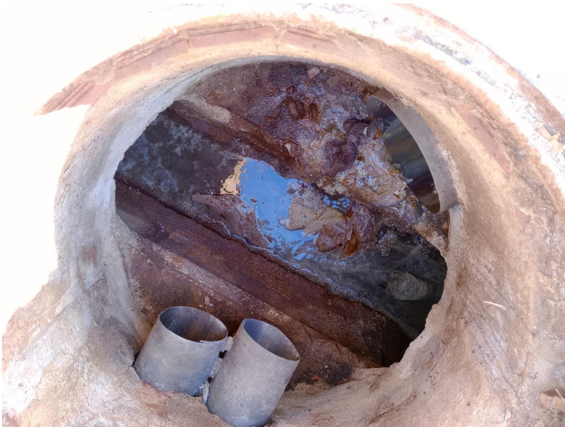
5. C/ CUENCA. DETALLE DE ARQUETA OPERATIVA
