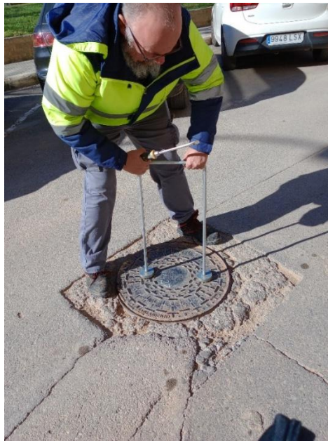
C/ Albacete. Detalle de tapa con hundimientos y arqueta casi colmatada.
