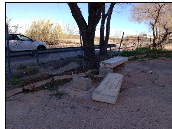
3 CUNETA RONDA DE ALAQUAS . LONGITUD: 419 m.
