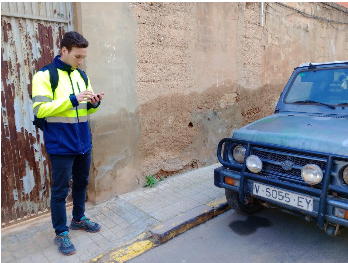
6. C/ DOS DE MAYO. DETALLE DEL NIVEL DE AGUA ALCANZADO
