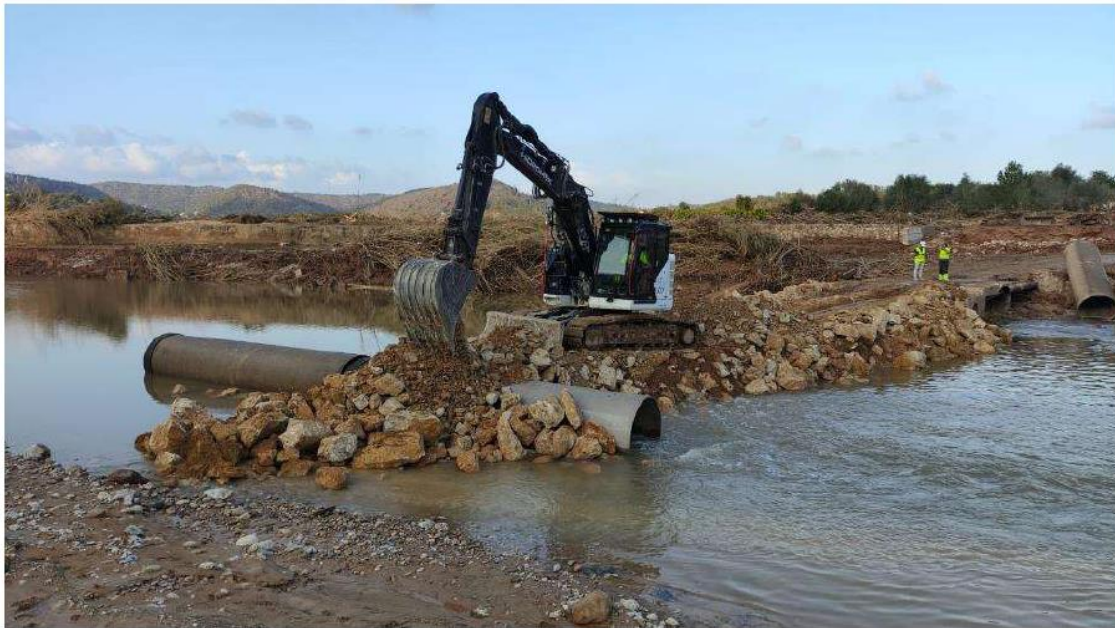
Imagen 11: Trabajos de reparación provisional de tubería de 300 mm sobre río Magro. Fase 0
