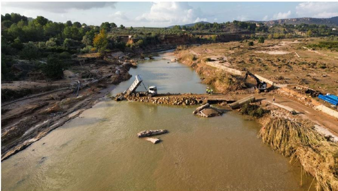
Imagen 12: Trabajos de reparación provisional de tubería de 300 mm sobre río Magro. Fase 0
