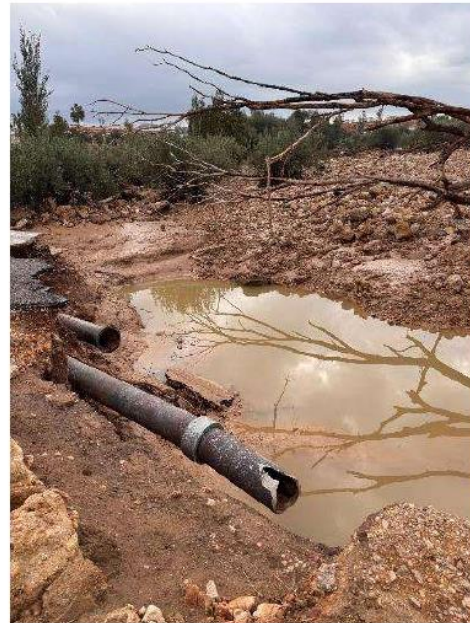
Imagen 1: Rotura conducción FC 150 mm. 70 m de longitud. Urbanización Valletes.
