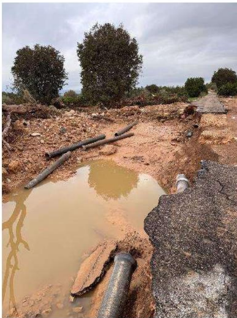
Imagen 1: Rotura conducción FC 150 mm. 70 m de longitud. Urbanización Valletes.
