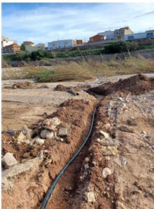
Imagen 4: Reparación provisional FC 150 mm red de transporte a Real sobre Rio Magro. Fase 0
