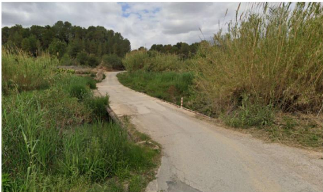
Imagen 6: Vista del paso inundable sobre el rio Magro previa a la DANA
