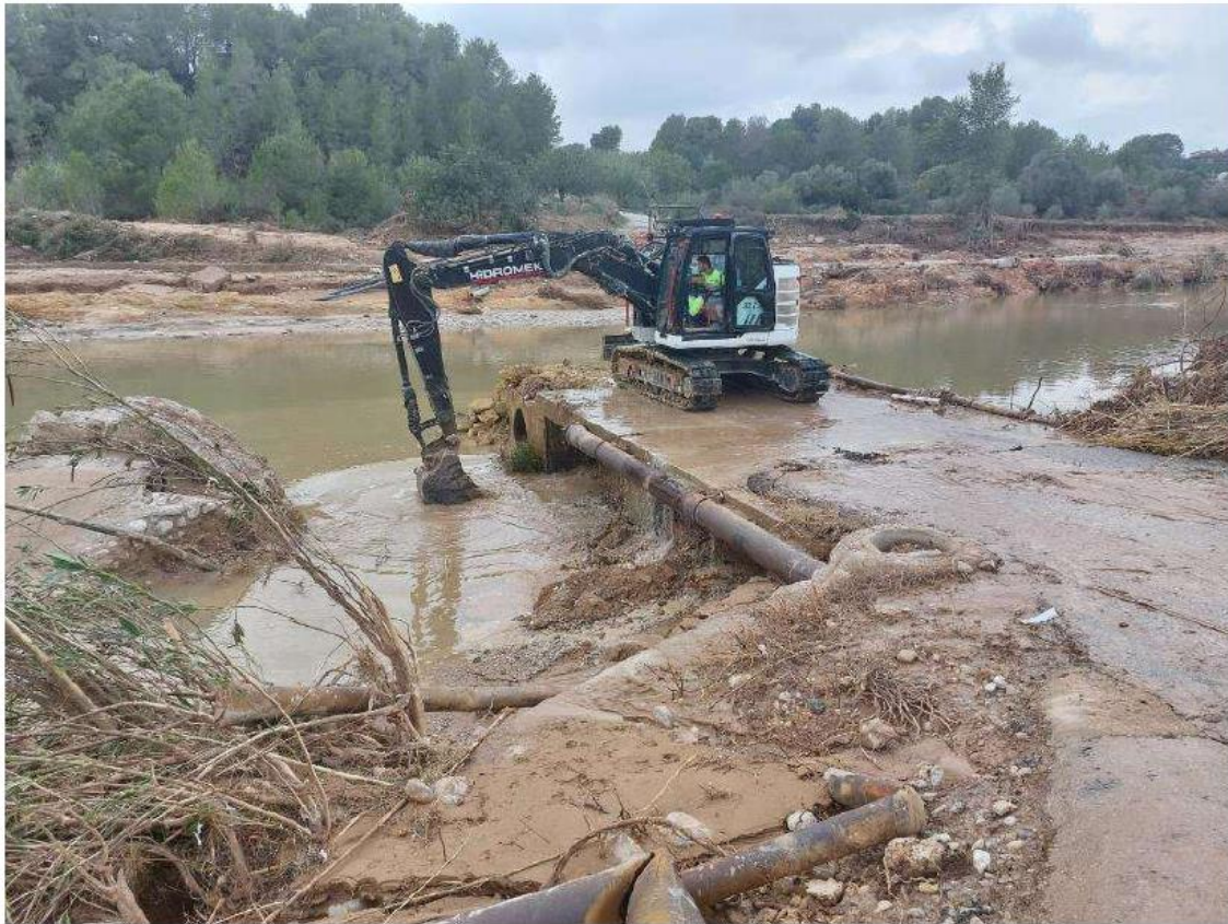
Imagen 9: Trabajos de reparación provisional de tubería de 300 mm sobre río Magro. Fase 0
