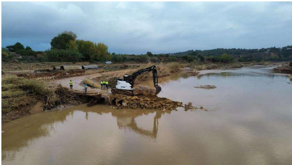
Imagen 10: Trabajos de reparación provisional de tubería de 300 mm sobre río Magro. Fase 0
