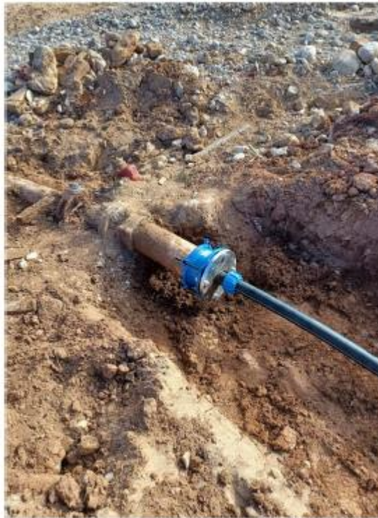
Imagen 5: Reparación provisional FC 150 mm red de transporte a Real sobre Rio Magro. Fase 0
