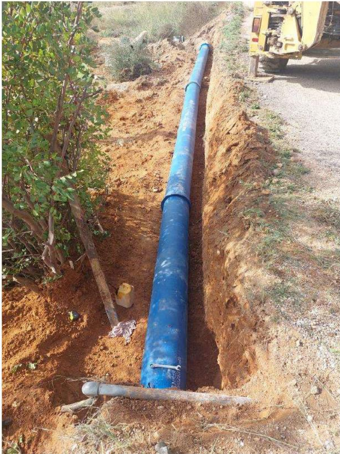
Imagen 16: Reparación segundo tramo tubería FD 300m 18 ml. Fase 0
