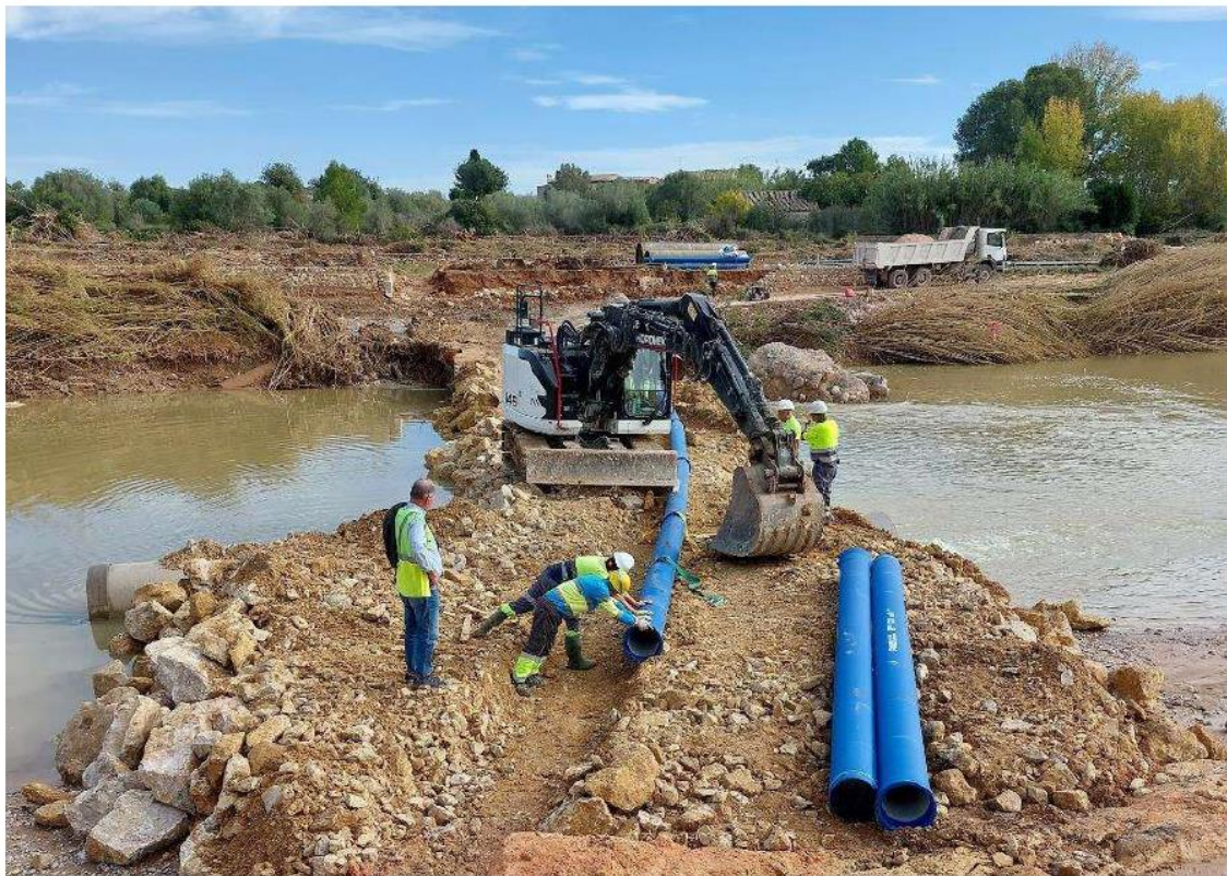
Imagen 13: Trabajos de reparación provisional de tubería de 300 mm sobre rio Magro. Fase 0
