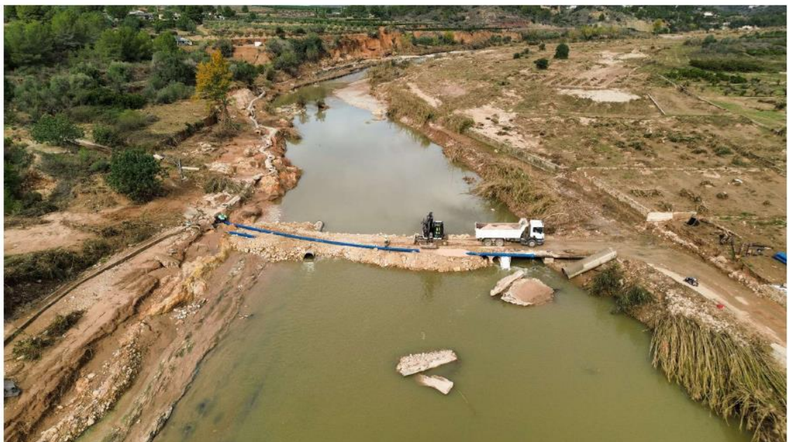
Imagen 14: Trabajos de reparación provisional de tubería de 300 mm sobre rio Magro. Fase 0
