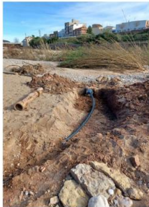
Imagen 4: Reparación provisional FC 150 mm red de transporte a Real sobre Rio Magro. Fase 0
