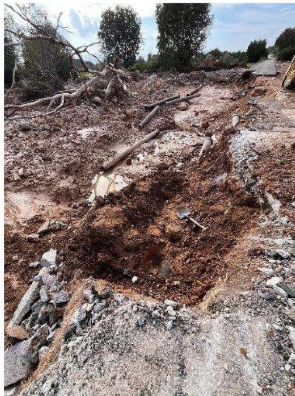
Imagen 2: Trabajos de adecuación del Barranco. Fase 0
