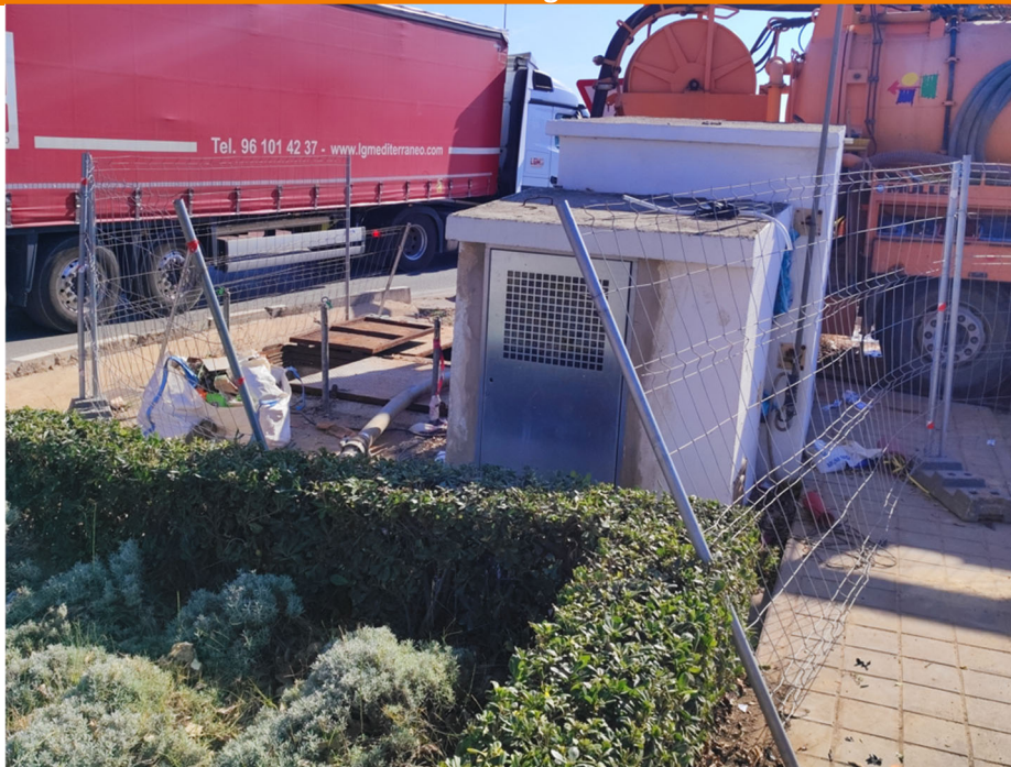
Reposición provisional de la EBAR Bonaire y camión CIS para limpieza del pozo
