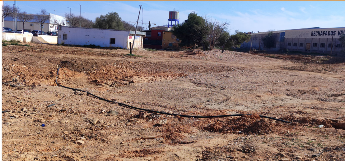
Reparación en red de agua potable, Barranco de la Saleta
