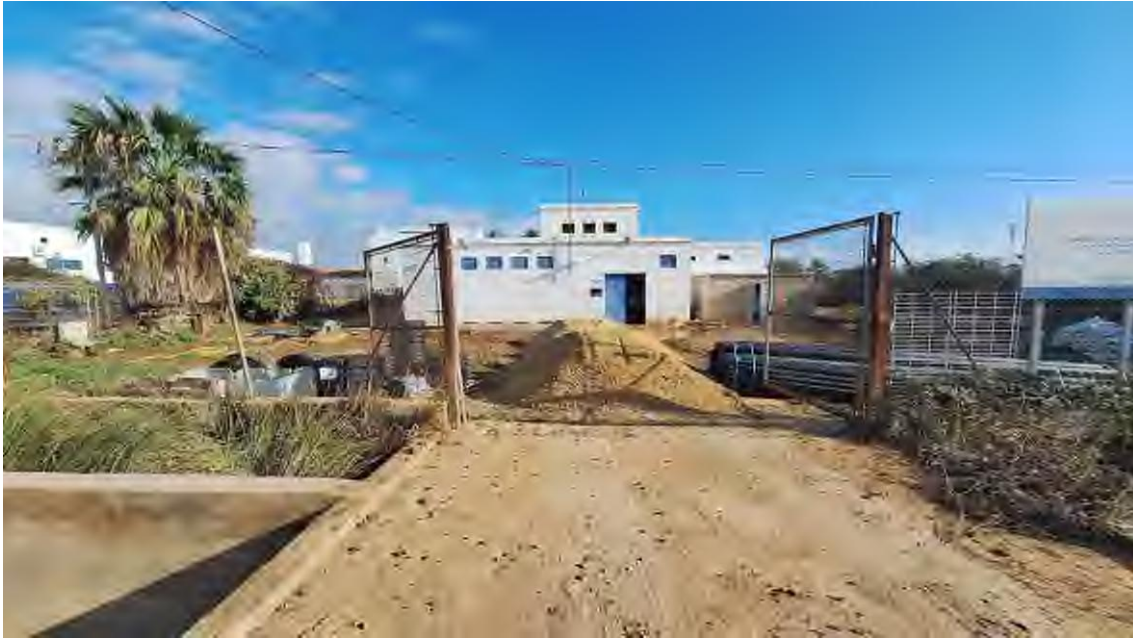
Imagen nº5. Adecuación de accesos y vallado Dep. Castañeda
