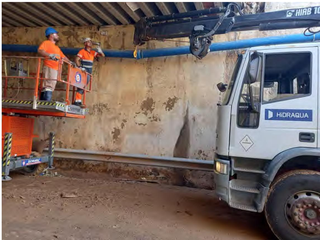
Imagen nº12. Trabajos de reparación definitiva
