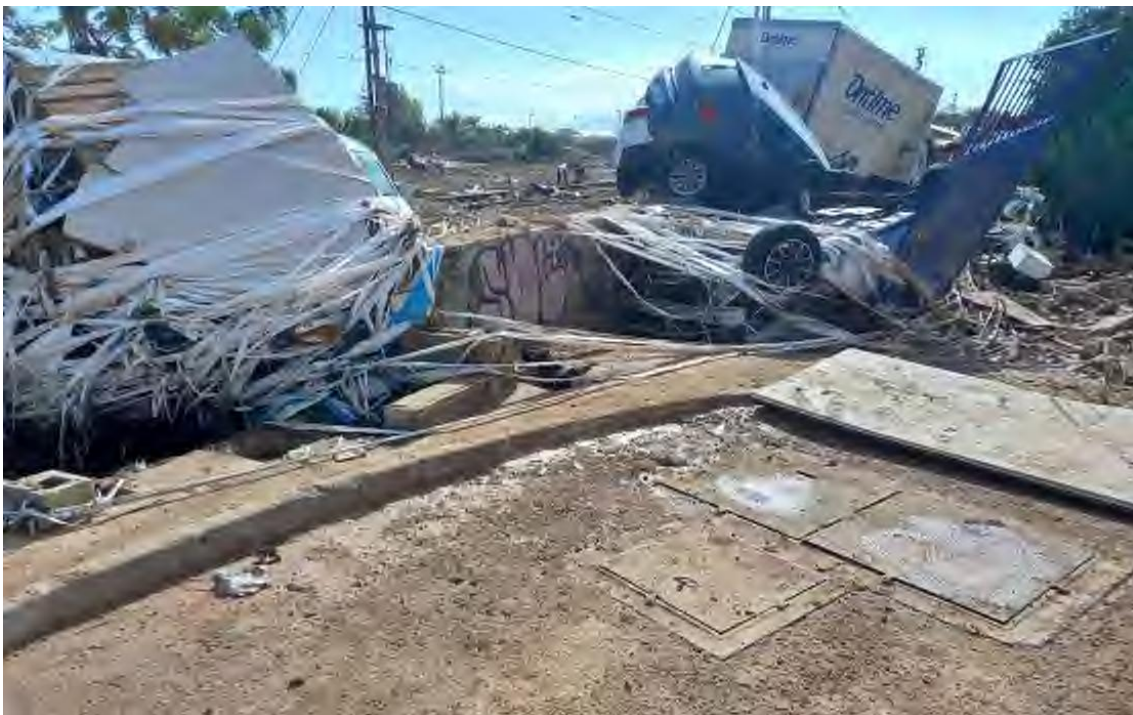
Imagen nº22. Estación de Bombeo Orba
