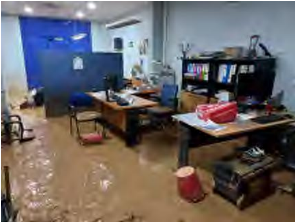
Imagen nº14. Oficina Atención al cliente inundada
