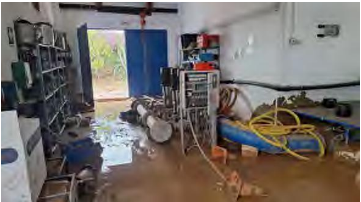
Imagen nº2. Interior almacén depósito Castañeda
