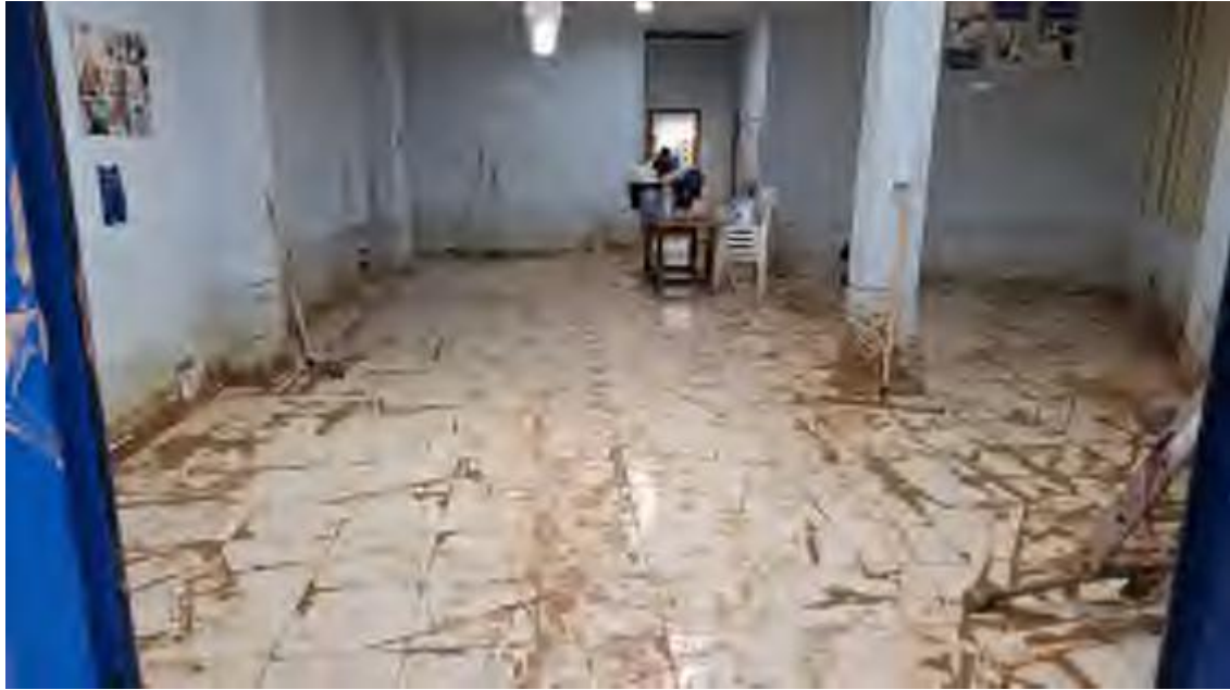
Imagen nº15. Trabajos de Limpieza
