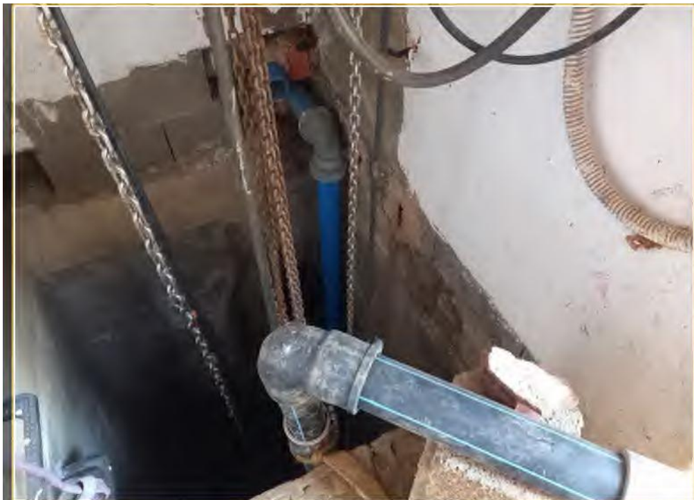
Imagen nº24. Tramo de impulsión provisional en EB Reyes Catolicos
