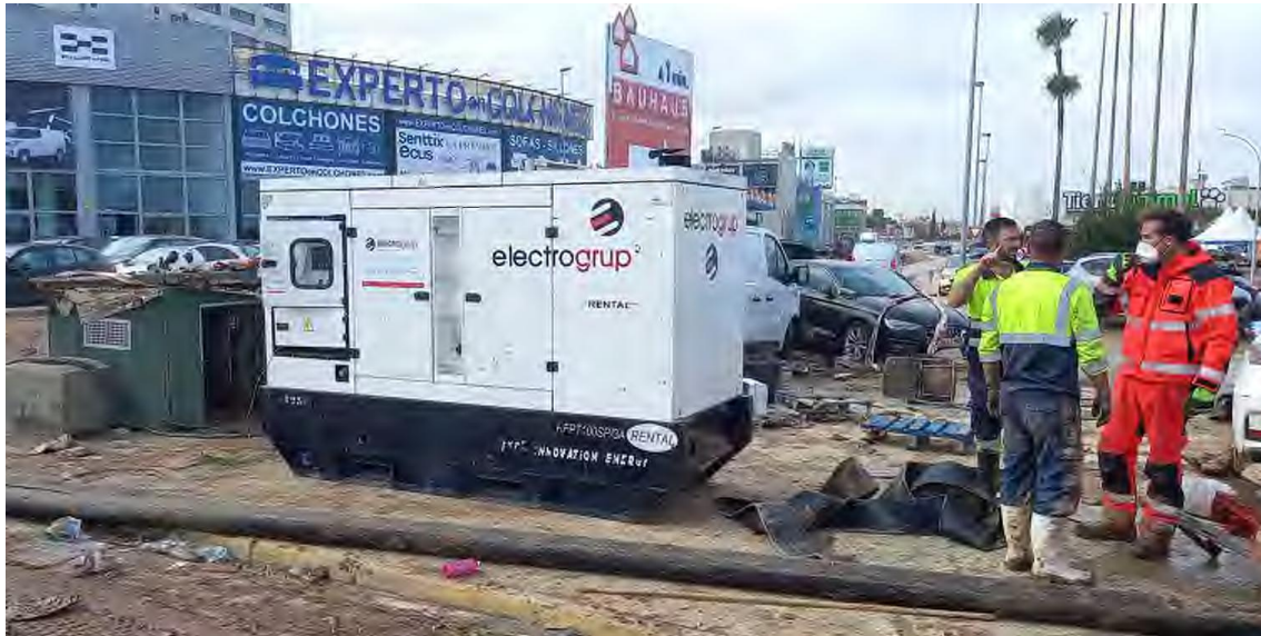
Imagen nº9. Trabajos limpieza y achique paso inferior
