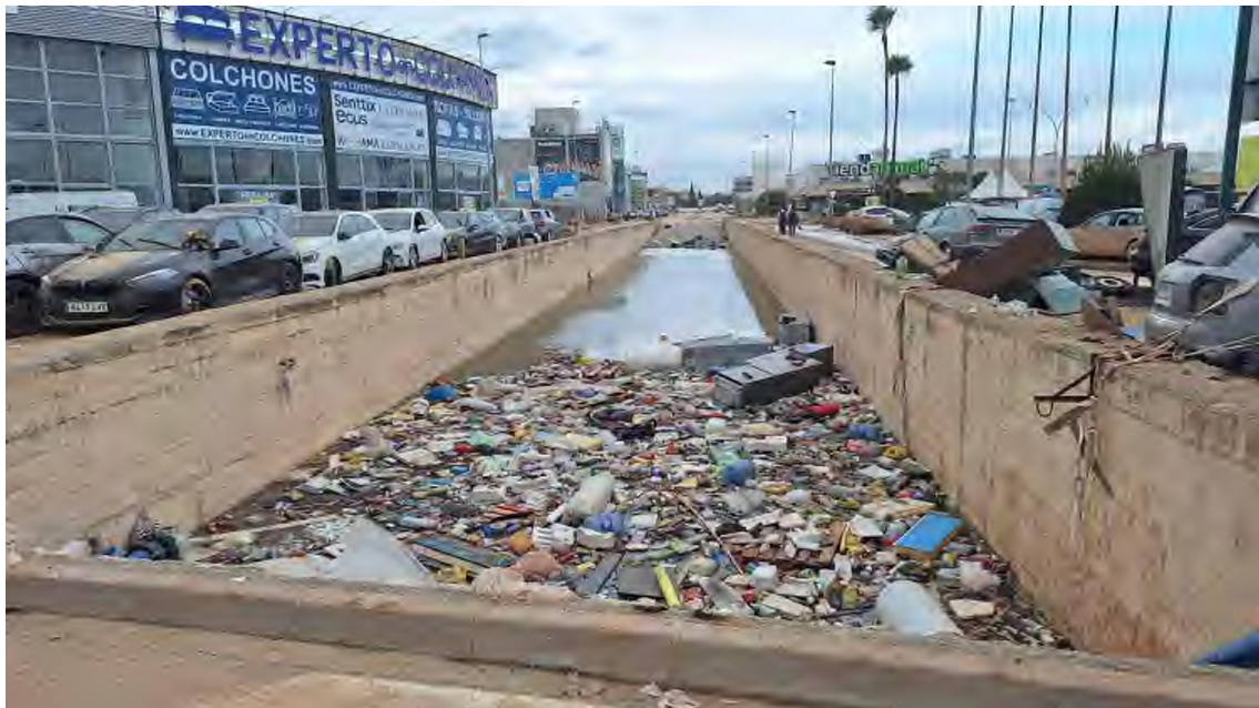
Imagen nº8. Tramo tubería EMSHI paso inferior anegado
