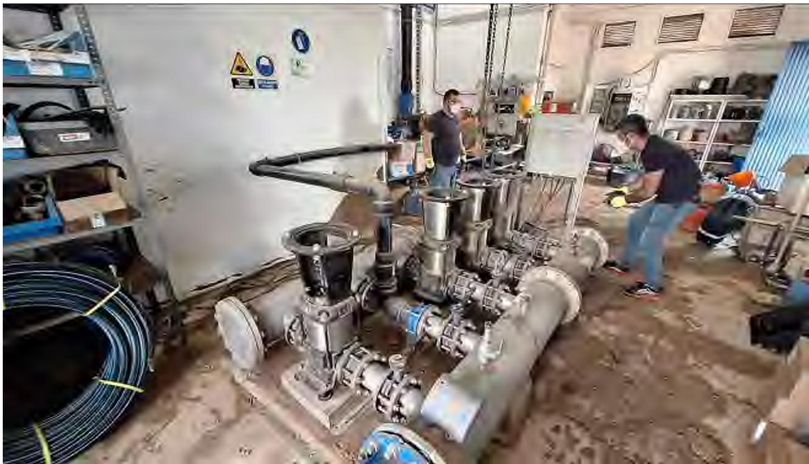
Imagen nº6. Sustitución 4 motores grundfos
