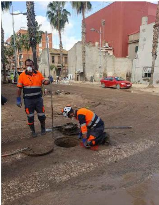
Imagen nº17. Trabajos de limpieza de colectores. Fase 0 emergencia
