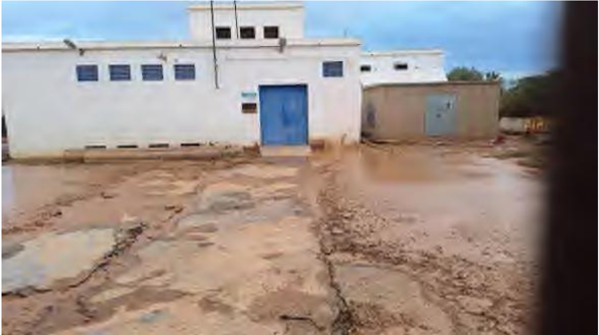
Imagen nº1. Estado parcela depósito tras la DANA
