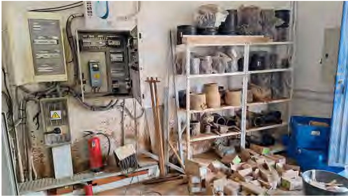
Imagen nº3. Interior almacén depósito Castañeda
