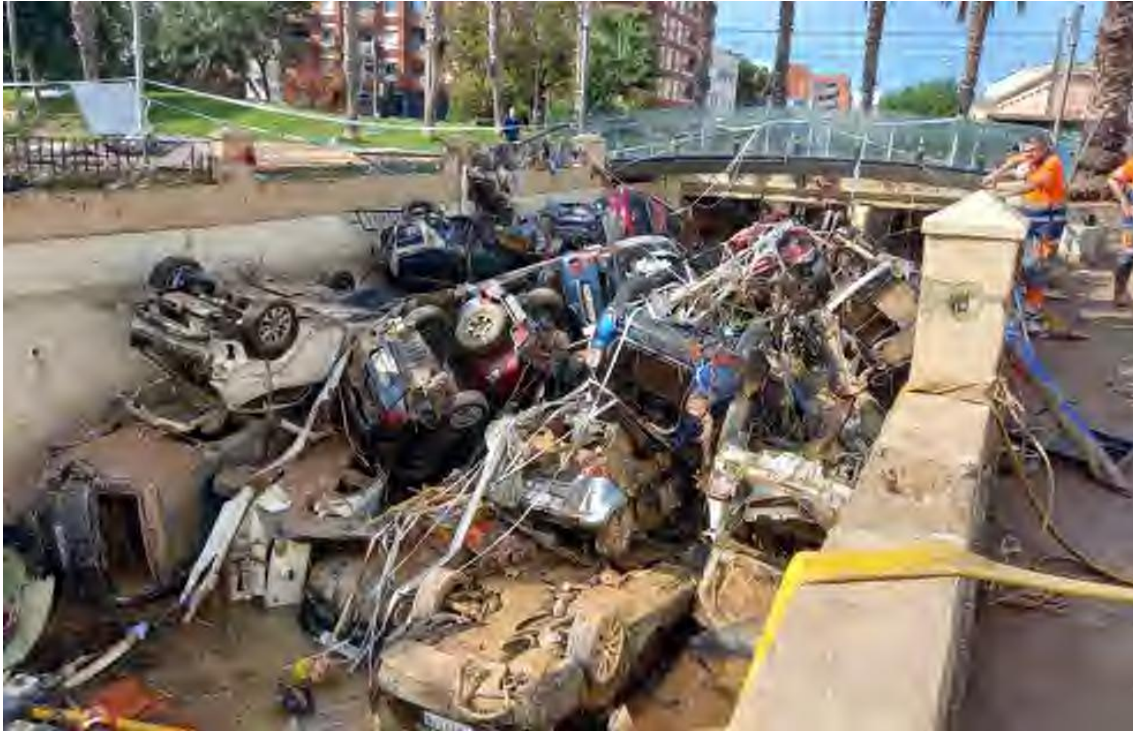
Imagen nº21. Estación de Bombeo Reyes Católicos – Benetusser
