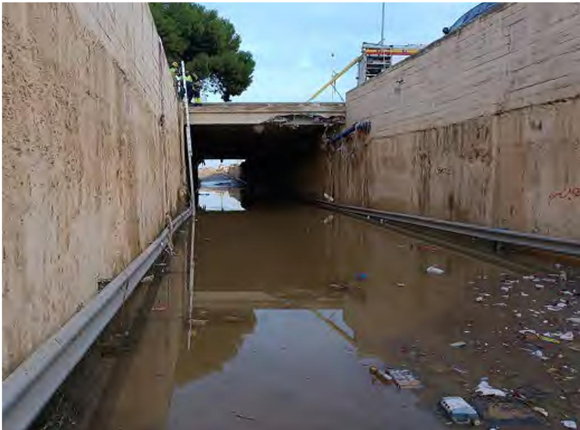
Imagen nº10. Trabajos limpieza y achique paso inferior
