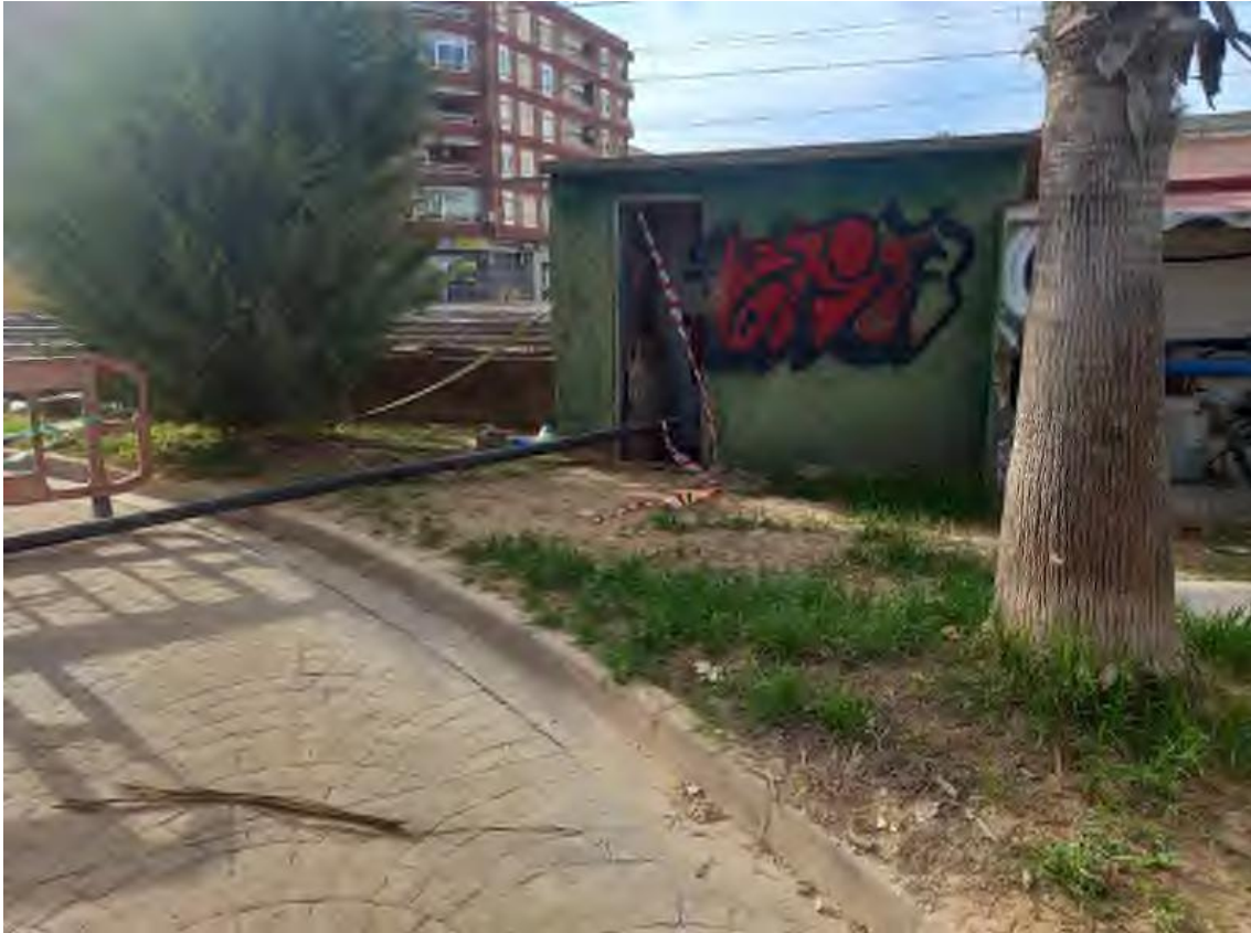
Imagen nº23. Tramo de impulsión provisional en EB Reyes Catolicos
