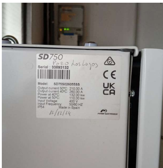
4.- Fotos de la fecha de instalación bombeo Pozo
