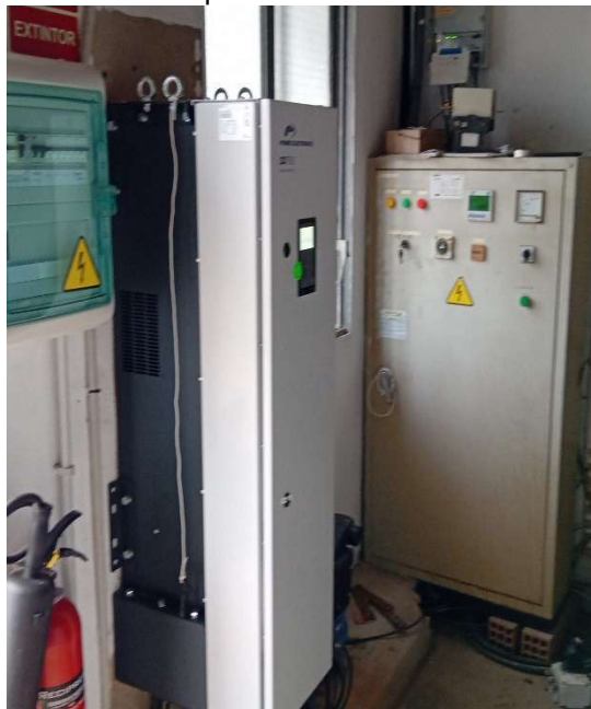
1.- y 2.-variador frecuencia bombeo superior
