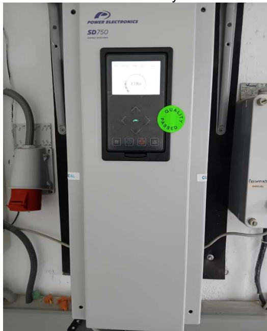
1.- y 2.-variador frecuencia bombeo superior
