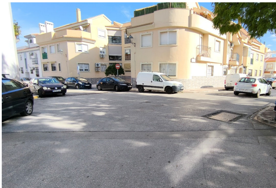
Cruce de las calles Rodríguez de la Fuente y Cabo de Gata. Inicio de la actuación. Fuente: Inspección de campo realizada por AMBLING con fecha de 23/01/2025
