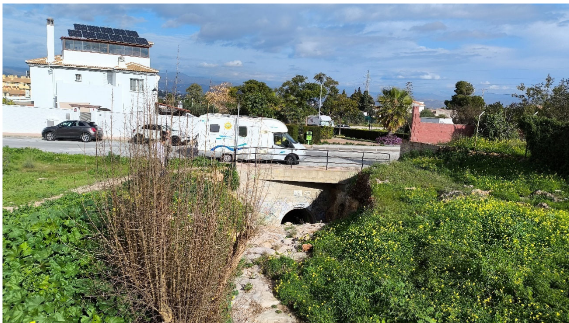
Arroyo del Gato. Final de la actuación prevista. Fuente: Inspección de campo realizada por AMBLING con fecha de 23/01/2025
