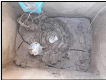
*Fotografía 2. Estado actual arquetas de sectorización afectadas. Detalle 2.*
