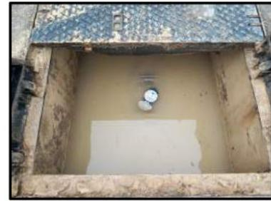
*Fotografía 3. Estado actual arquetas de sectorización afectadas. Detalle 3.*
