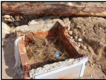
*Fotografía 1. Estado actual arquetas de sectorización afectadas. Detalle 1.*
