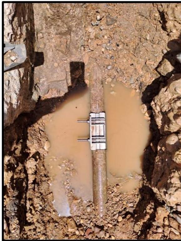
*Reparación provisional en tubería de fibrocemento en Calle Azorín.*
