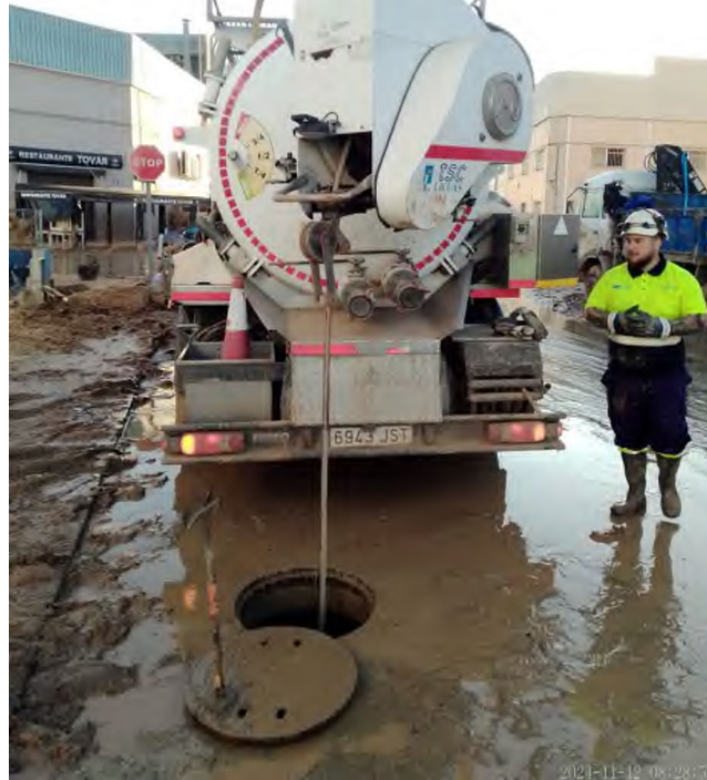
Limpieza de colectores de urgencia en el municipio de Beniparrell
