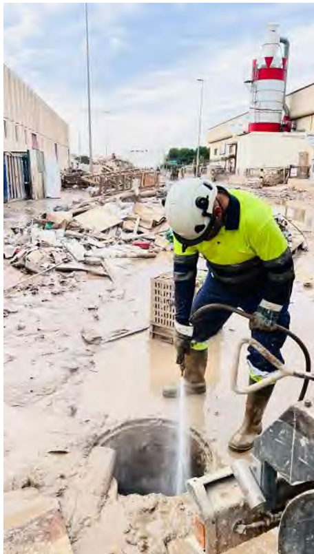
Limpieza de colectores de urgencia en el municipio de Beniparrell
