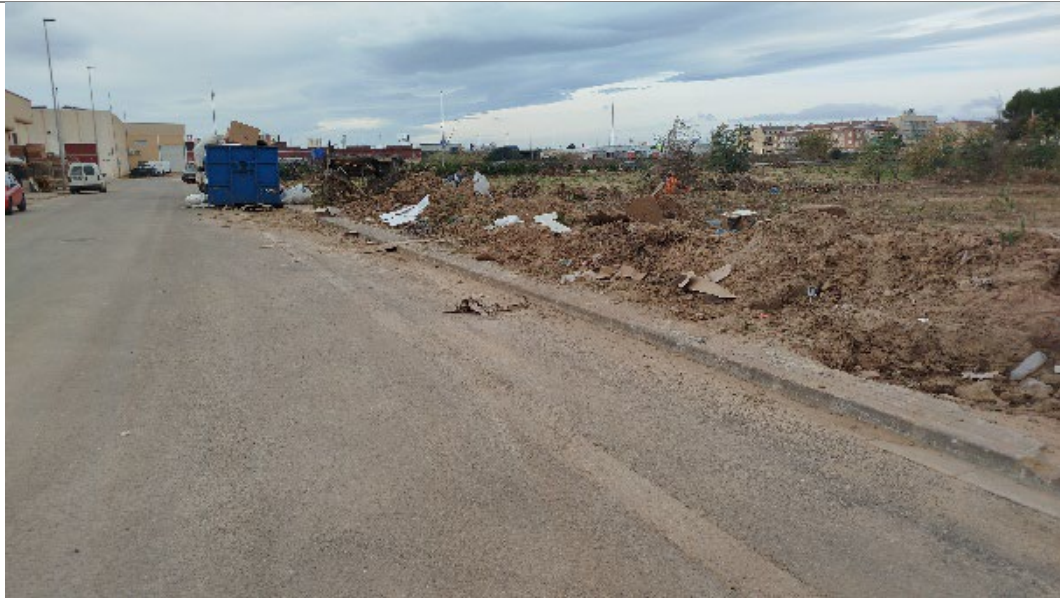
Una calle del Polígono Industrial Vereda Sur con restos de barro y otros elementos arrastrados por la corriente.
