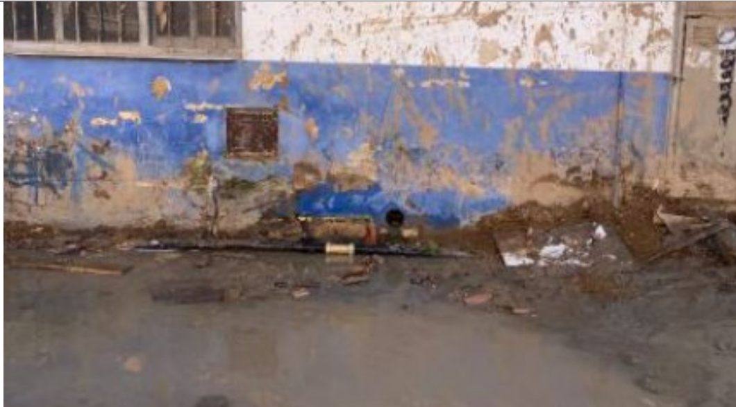
Localización y reparación de fugas de urgencia en el municipio de Beniparrell
