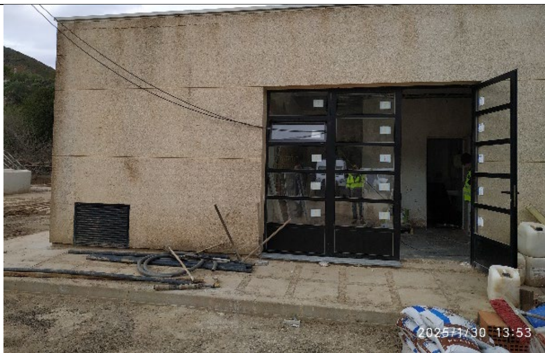
Fachada de entrada al edificio de control
