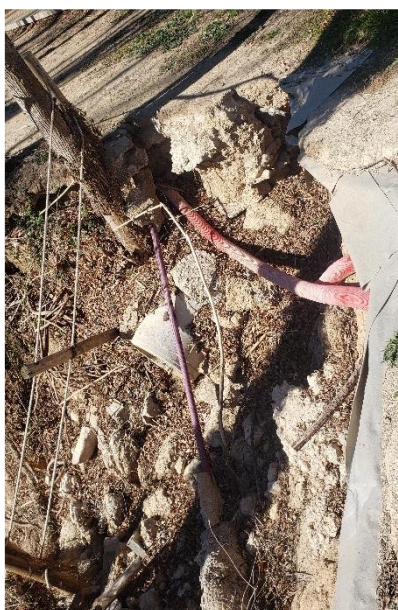
Estado de uno de los tramos finales de colector. Fuente: Visita realizada (03-02-2025).
