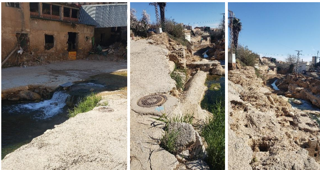
Colector de alcantarillado de la calle Reyes Católicos. Fuente: Visita realizada (03-02-2025).
