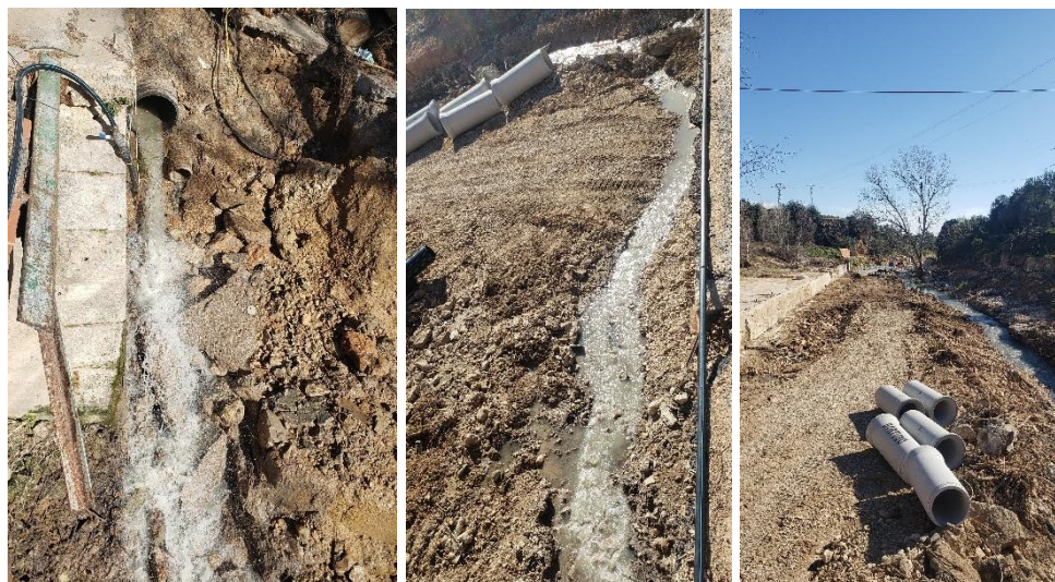
Colector de alcantarillado de la calle Reyes Católicos. Fuente: Visita realizada (03-02-2025).
