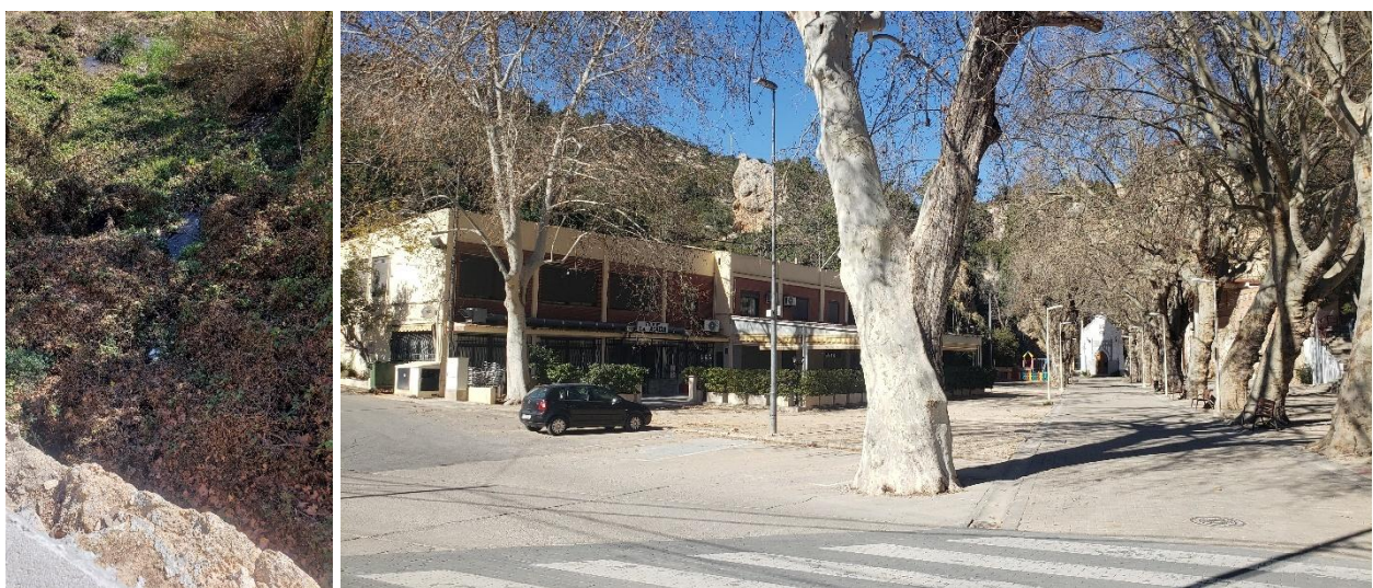
Vertido de agua procedente del colector y edificaciones a las que daba servicio. Fuente: Visita realizada (03-02-2025).
