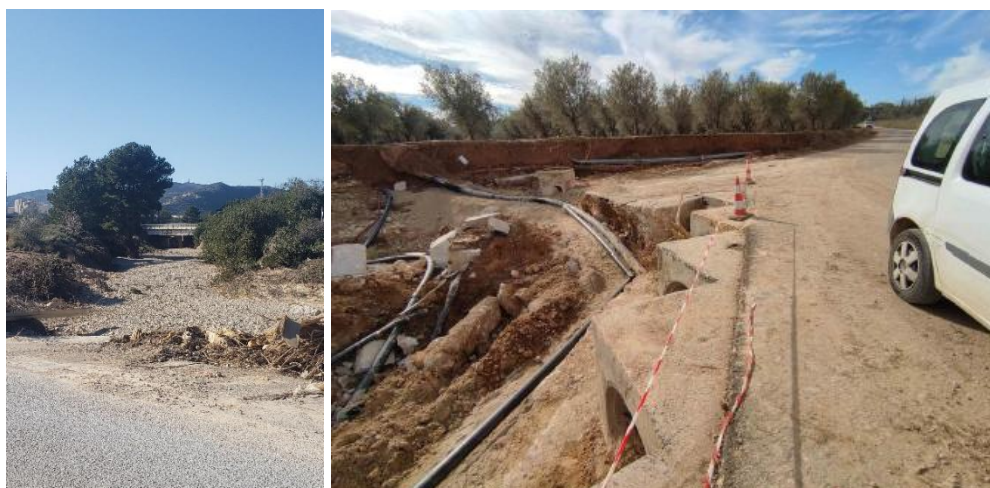
Estado del paso sobre el barranco del Gallo.
