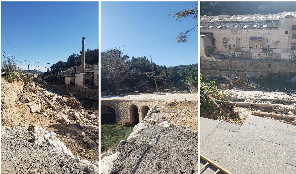
Zona ligeramente aguas arriba del colector. Fuente: Visita realizada (03-02-2025).
