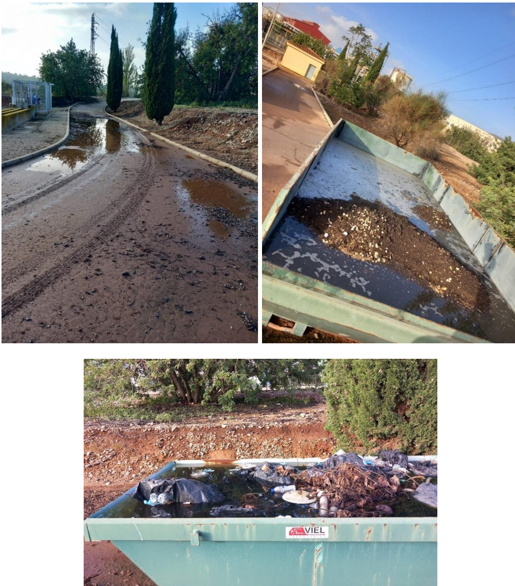
Tareas de limpieza realizadas en la EDAR del P.I. El Llano. Fuente: EGEVASA.
