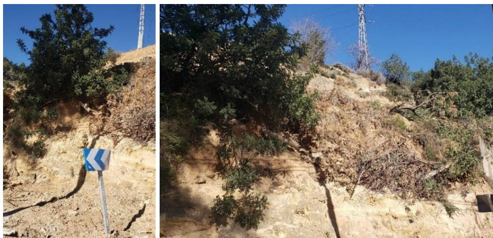
Inspección visual de la conducción. Fuente: Visita realizada (3-02-2025).
