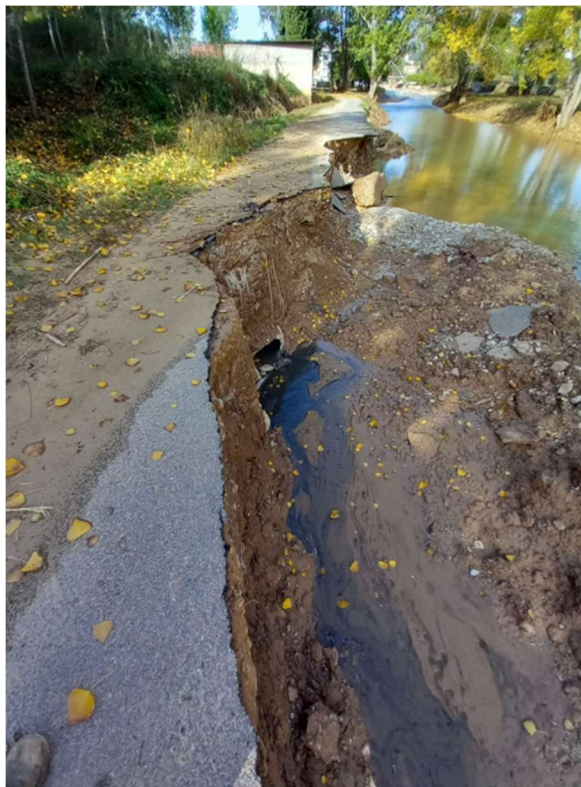
3.- Estado del camino y colector después de Dana
