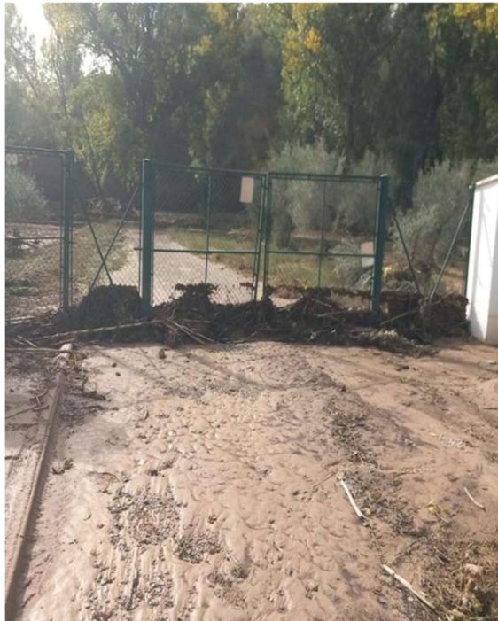
7.- Estado entrada a la Depuradora después de la Dana
