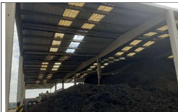
Fotografía 7: Zonas de actuación
