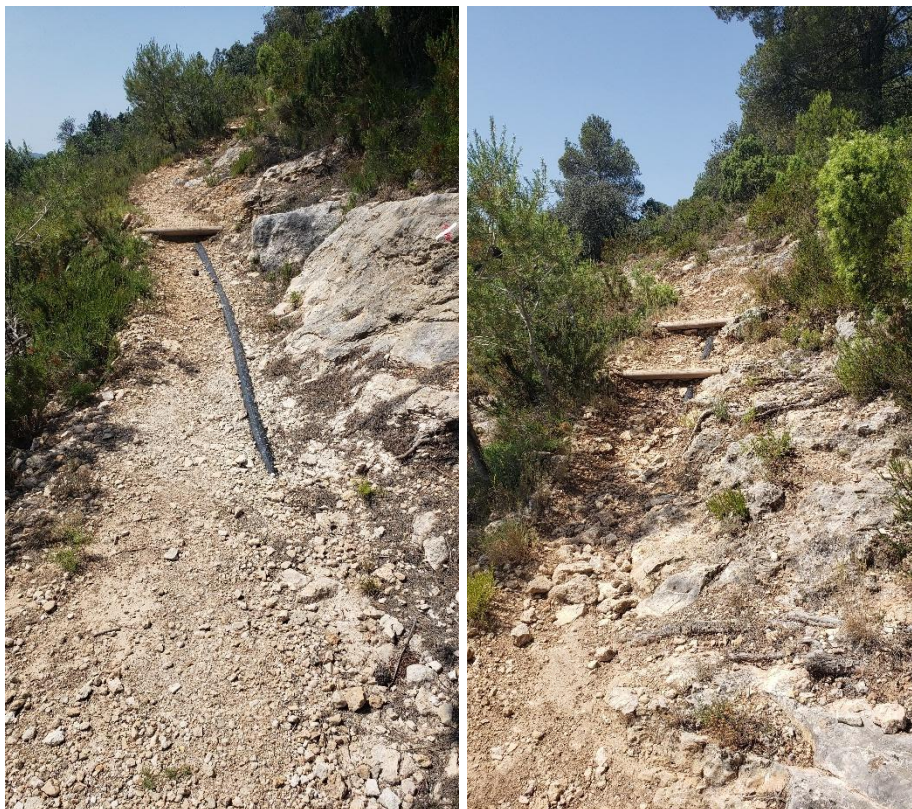
Conducción de derivación hacia el depósito del barranco de la Ermita. Fuente: Visita realizada.
