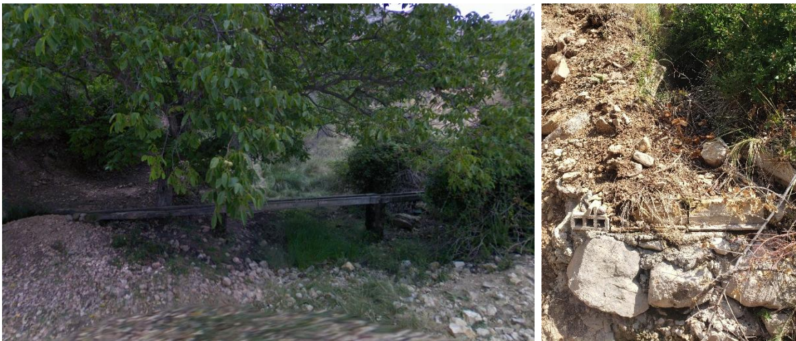
Acequia de fibrocemento. Fuente: Visita realizada.
