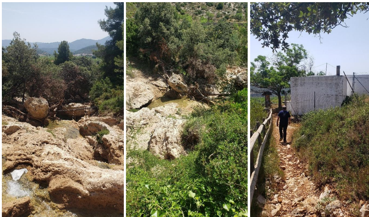
Cruce de la tubería de derivación por el barranco de La Ermita. Visita realizada (18-06-2025).
