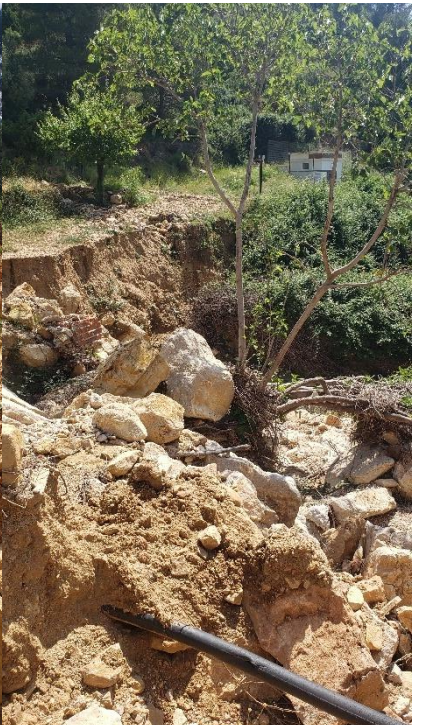
Desprendimientos y erosiones en el camino de ascenso a las captaciones. Fuente: Visita realizada.
