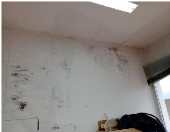
Humedades en el interior del edificio e indicador digital en mal estado
