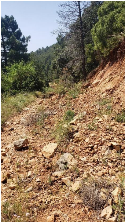
Desprendimientos y erosiones en el camino de ascenso a las captaciones. Fuente: Visita realizada.
