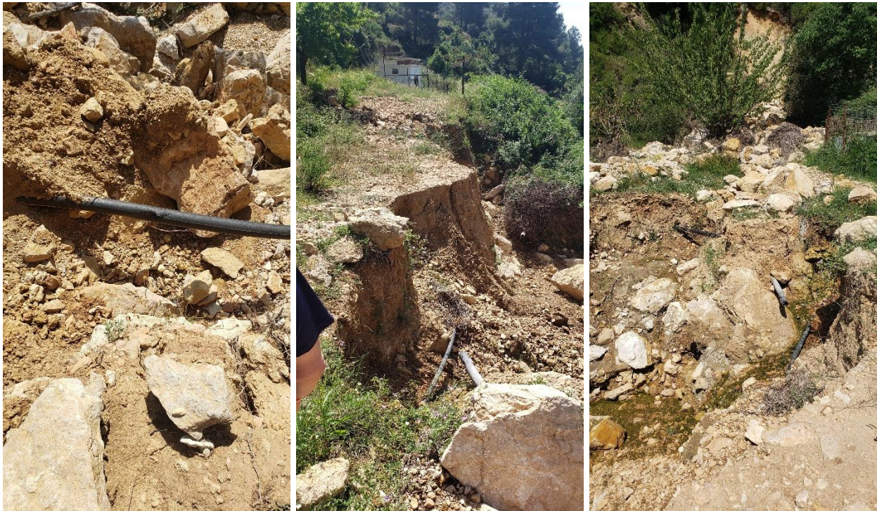
Socavón en la llegada a las captaciones. Fuente: Visita realizada.
