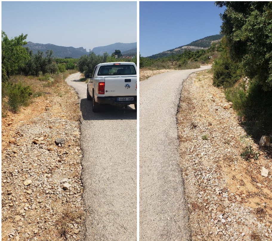
Zanja provisional para la tubería de abastecimiento. Fuente: Visita realizada (18-06-2025).
