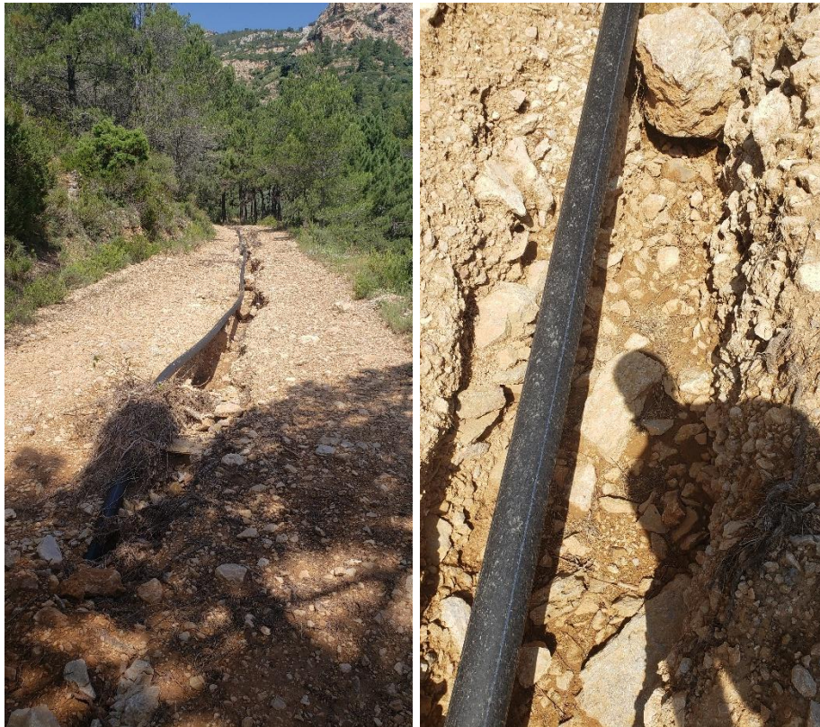
Zanja abierta de la tubería procedente de las captaciones. Fuente: Visita realizada.
