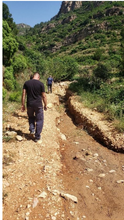
Desprendimientos y erosiones en el camino de ascenso a las captaciones. Fuente: Visita realizada.
