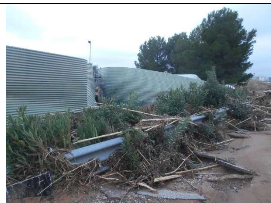
Imagen 15: Estado de las balsas de homogenización
