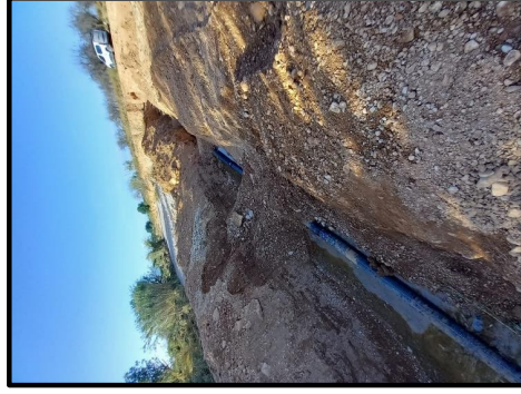
Fotografía nº 1. Estabilización de talud zona tubería afectada
