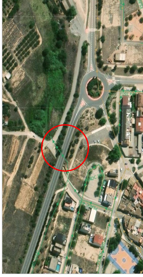
Fig. 1. Emplazamiento de la infraestructura afectada (Cheste, Valencia)
