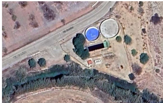
Imagen 3: Vista aérea de la EDAR de Cheste Circuito Ricardo Tormo (Valencia)
