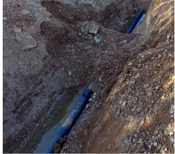
4.- Montaje tubería provisional AP para urb Aguas Perdías
