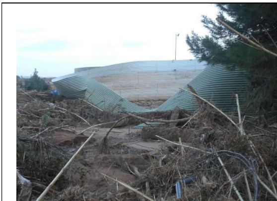
Imagen 14: Estado de las balsas de homogenización
