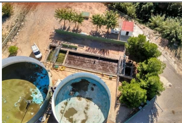
Vista general EDAR.
