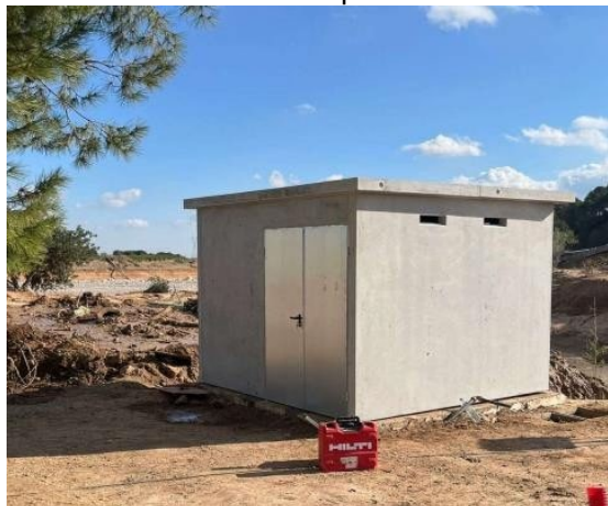
26.-Instalación de caseta prefabricada
