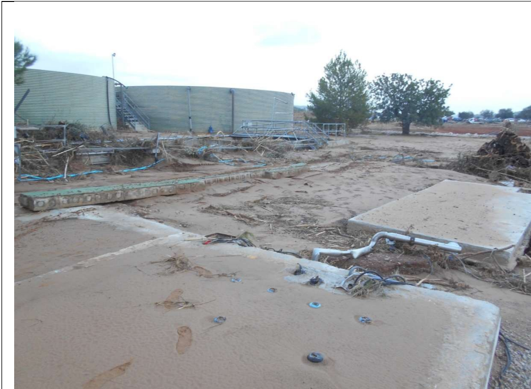
Imagen 11: Vista interior de la instalación. A la izquierda reactor biológico y balsas de homogenización y a la derecha ubicación de casetas.
