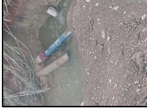
Fotografía nº 4. Reparación tubería afectada. Detalle 3
