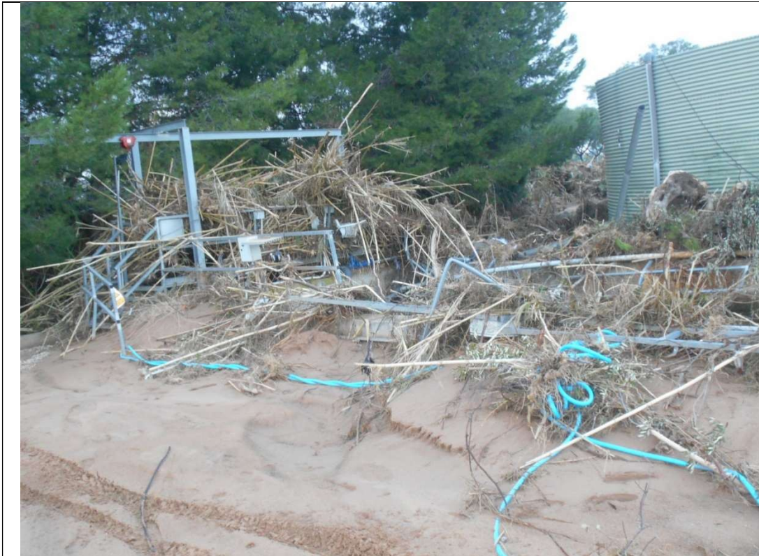
Imagen 13: Pretratamiento e impulsión del agua bruta al reactor biológico y reactor biológico
