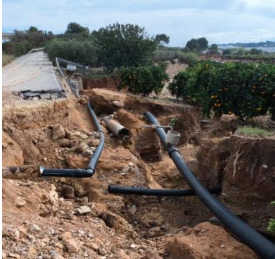
3.- Estado tubería Urb Aguas Perdidas después de Dana
