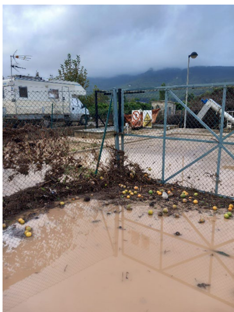
Imagen 5: Daños EBAR Corbera
