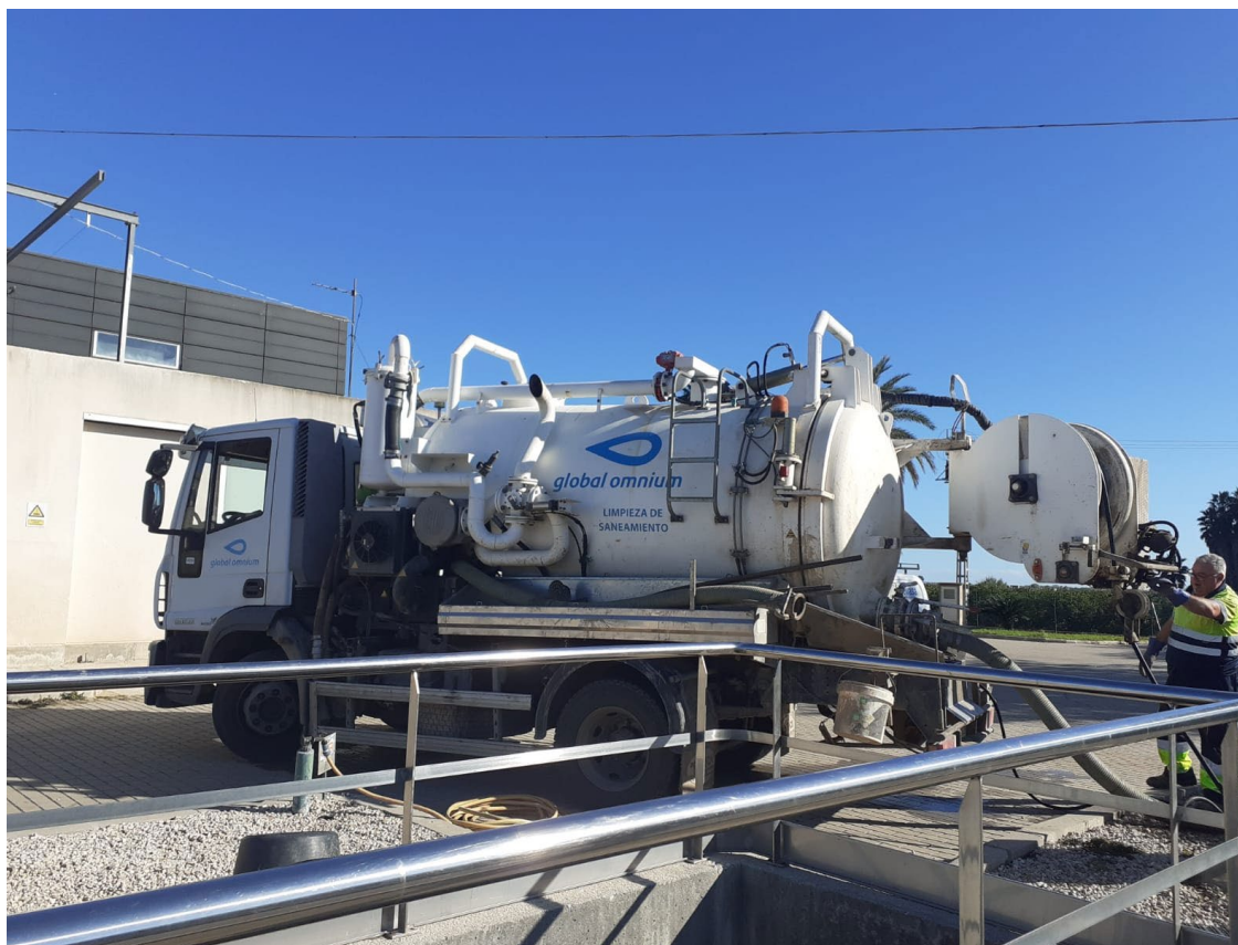
Imagen 4: Limpieza del colector de Llaurí. FASE 0
