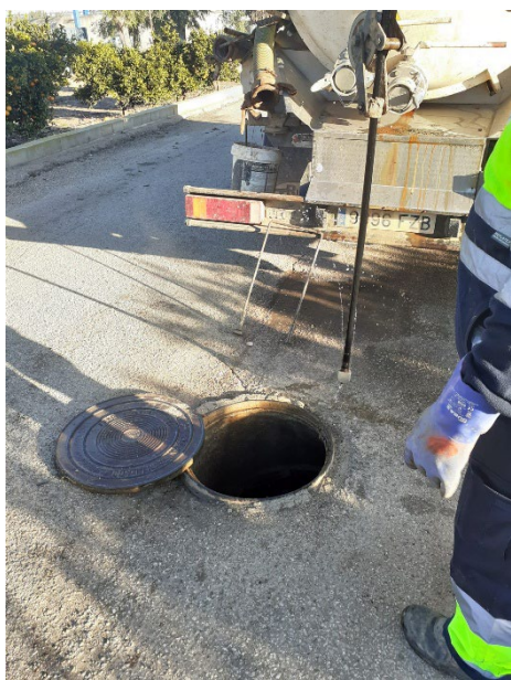
Imagen 2: Limpieza del colector de Llaurí. FASE 0
