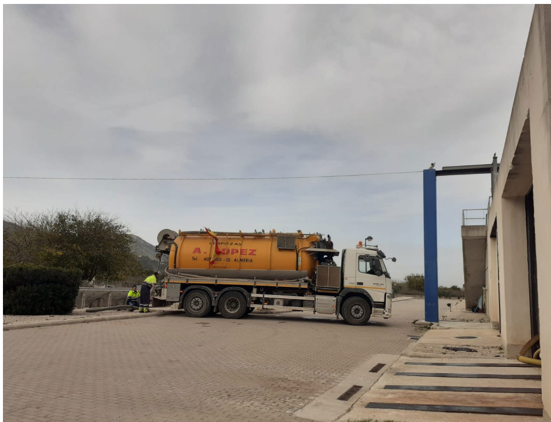
Imagen 1: Limpieza del colector de Llaurí. FASE 0
