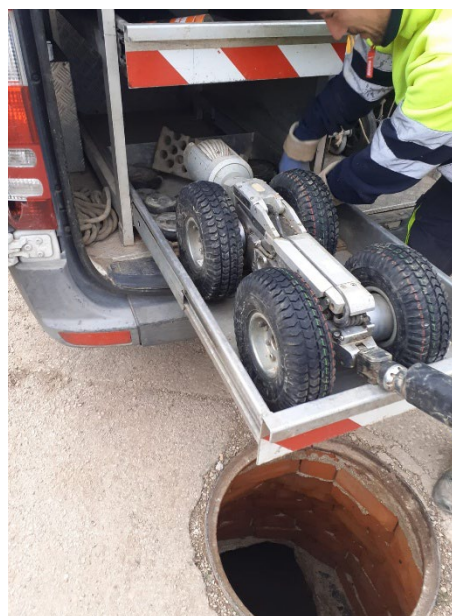
Imagen 3: Inspección CCTV colector Llaurí. FASE 0
