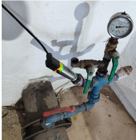
Transductor de presión reemplazado
