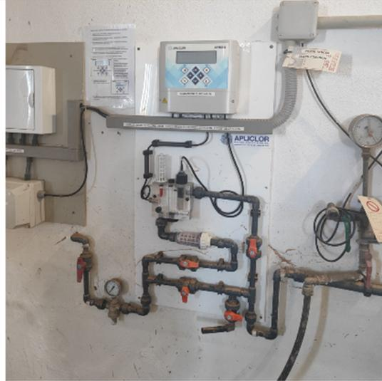
Analizador de cloro afectado por la inundación
