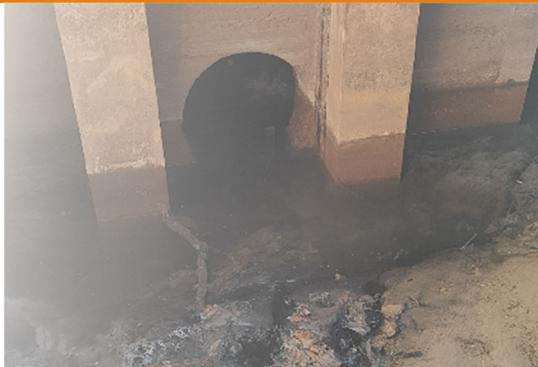
Fugas e infiltraciones del ovoide
