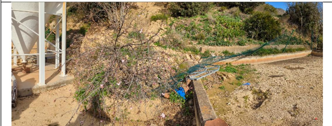
Vallado perimetral derrumbado por deslizamientos.
