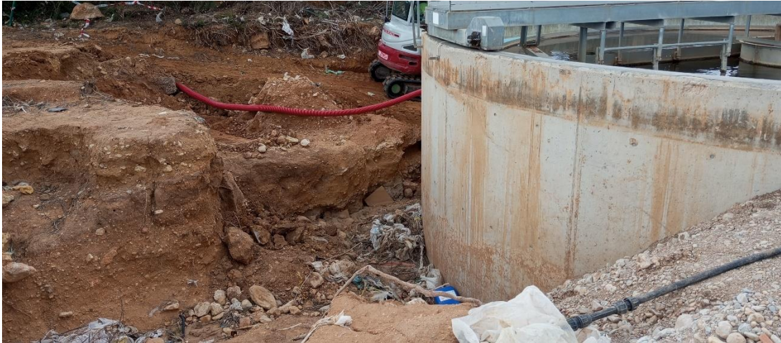
Imagen 10: Estado terreno EDAR
