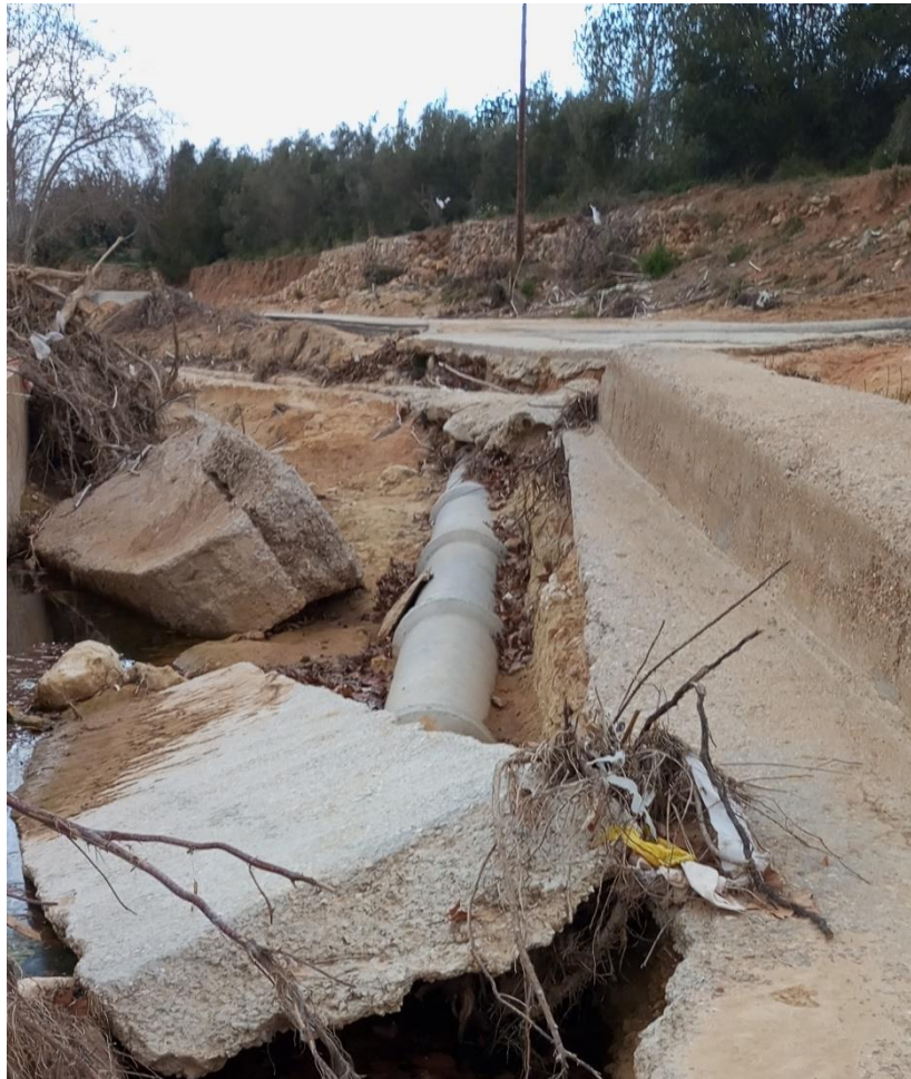
Imagen 14: Estado Colector general
