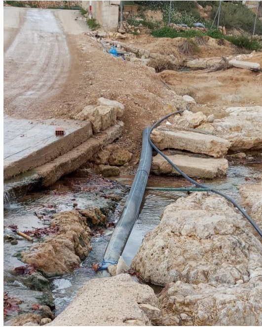
Imagen 13: Conducción de Impulsión
