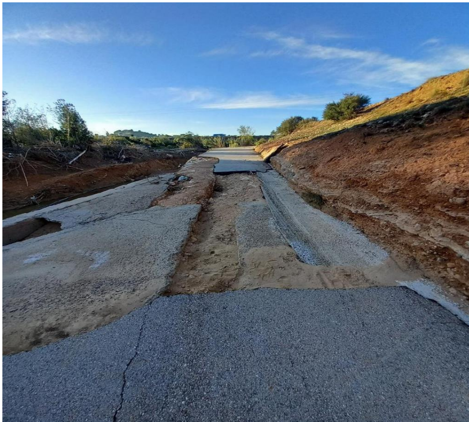
Imagen 4: Estado camino de acceso
