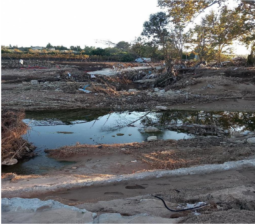
Imagen 5: Vertido de aguas residuales del Colector
