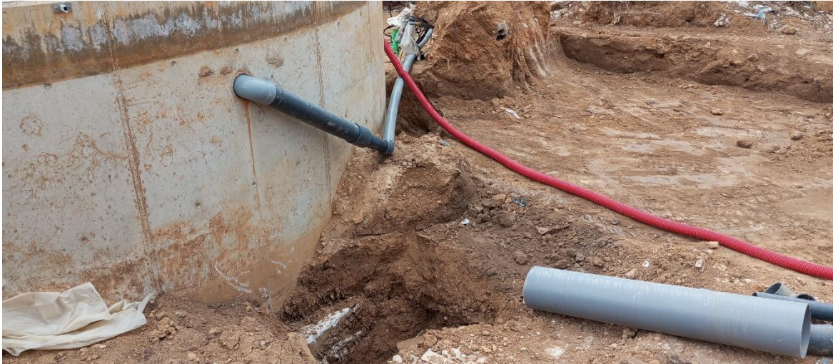
Imagen 7: Decantador descalzado al completo
