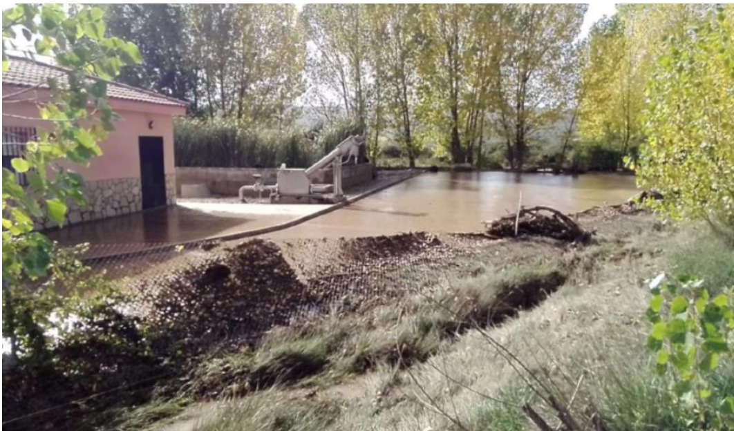
Imagen 2: Inundaciones en la EDAR de Mira
