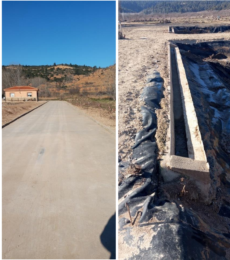
Imagen 7: Trabajos iniciados. Limpiezas, vallados. Estado lamina FMF
