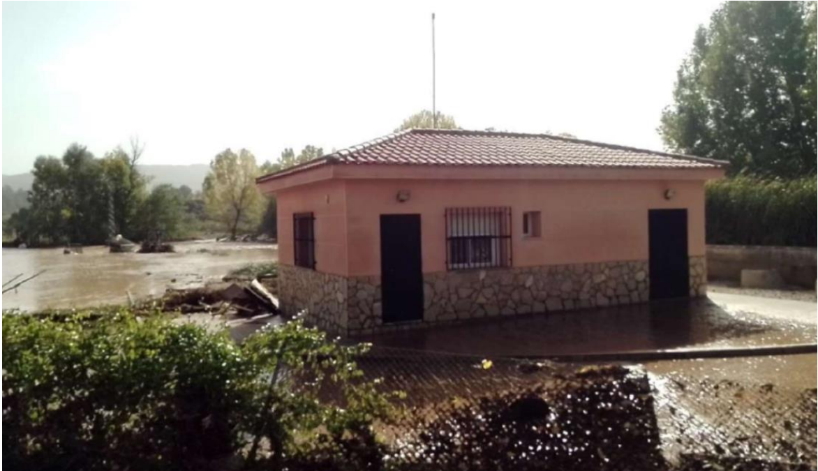
Imagen 3: Inundaciones en la EDAR de Mira
