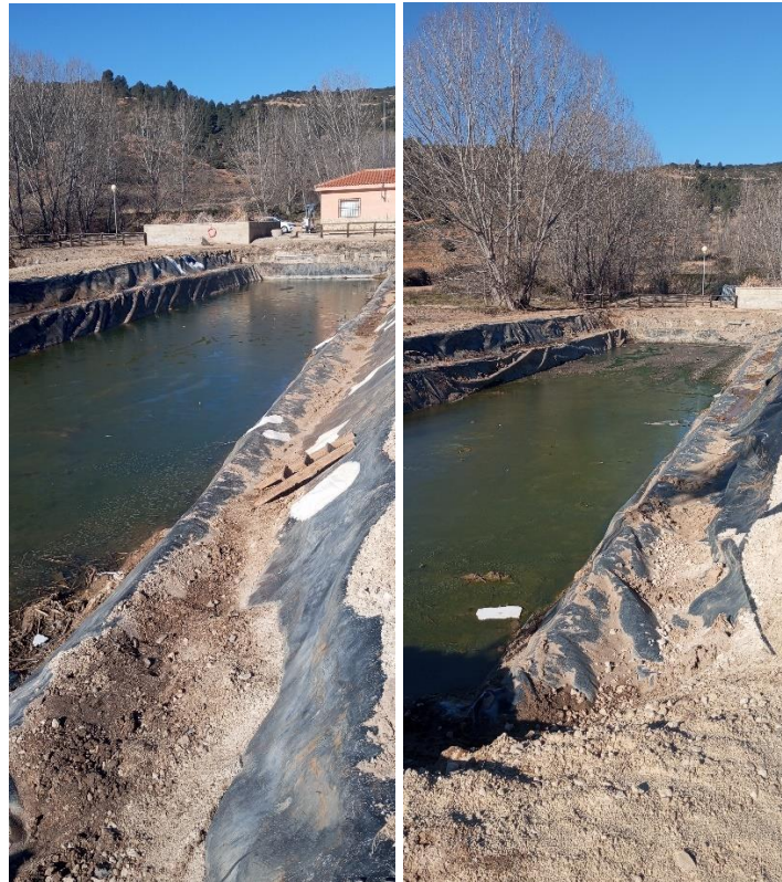
Imagen 8: Trabajos iniciados. Limpiezas, vallados. Estado lamina FMF
