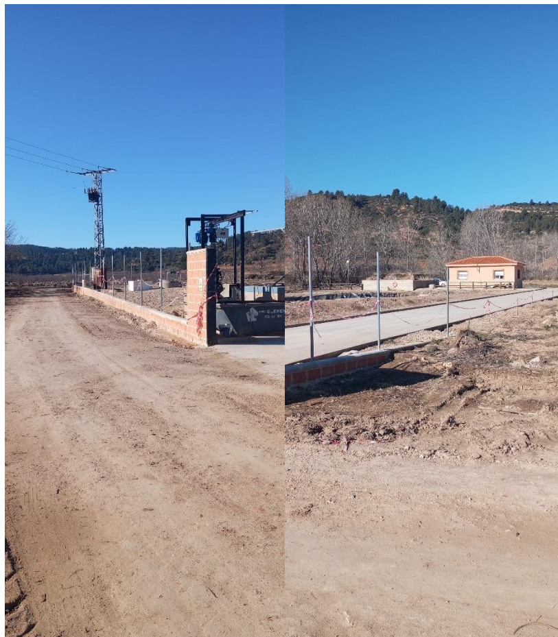
Imagen 6: Trabajos iniciados. Limpiezas, vallados
