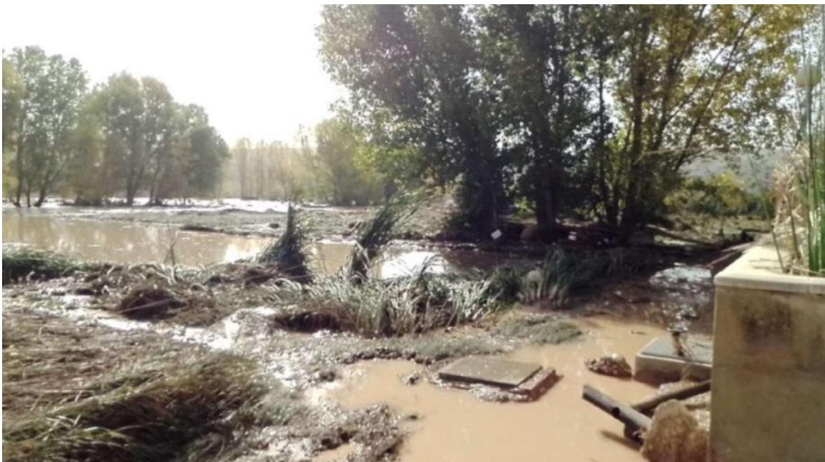
Imagen 4: Inundaciones en la EDAR de Mira
