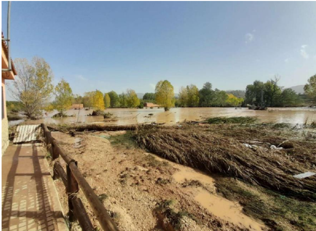
Imagen 5: Inundaciones en la EDAR de Mira
