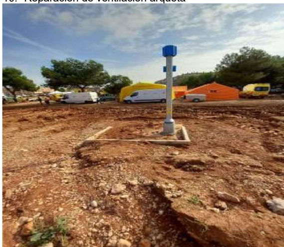
10.- Reparación de ventilación arqueta
