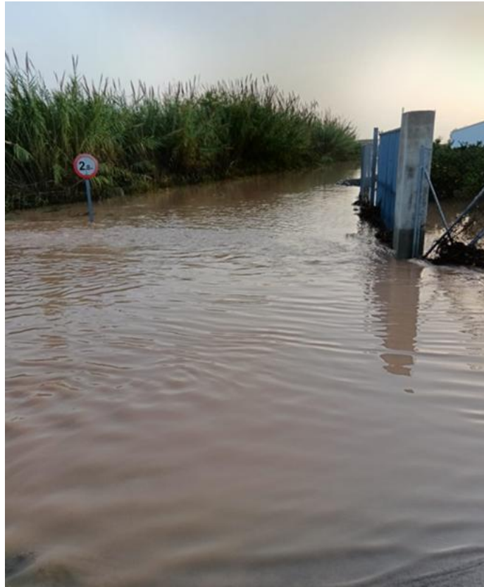
Inundación del camino de acceso a la depuradora.
