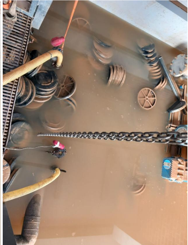
Graves daños por la inundación de equipos en la sala de soplantes.
