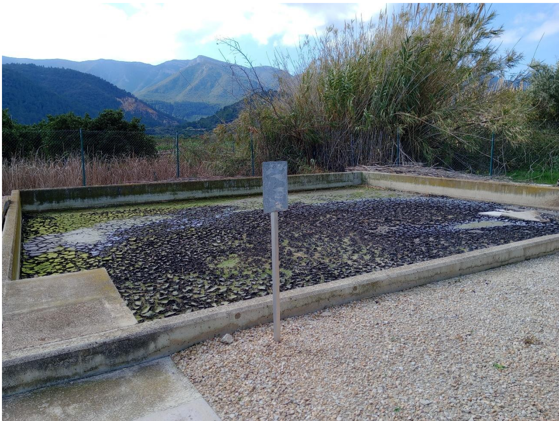
8 SUSTITUCIÓN DE LA GRAVILLA DE LA ERA DE SECADO DE FANGOS
