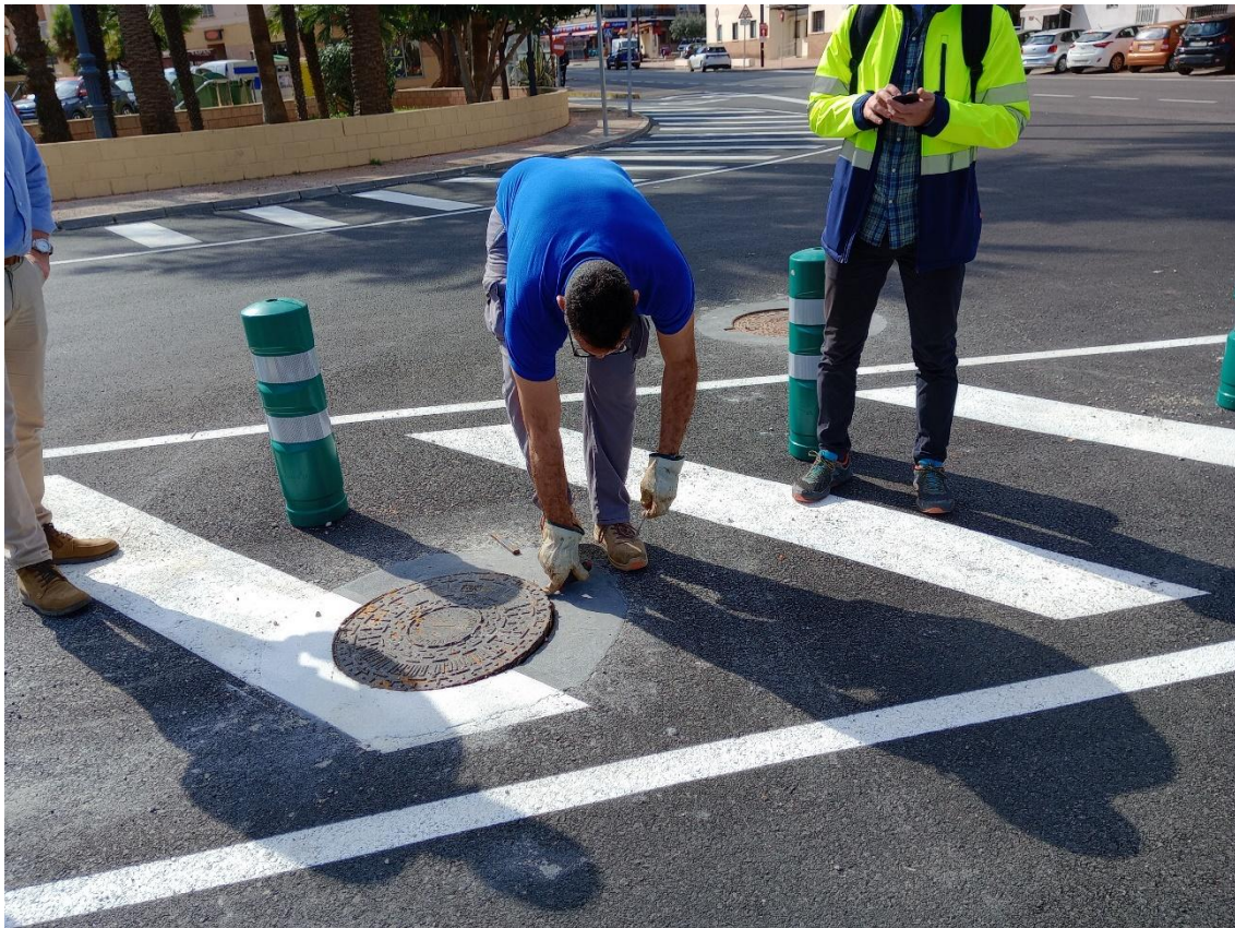
12 COLECTOR CERCA DE LA CARRETERA N-332
