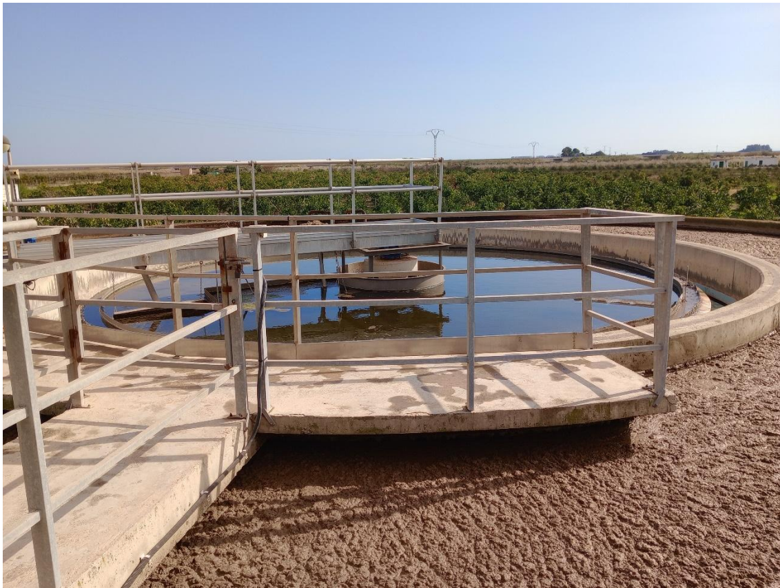
9 DETALLE DEL DECANTADOR
