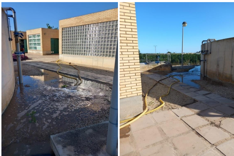
Achique en la parcela de la depuradora.
