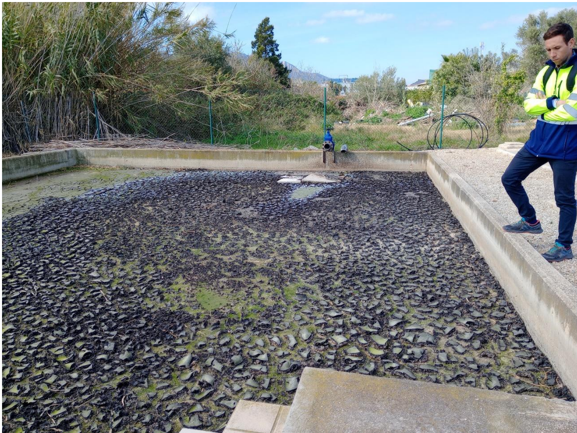
8 DETALLE DE ERA DE SECADO DE FANGOS
