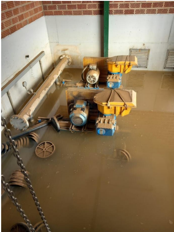
Graves daños por la inundación de equipos en la sala de soplantes.
