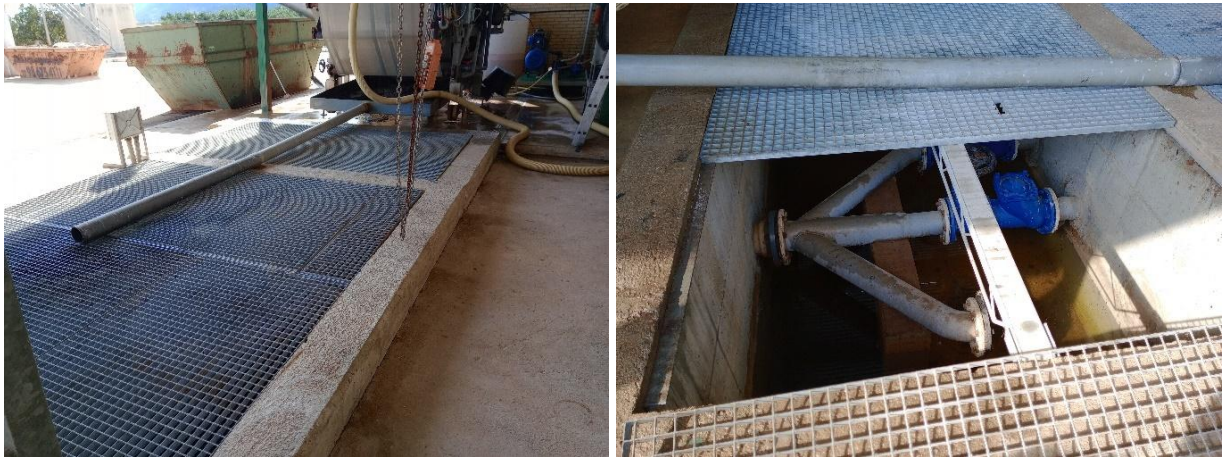
Detalles del foso de bombas
