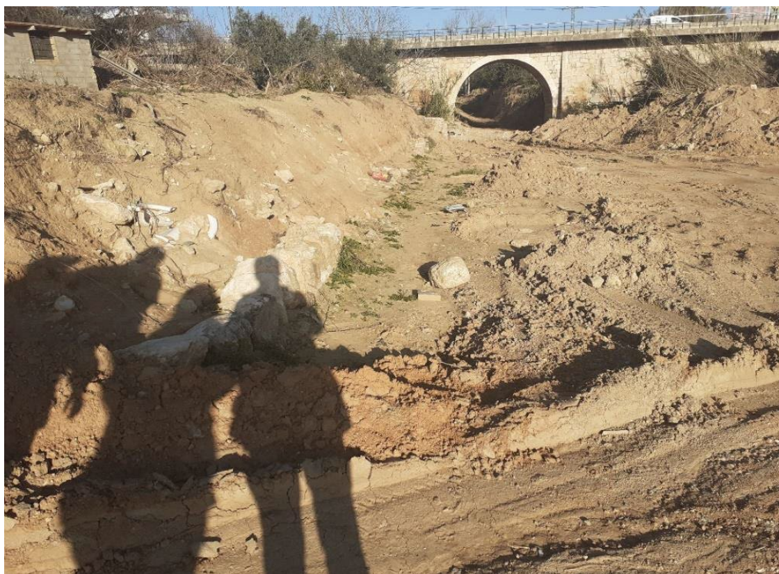
Imagen 6: Tramo inicial del colector barranco Murtal
