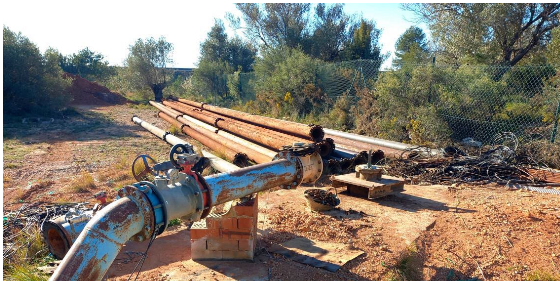
Imagen 5: Reparación del pozo La Solana
