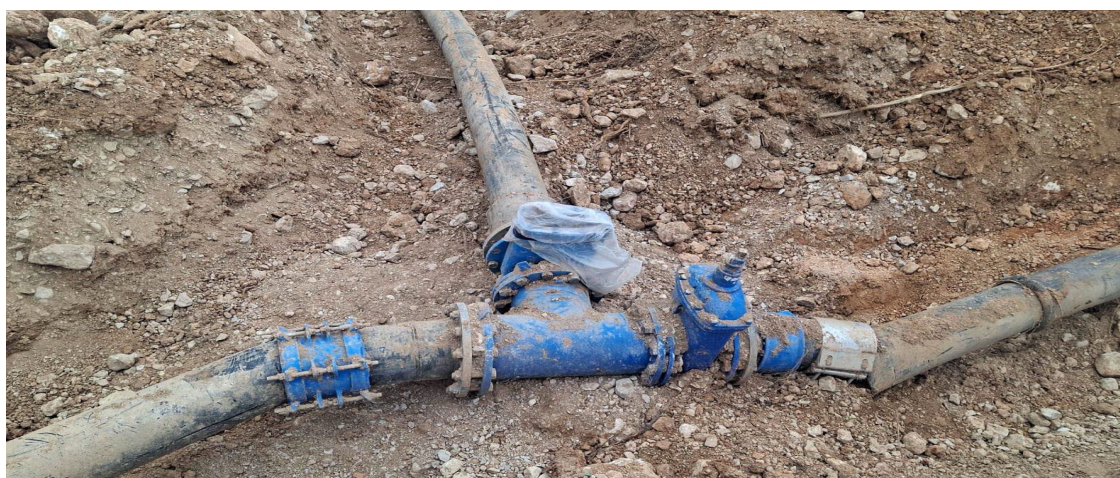
Imagen 2: Conducción provisional pozo La Solana
