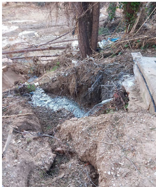
Imagen 8: Vertido EDAR Calicanto
