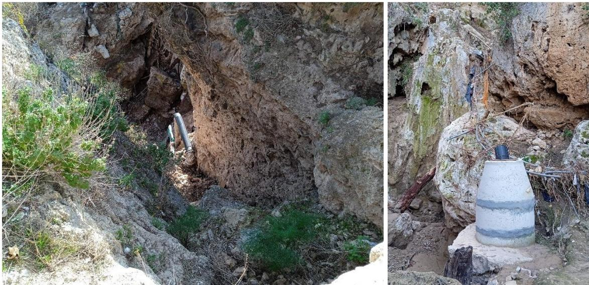
*Daños en el colector de salida del municipio. Fuente: Proyecto 79.*
