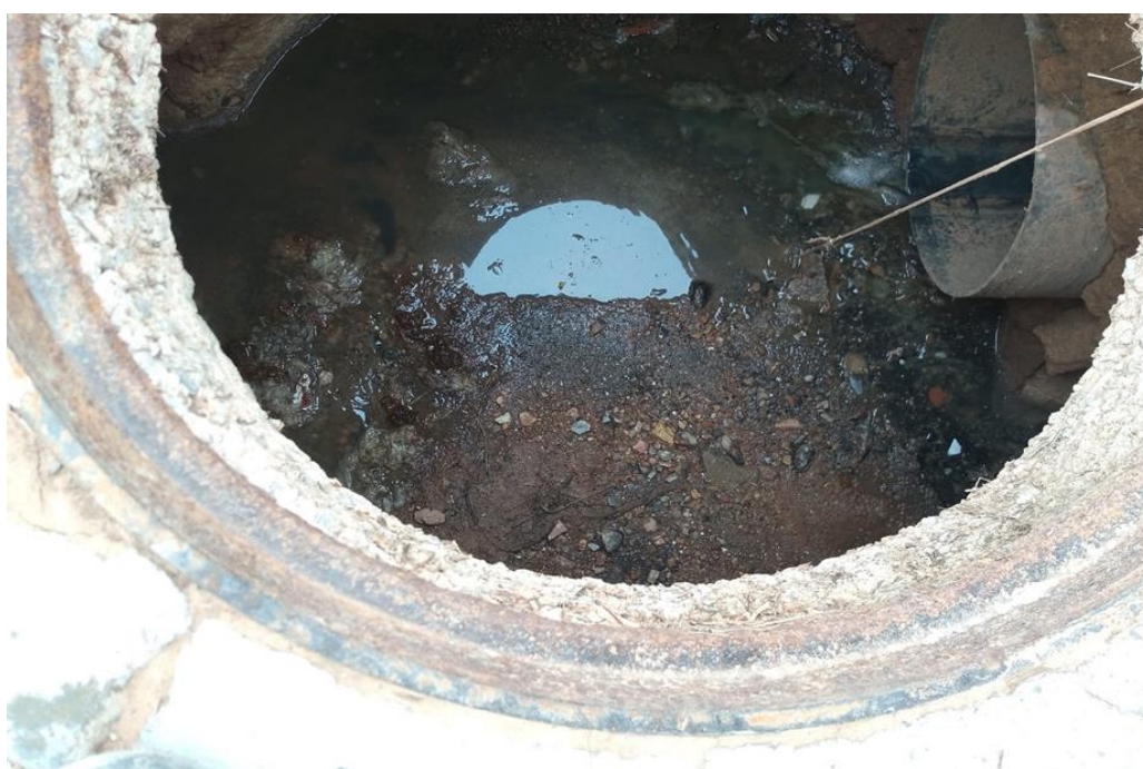
Figura 11. Limpieza pozos de registro
