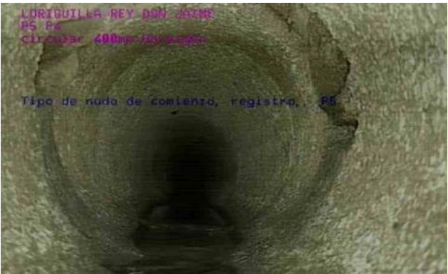
Figura 5. Desprendimiento en paredes colector.
