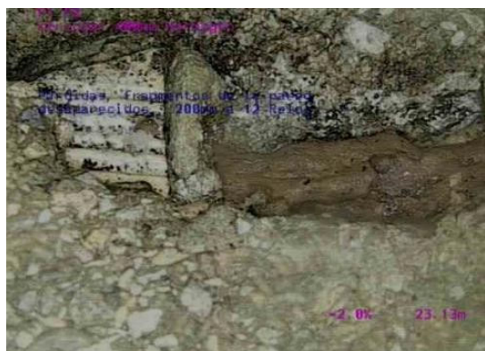
33.- y 34.-Fragmentos desprendidos del colector por la fuerza y presión del agua
