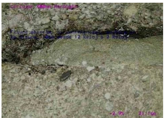
33.- y 34.-Fragmentos desprendidos del colector por la fuerza y presión del agua
