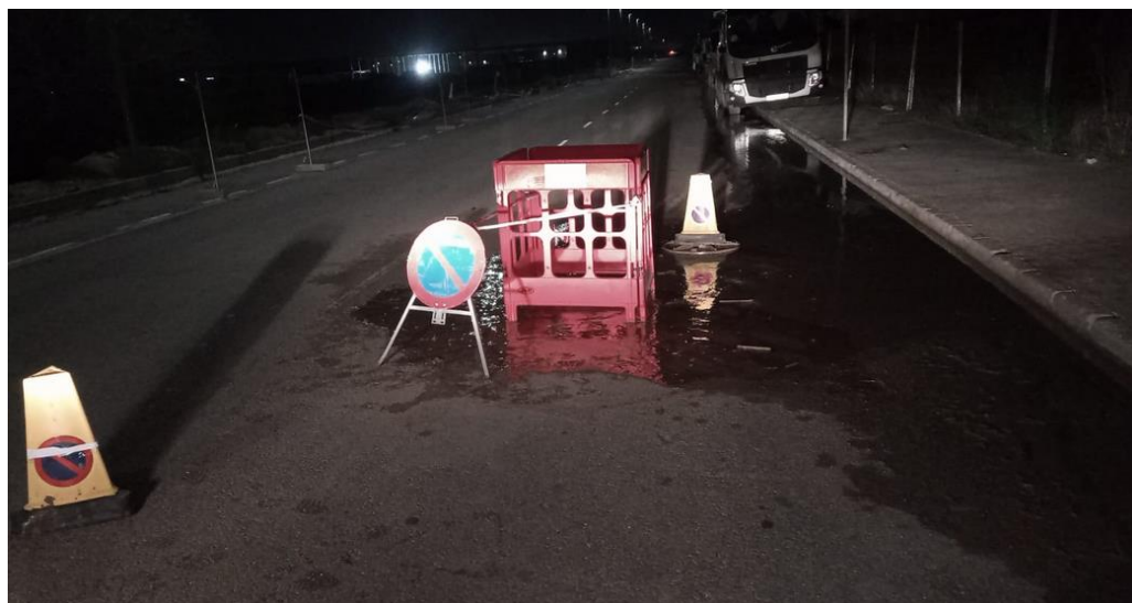
Figura 7. Emboce red general por acumulación de fangos
