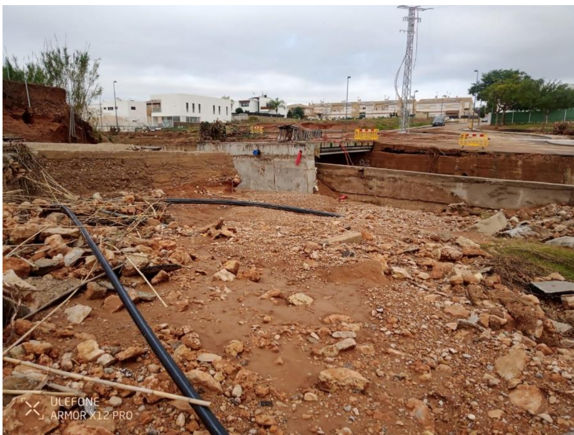
Figura 3. Vista de la tubería general a renovar por el barranco del Pozolet
