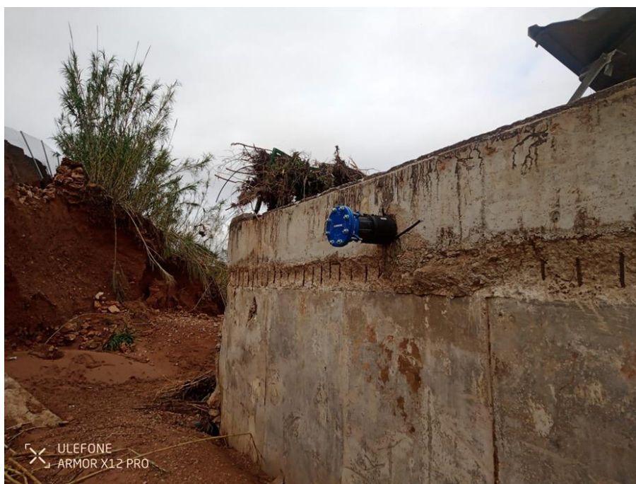
Figura 1. Vista del tapón instalado en la tubería de distribución y el puente que cruza el barranco
