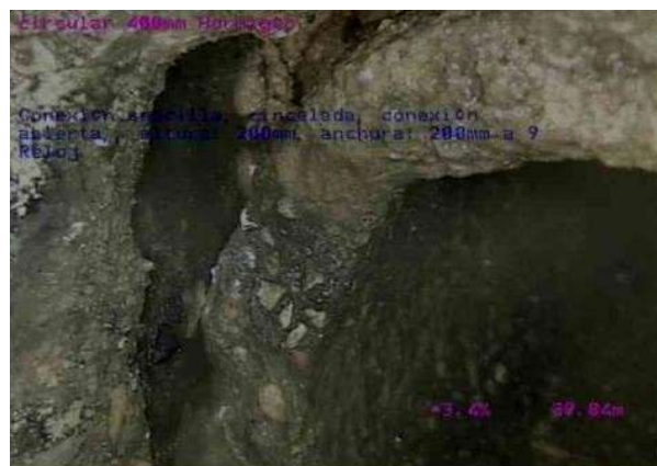
Figura. Desplazamiento lateral en conexión.
