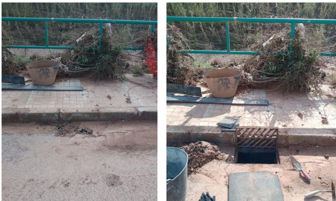
Figura 10. Limpieza imbornales zona barranco
