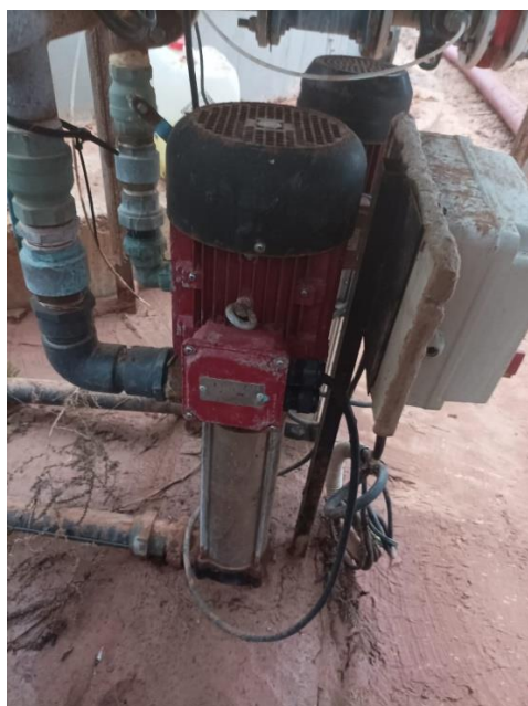
Bombas de agua reutilizada antes de la limpieza
