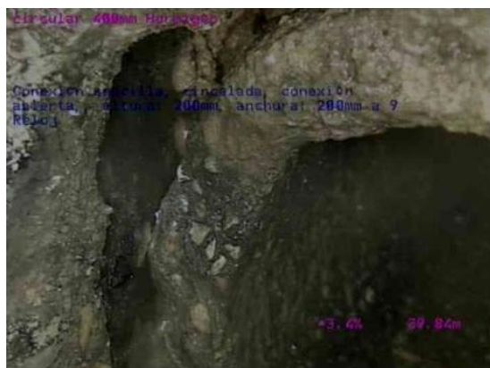
35.- Desplazamiento lateral en conexión.
