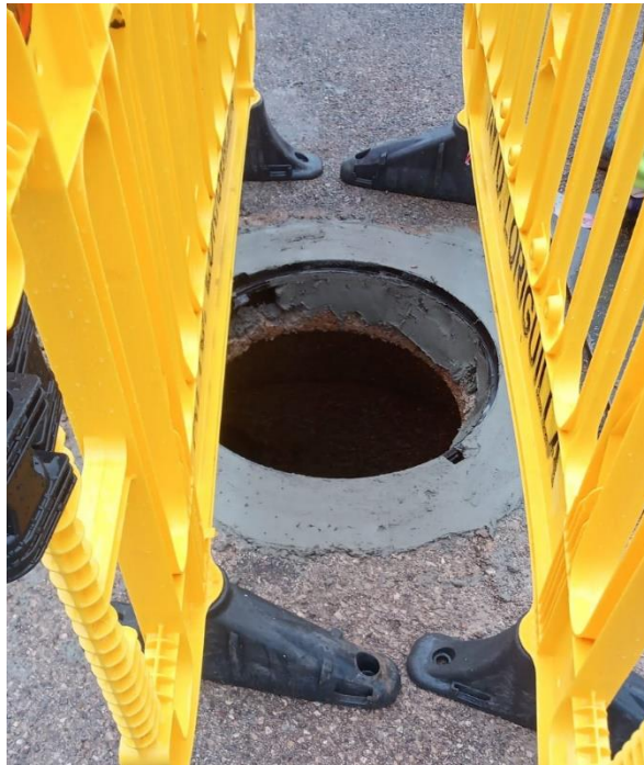
Figura 5. Trabajos de reparación de las trapas de pozos de registro afectadas
