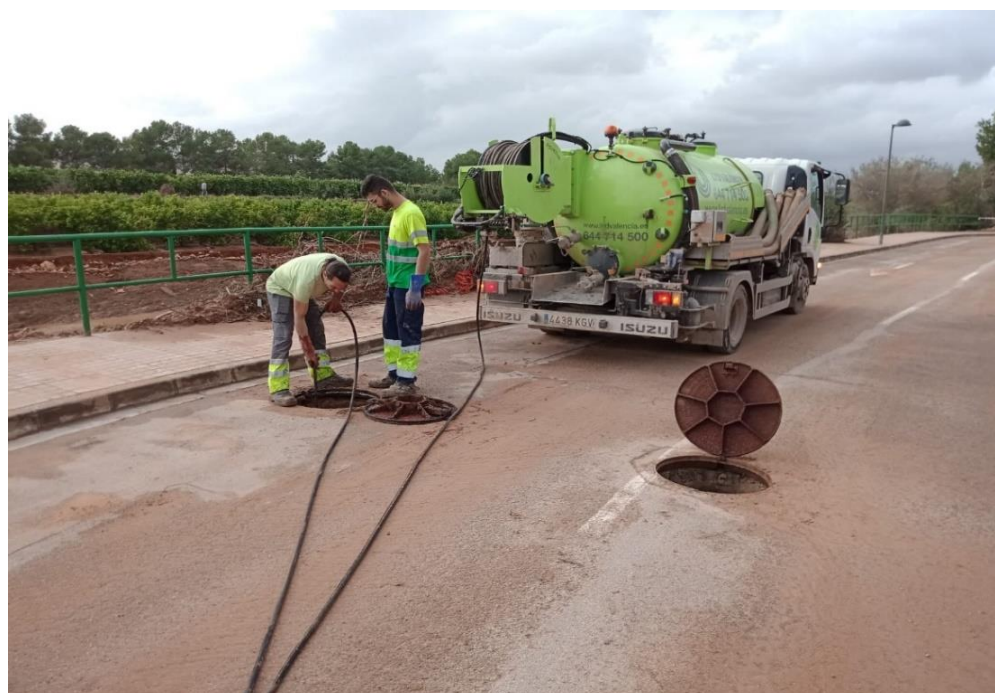
Figura 8. Limpieza mediante camión cisterna red general colectores saneamiento.
