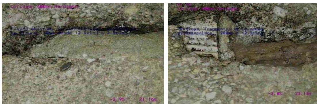
Figura 3. Fisuras > 10mm de ancho en distintos colectores del P3 al P4
