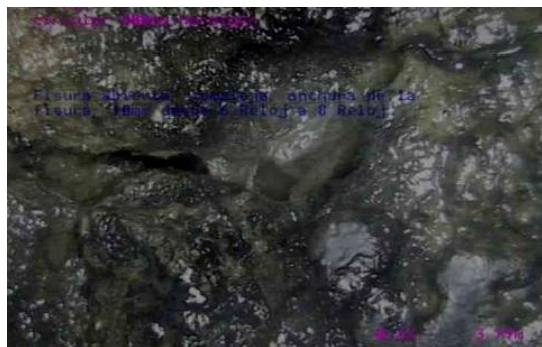
32.-y 33.- > 10mm de ancho en distintos colectores del P3 al P4
