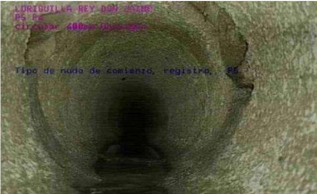
Figura 5. Desprendimiento en paredes colector.
