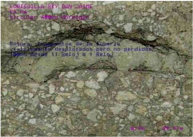
Figura 5. Desprendimiento en paredes colector.
