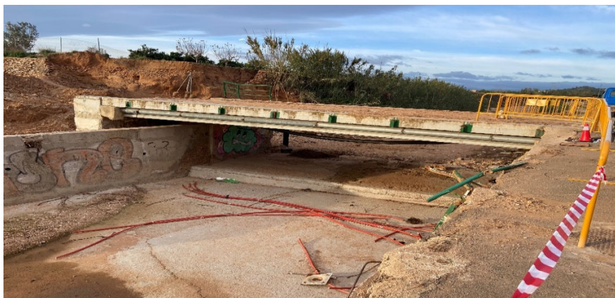
27.- Estado del puente 05 de Febrero 2025
