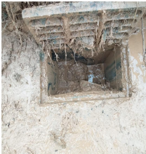
30.-Ejemplo del estado de imbornales después de la Dana
