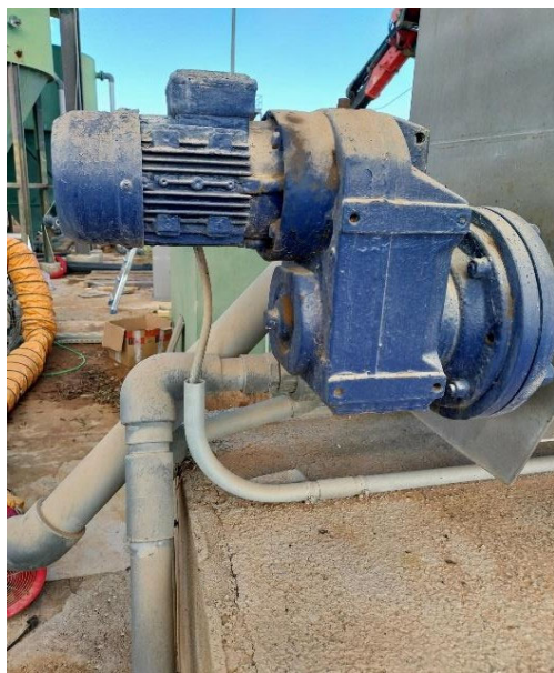
15.-MOTORRECUTOR DESARENADOR
