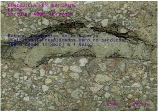
Figura 5. Desprendimiento en paredes colector.
