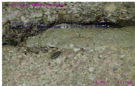
32.-y 33.- > 10mm de ancho en distintos colectores del P3 al P4
