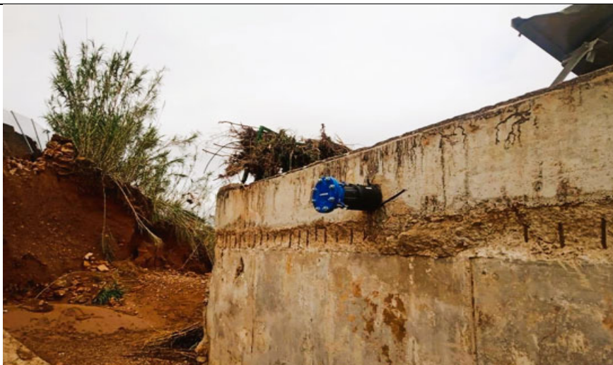
26.- Desde este punto se conectara la nueva tubería de Polietileno DN 160
