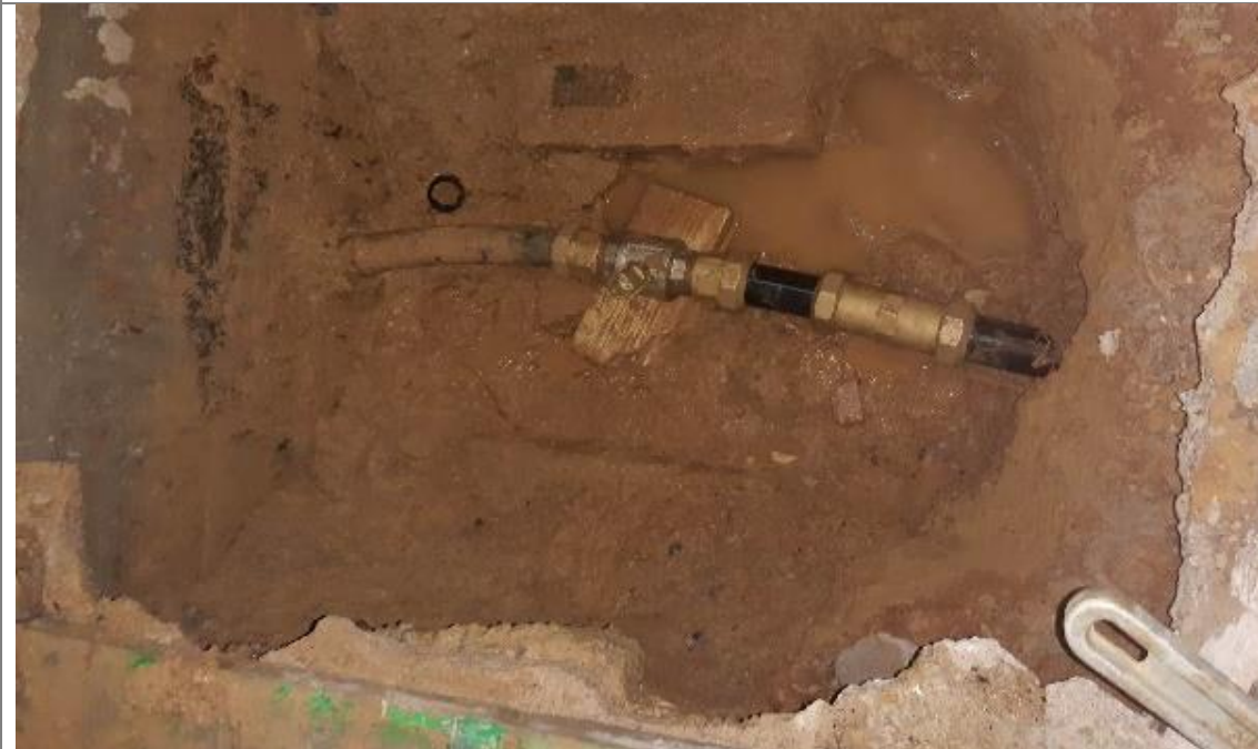
Reparación provisional de tubería de abastecimiento en la calle Vall de Abadía
