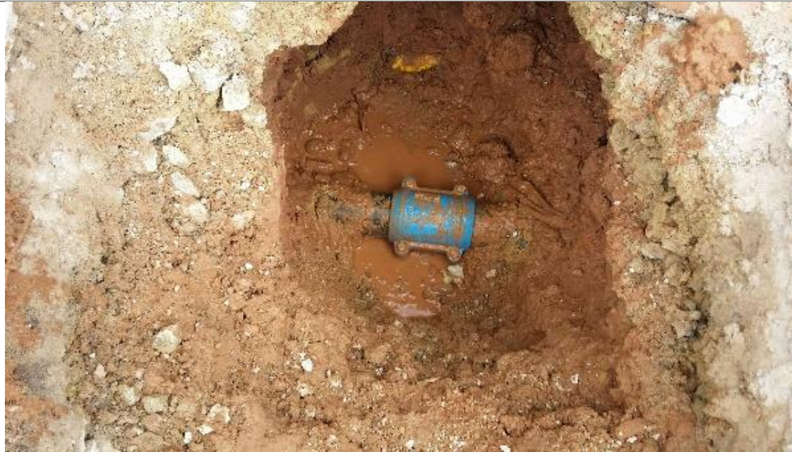
Reparación provisional de tubería de abastecimiento en la calle Vicente B.I:
