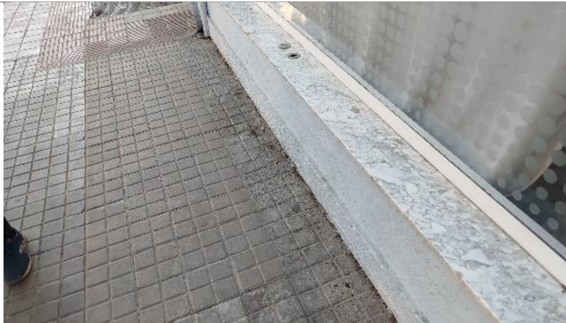
Detalle de pavimento repuesto por la avería en la calle Vall de Abadía
