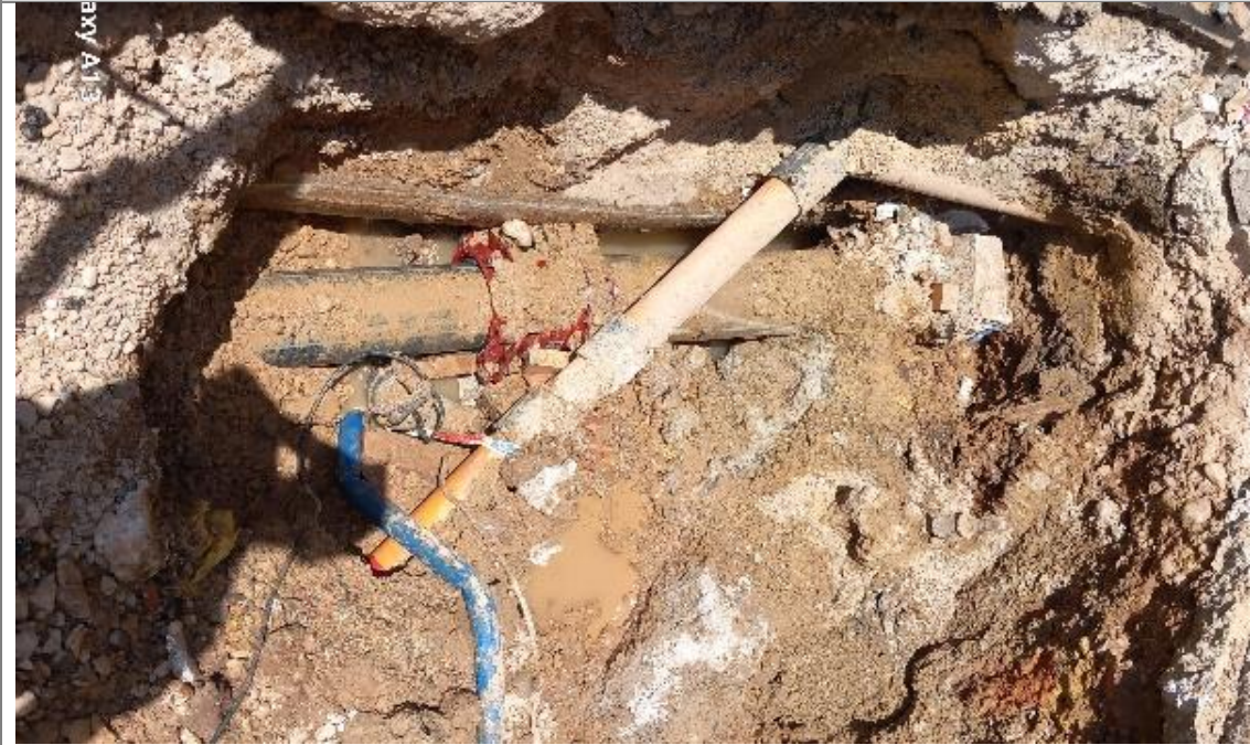
Reparación provisional de tubería de abastecimiento en la calle Lepanto
