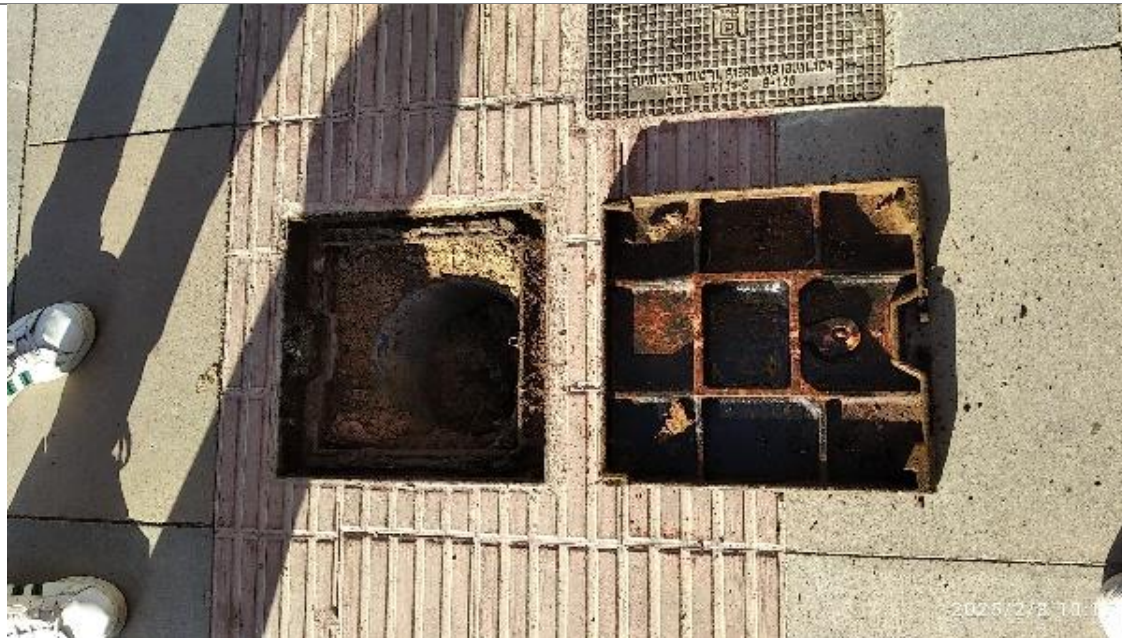
Apertura de arqueta de acometida a renovar en la calle Vall de Abadía
