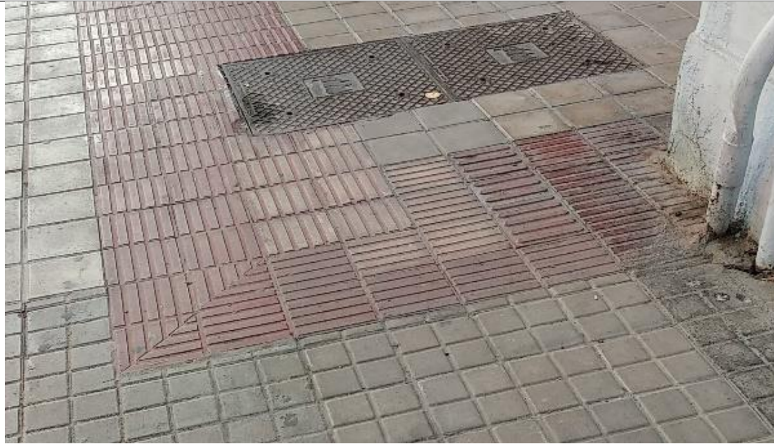
Detalle de pavimento repuesto por la avería en la calle Vicente Salvatierra
