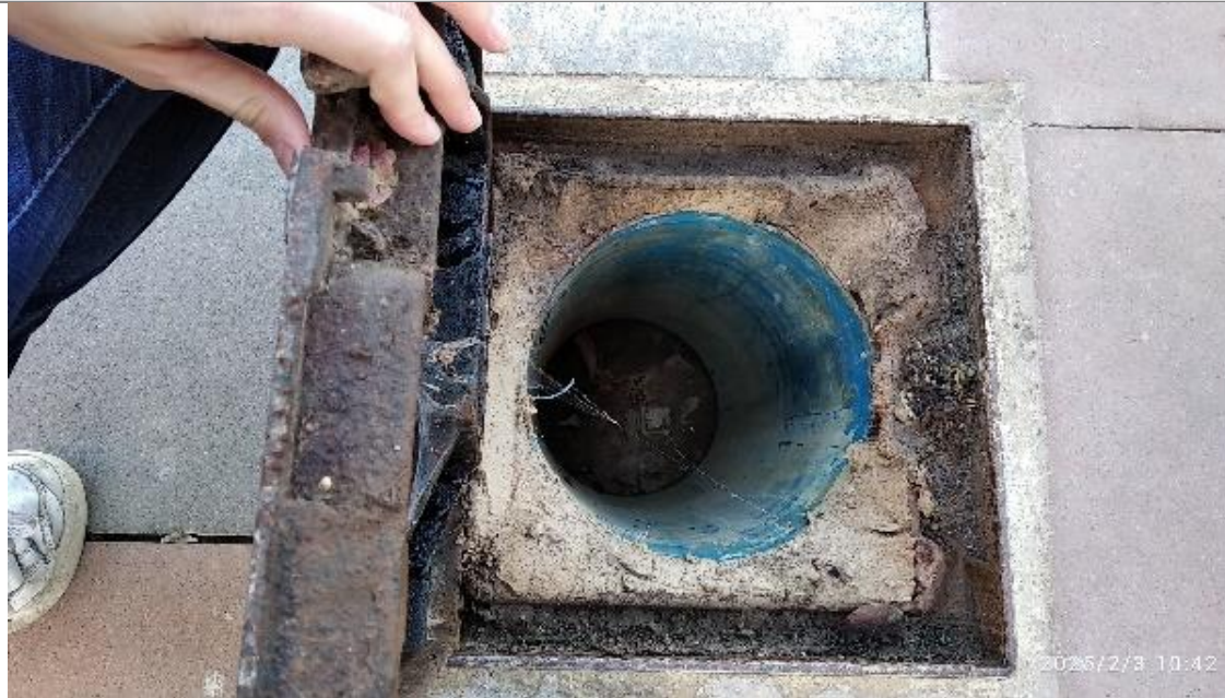
Detalle de acometida a renovar en la calle Vicente B.I.
