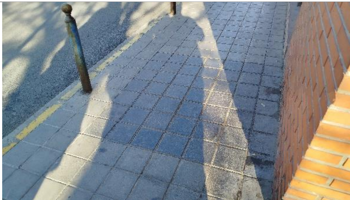
Detalle de pavimento repuesto por la avería en la calle Lepanto
