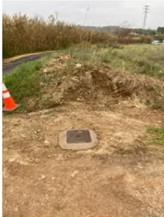
Imagen 2: Arqueta para alojamiento de Válvula bypass montserrat
