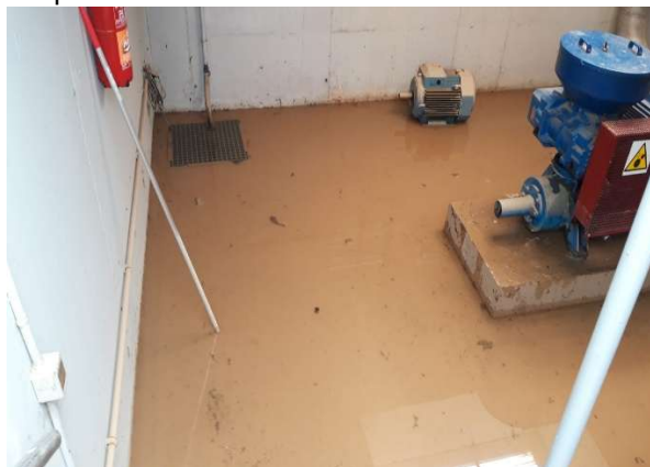
11.- Sala Bombas soplantes EDAR Real después de Dana
