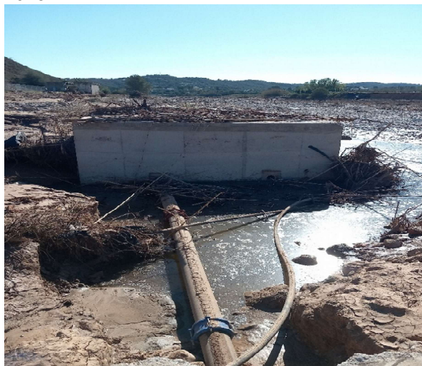
11.- Sala Bombas soplantes EDAR Real después de Dana
