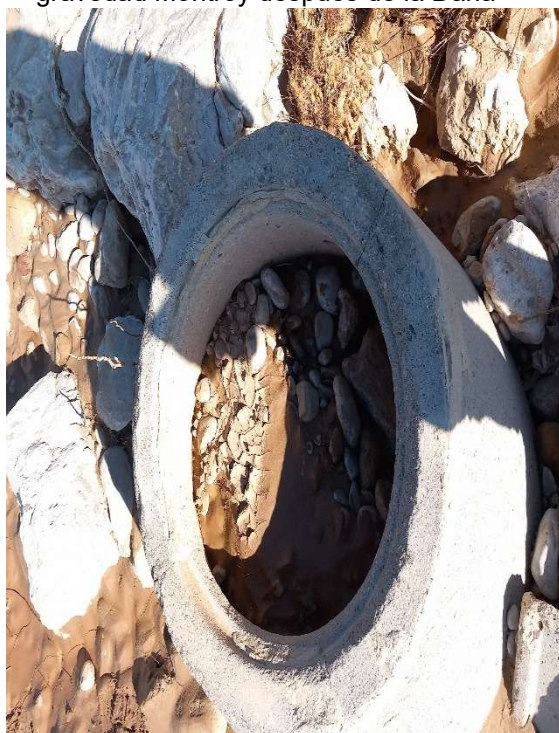
7.- Estado de los pozos de registro colector gravedad Montroy después de la Dana
