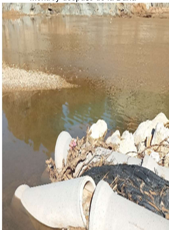
8.- Estado del colector por gravedad Montroy después de la Dana
