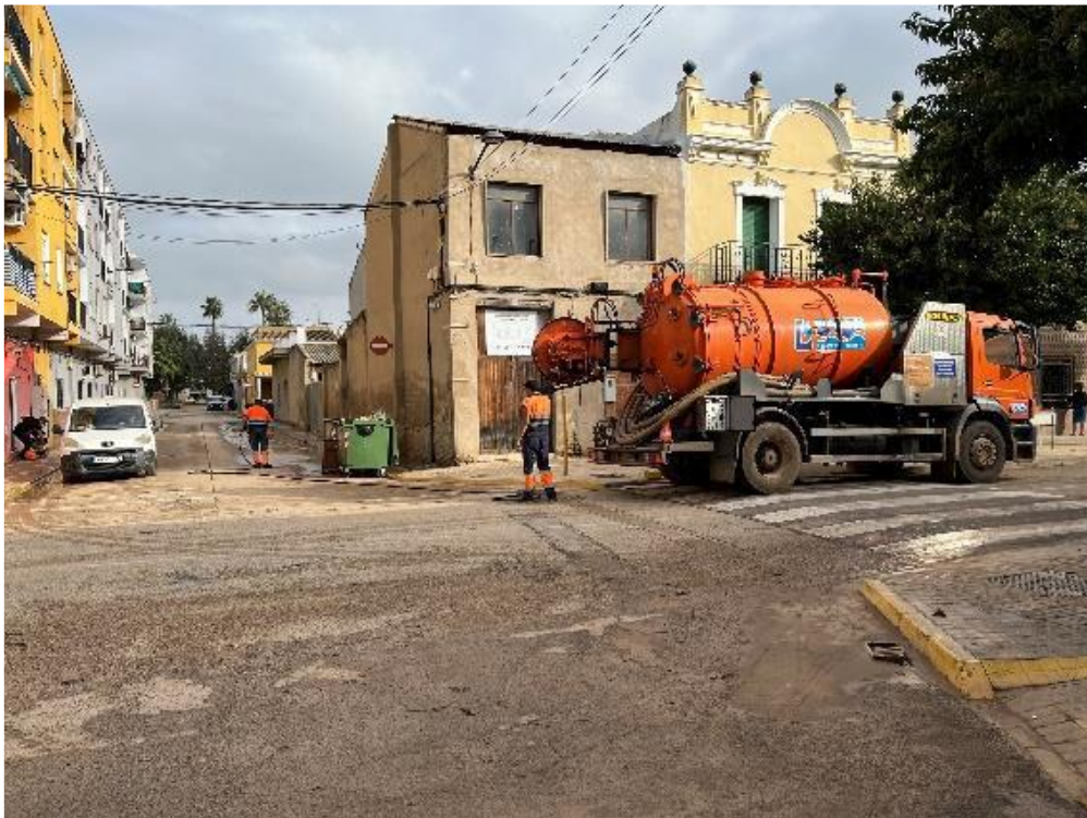
Imagen 2: Cuba – Chupona realizando tareas de limpieza sobre el colector
