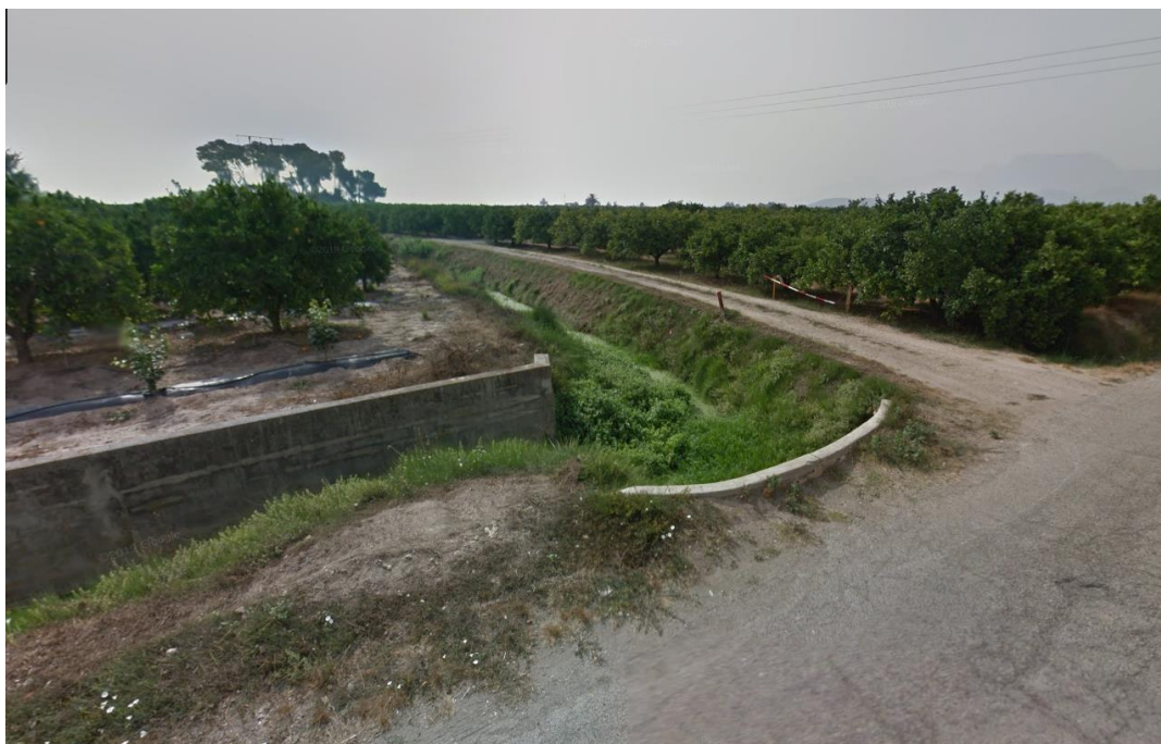
Imagen 6: Acequia primera. Recogida pluviales zona sur Casco Urbano
