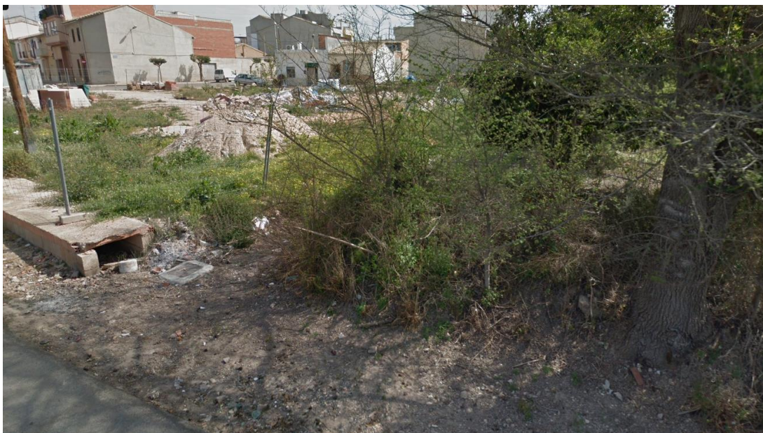
Imagen 4: Canal 06 * 06 m recogida pluviales
