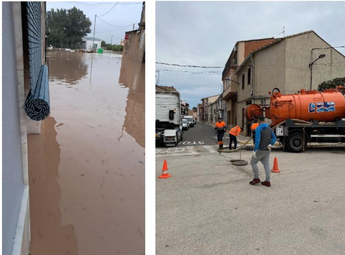
Imagen 3: Trabajos de achique y limpieza de colectores
