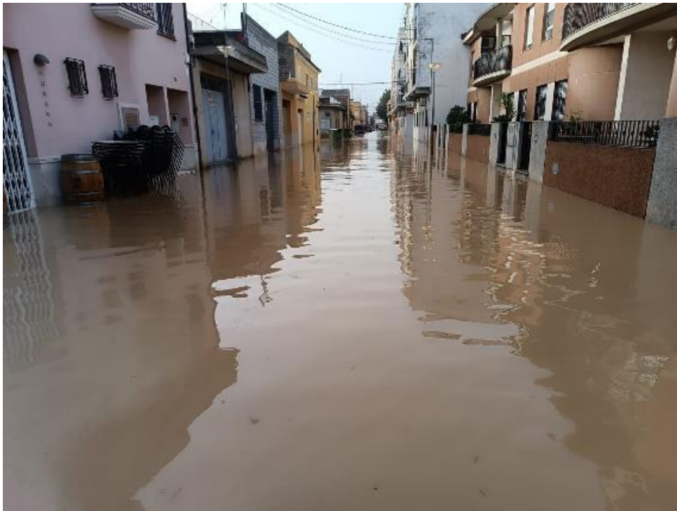
Imagen 1: Estado de la calle Espartería tras la inundación
