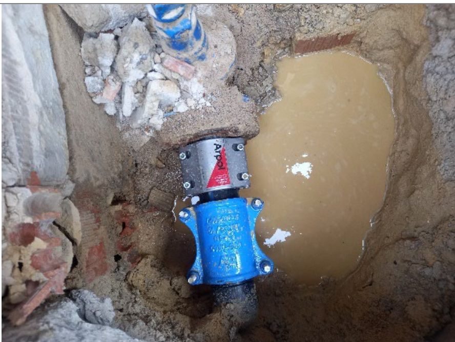
Reparación de fuga en la Plaza de Les Corts Valencianes
