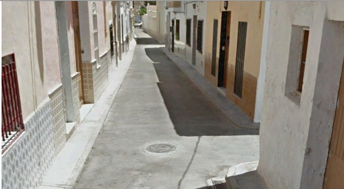
Zona urbana con algún problema detectado en colectores. Calle Sta. Catalina
