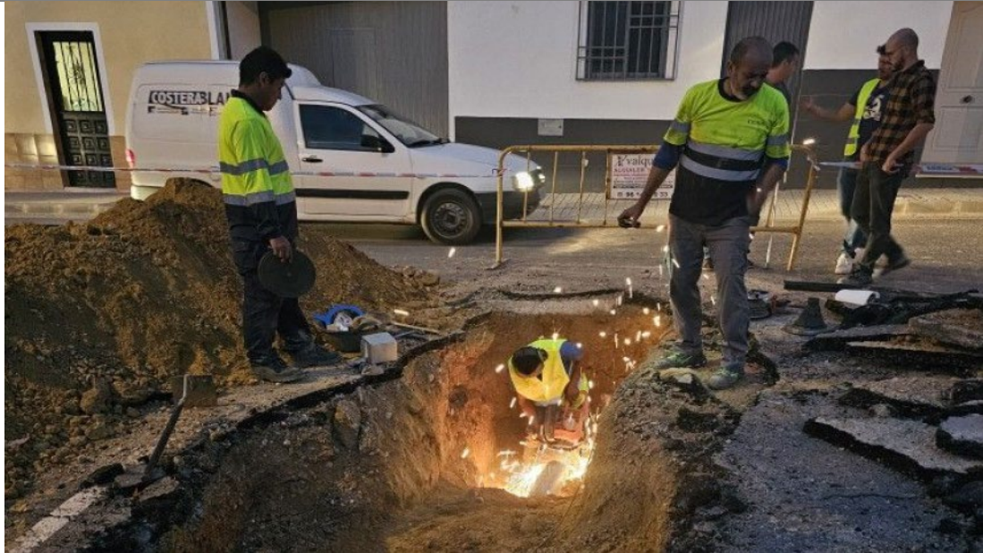
Reparación en el sistema de abastecimiento en la bajada del depósito
