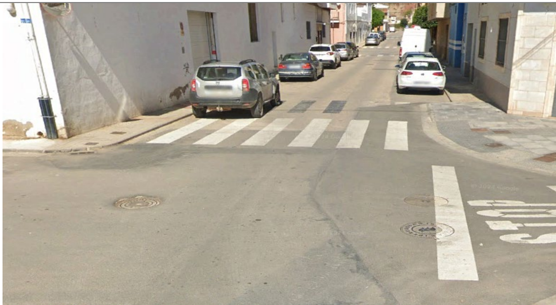
Zona urbana con algún problema detectado en colectores. Calle santa Bárbara
