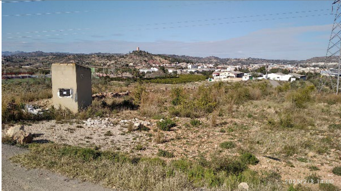
Vista desde el depósito al núcleo urbano
