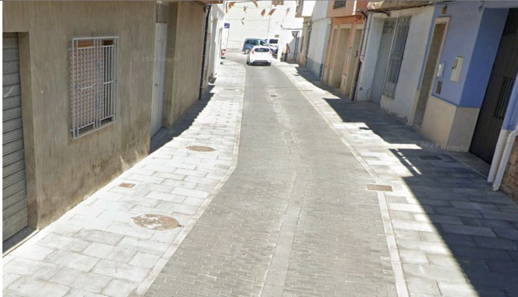
Zona urbana con algún problema detectado en colectores. Calle Sorolla
