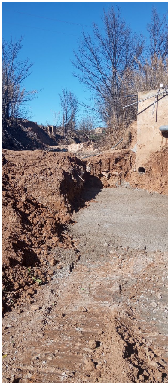
Imagen 8: Trabajos talud perimetral EDAR Requena-Casco. Regajo de las Reinas
