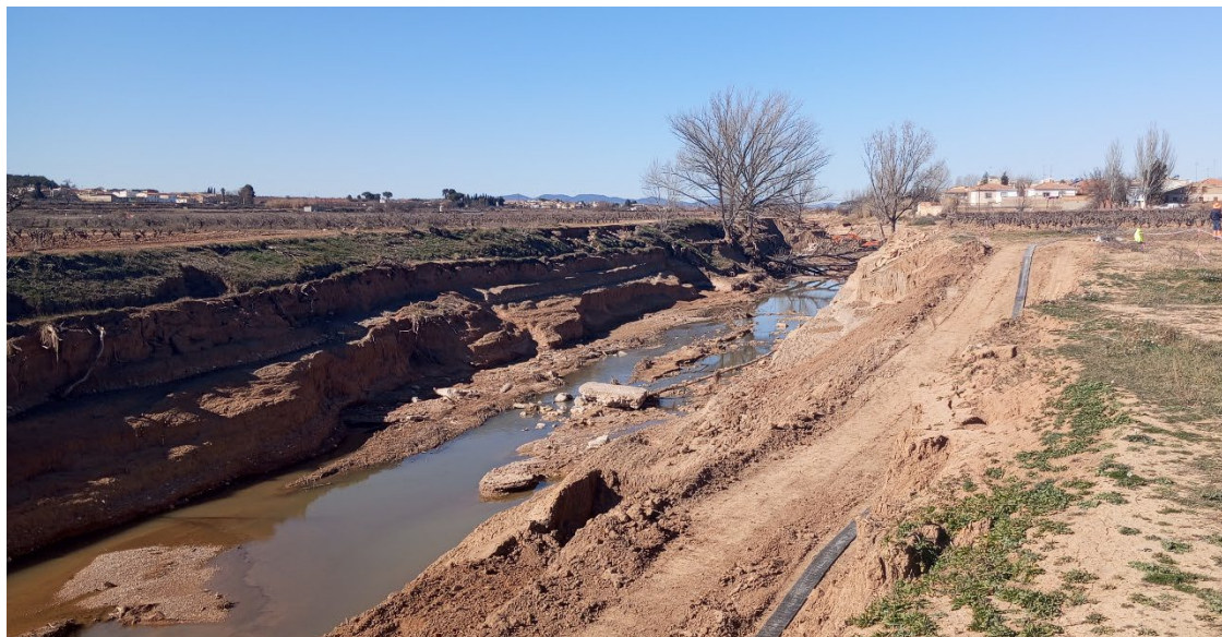
Imagen 1: Obras Impulsión EBAR San Antonio
