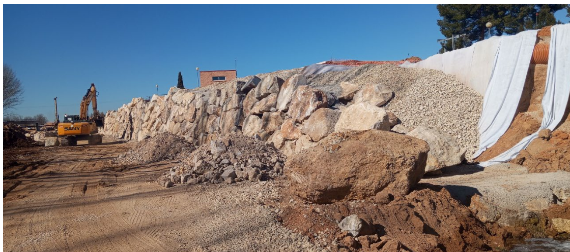
Imagen 6: Trabajos talud perimetral EDAR Requena-Casco.
