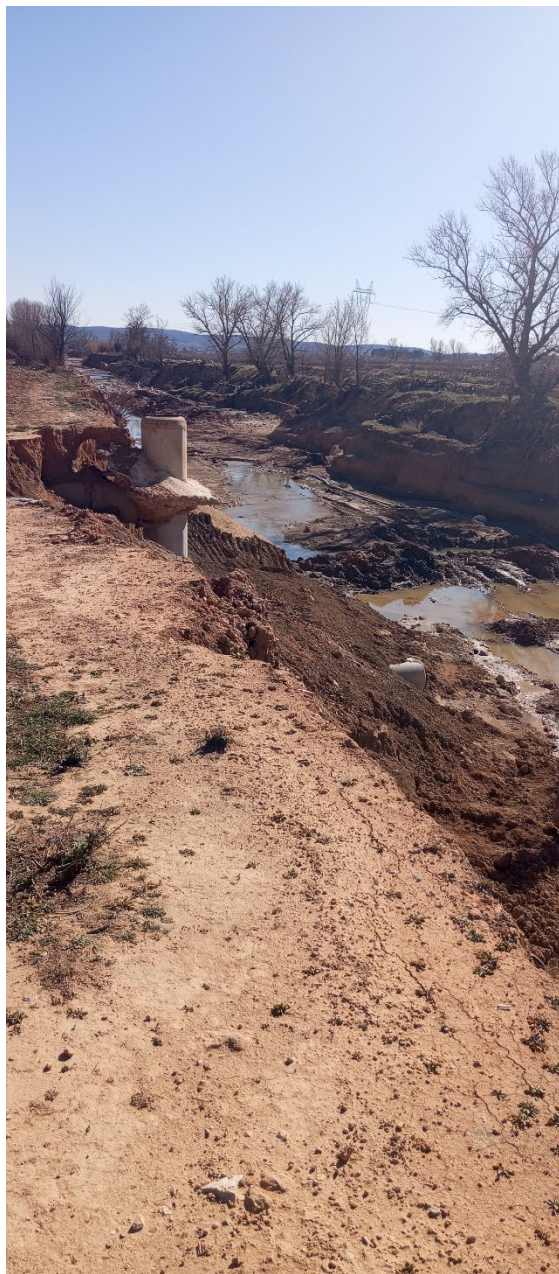
Imagen 3: Obras Impulsión EBAR San Antonio
