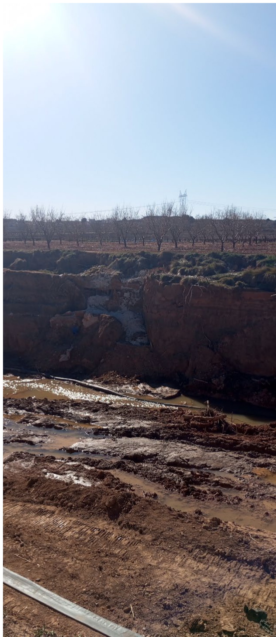
Imagen 4: Obras Impulsión EBAR San Antonio
