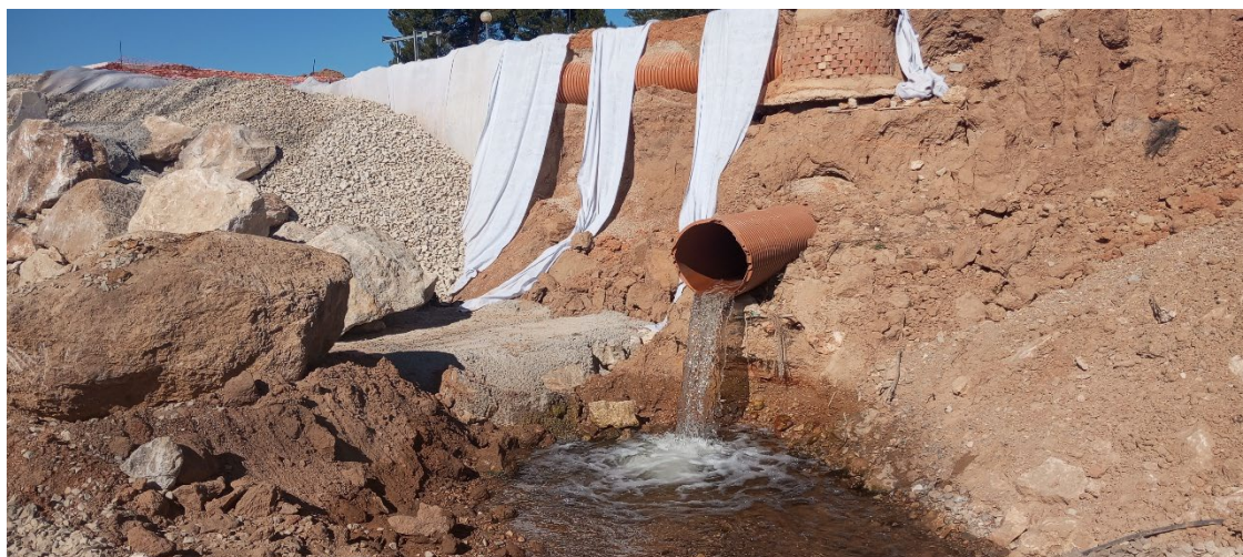
Imagen 7: Salida agua tratada EDAR Requena-Casco.
