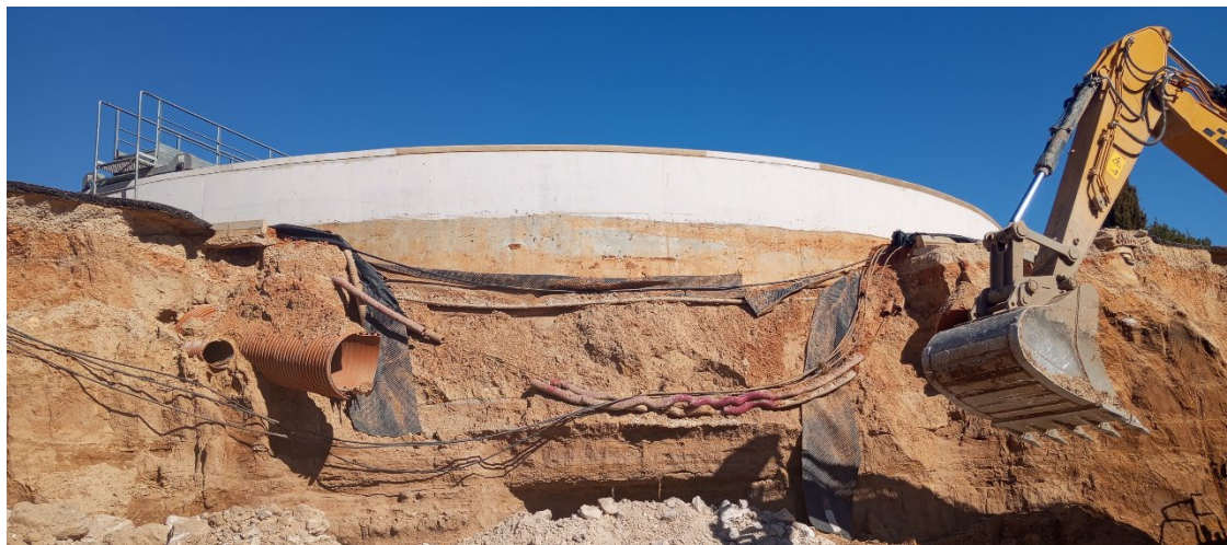
Imagen 5: Trabajos talud perimetral EDAR Requena-Casco.
