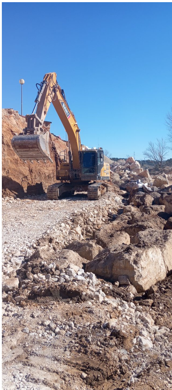
Imagen 9: Trabajos talud perimetral EDAR Requena-Casco. Regajo de las Reinas
