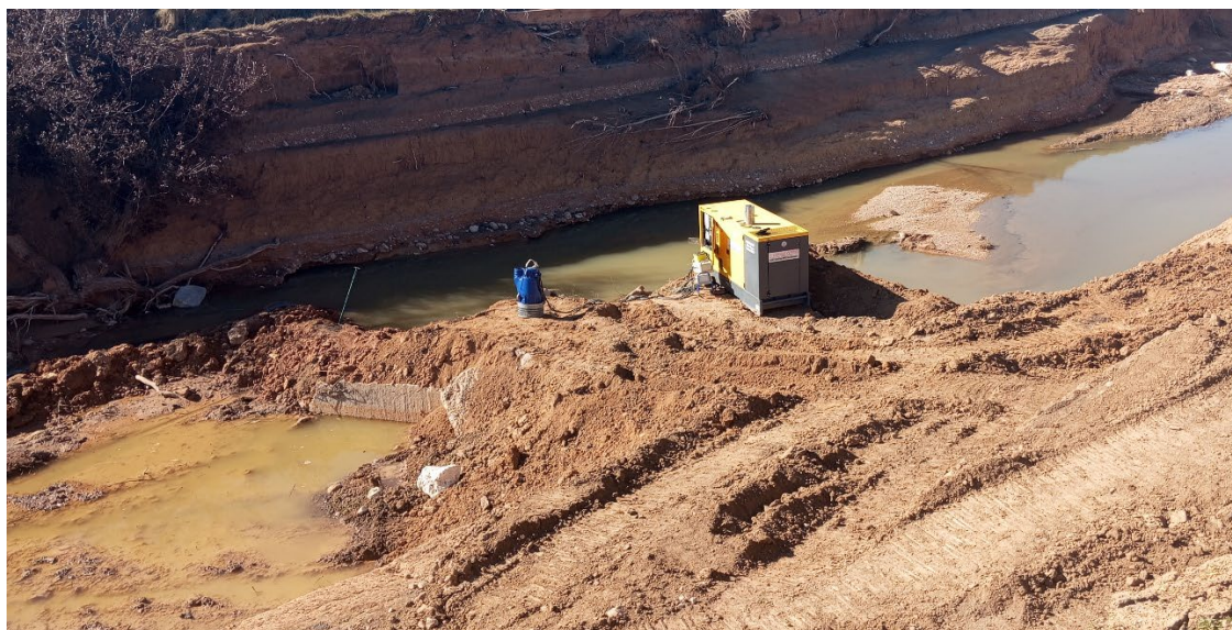
Imagen 2: Obras Impulsión EBAR San Antonio
