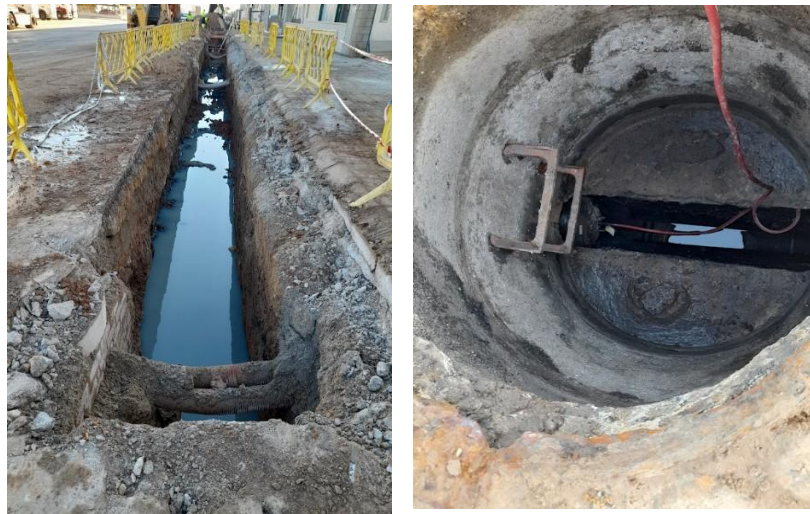
Actuación de renovación en el tramo requerido (izquierda) y balón instalado para facilitar los trabajos (derecha)
