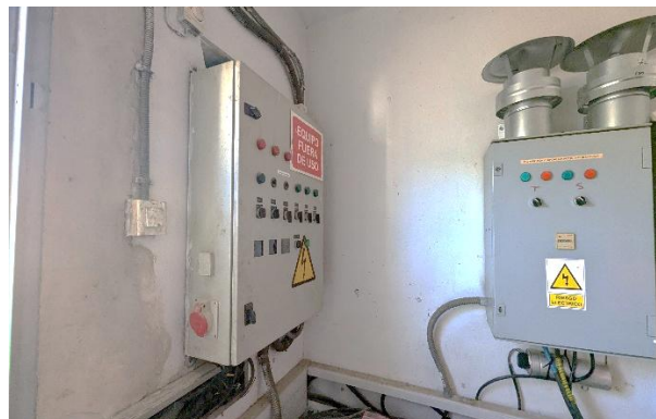
Edificio de soplantes
