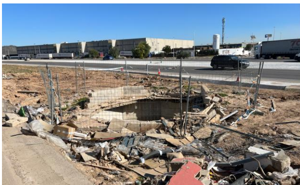
Arquetón de pluviales. Protección perimetral aun por restituir.
