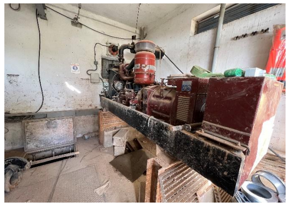
Cámara de bombas y grupo electrógeno. Dos de las tres bombas y el grupo electrógeno han quedado averiados.
