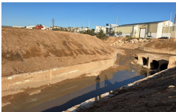
Salida de colectores de pluviales a la rambla del Poyo. El cauce del Poyo ha sido ya restituido, y la salida de los colectores despejada.
