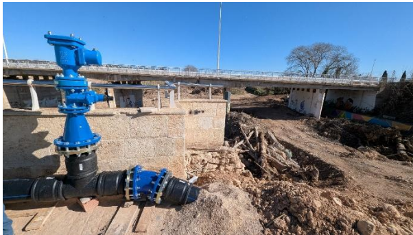
Tubería de agua potable provisional sobre el puente medieval cruzando el Turia
