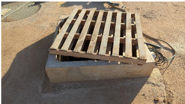
Arqueta de salida. Sistema provisional de salida instalado hasta la restitución definitiva. La tapa fue arrancada y arrastrada durante la riada.
