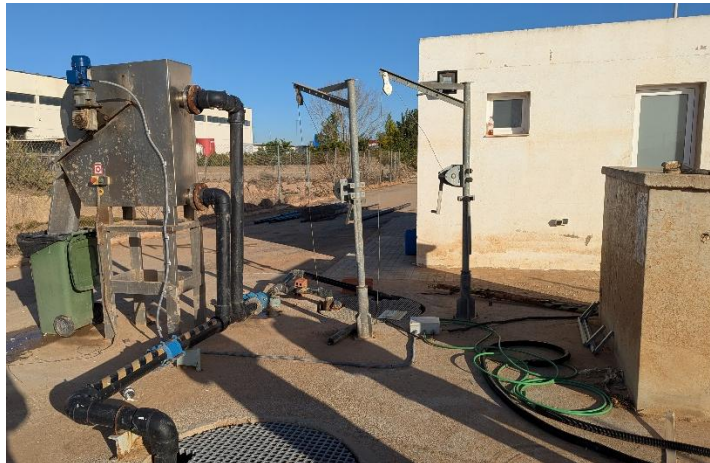
Conexiones hidráulicas y eléctricas del rototamiz repuestas
