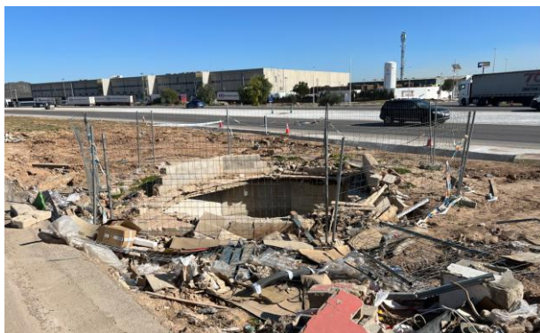
Arquetón de pluviales en el que ya se han retirado escombros y arrastres. Protección perimetral aun por restituir, con vallado provisional.
