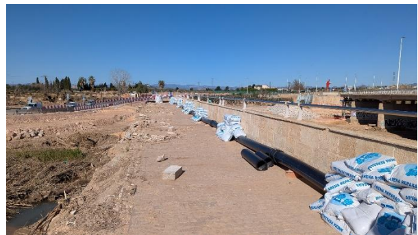
Tubería de agua potable provisional sobre el puente medieval cruzando el Turia
