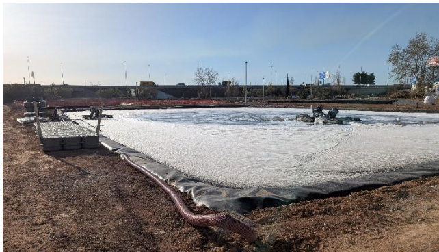
Laguna reacondicionada como reactor biológico
