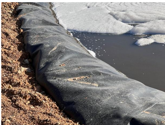
Geotextil ya repuesto en la balsa rehabilitada (izquierda) y balsa a la espera de adecuación con textil arrancado en su práctica totalidad (derecha)
