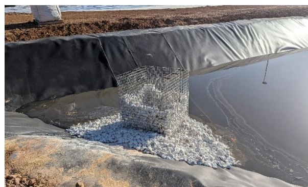
Laguna reacondicionada como balsa de decantación
