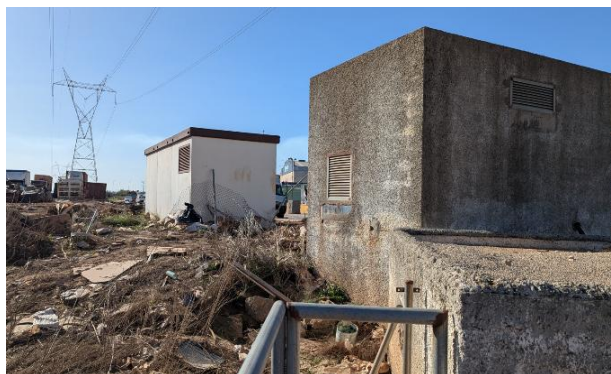
Exterior de la caseta de bombeo de pluviales. El vallado perimetral y la puerta de entrada al interior de la caseta han sido arrastrados.
