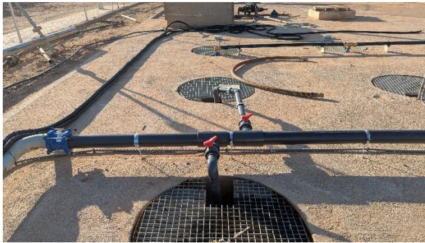
Elementos exteriores del tratamiento biológico restituidos. Tapas y conducciones repuestos.
