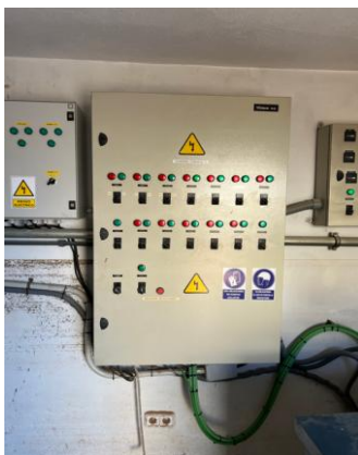
Cuadro eléctrico general. Algunos componentes de la parte inferior del cuadro y el todo el cableado han sido sustituidos para su puesta en marcha.
