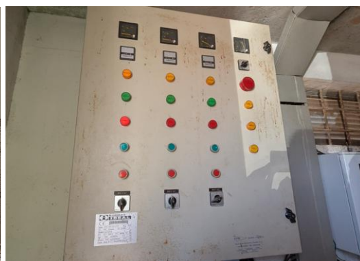
Interior de la caseta de bombeo de pluviales. Grupo electrógeno y cuadro eléctrico dañados a causa de la riada.
