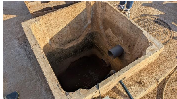
Arqueta de salida. Sistema provisional de salida instalado hasta la restitución definitiva. La tapa fue arrancada y arrastrada durante la riada.
