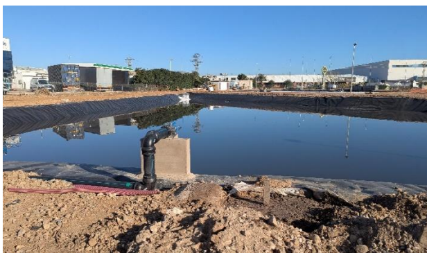
Laguna reacondicionada como balsa de decantación
