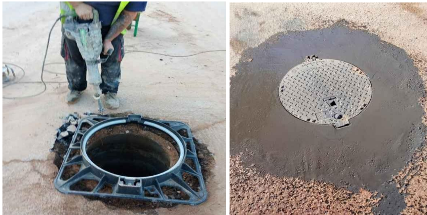
Reposición de tapa de pozo de registro
