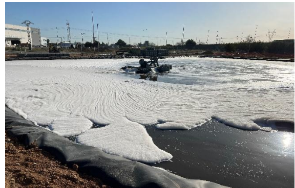
Laguna reacondicionada como reactor biológico
