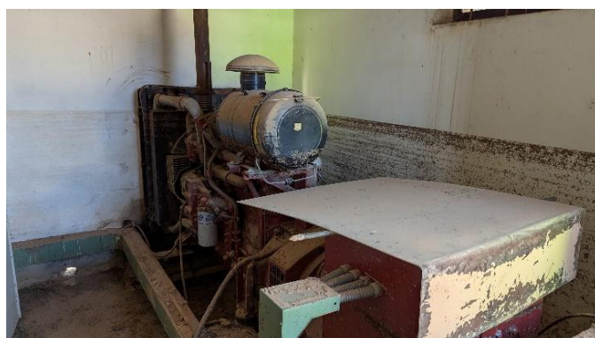
Interior de la caseta de bombeo de pluviales. Grupo electrógeno y cuadro eléctrico dañados a causa de la riada.
