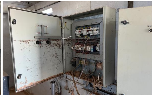
Interior caseta bombeo de residuales. Cuadro eléctrico averiado.
