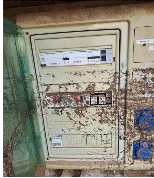
Interior caseta bombeo. Cuadro eléctrico averiado.
