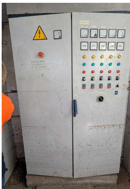
Cuadro eléctrico. Se observan las marcas de la altura que alcanzó el agua (1 m aprox.)
