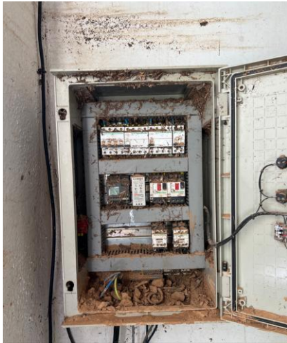
Interior caseta bombeo de pluviales. Cuadro eléctrico dañado.
