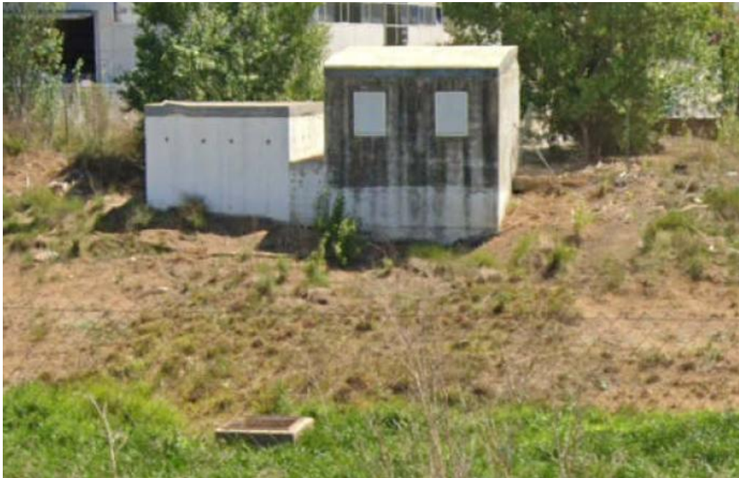
Estado actual de la obra de toma del barranco del Pozolet.
