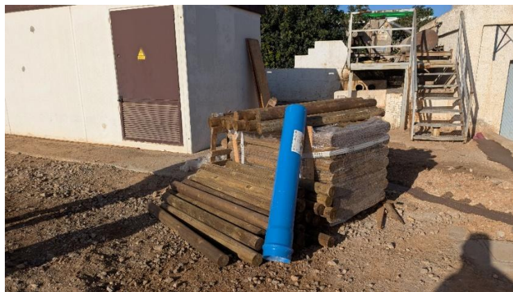
Postes de madera adquiridos para la ejecución del perímetro de las balsas
