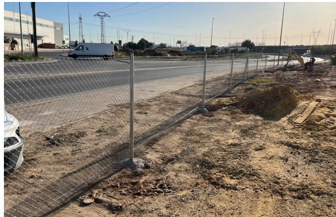
Nuevo cerramiento exterior de las instalaciones
