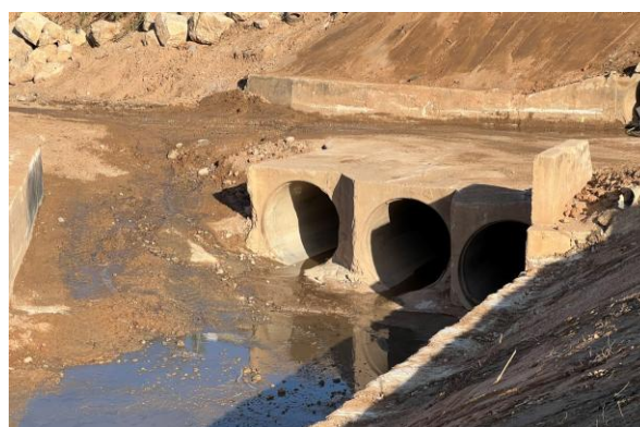
Salida de colectores de pluviales a la rambla del Poyo. El cauce del Poyo ha sido ya restituido, y la salida de los colectores despejada.
