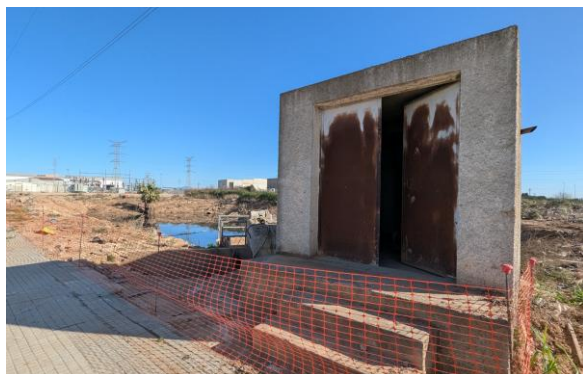
Exterior de la caseta de bombeo de pluviales. El vallado perimetral y la puerta de entrada al interior de la caseta han sido arrastrados.
