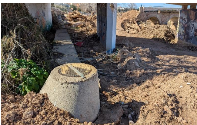
Inicio de la conducción de agua potable provisional en el cauce del río Turia (izquierda) y trazado de la tubería hasta llegar al puente medieval afectado (derecha)
