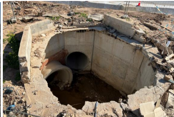
Arquetón de pluviales en el que ya se han retirado escombros y arrastres. Protección perimetral aun por restituir, con vallado provisional.
