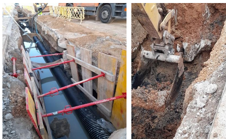
Actuaciones de renovación en el primer tramo
