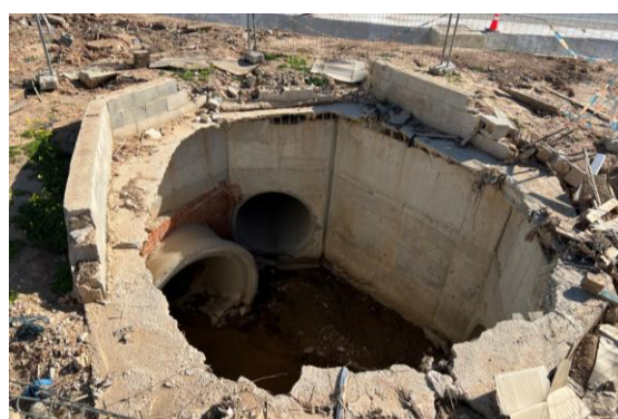
Arquetón de pluviales. Protección perimetral aun por restituir.
