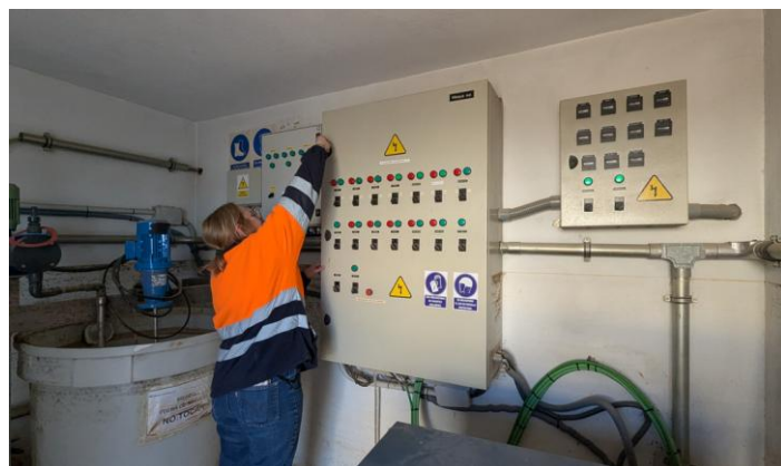
Cuadro eléctrico general. Algunos componentes de la parte inferior del cuadro y el todo el cableado han sido sustituidos para su puesta en marcha.
