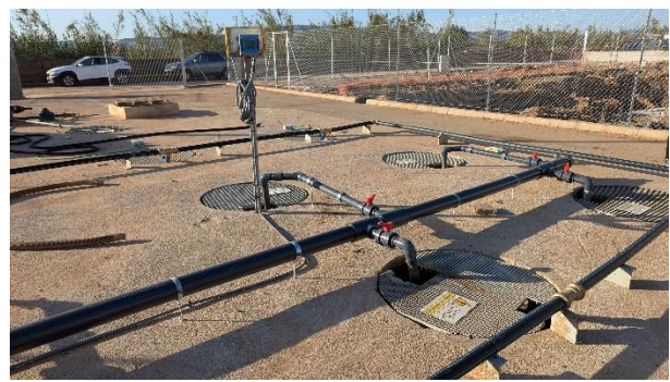
Elementos exteriores del tratamiento biológico restituidos. Tapas y conducciones repuestos.
