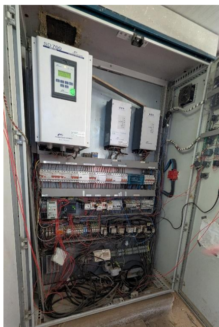
Cuadro eléctrico. Se observan las marcas de la altura que alcanzó el agua (1 m aprox.)
