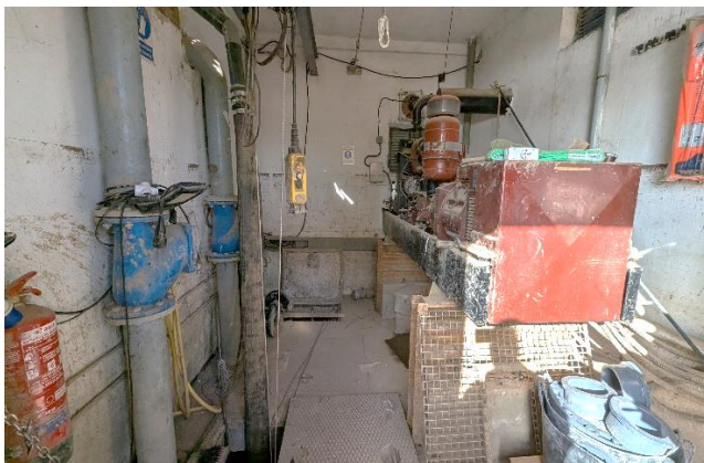
Cámara de bombas y grupo electrógeno. Dos de las tres bombas y el grupo electrógeno han quedado averiados.
