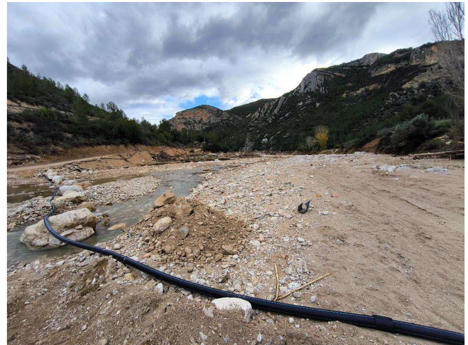
Figura 2. Tendido de la tubería en precario
