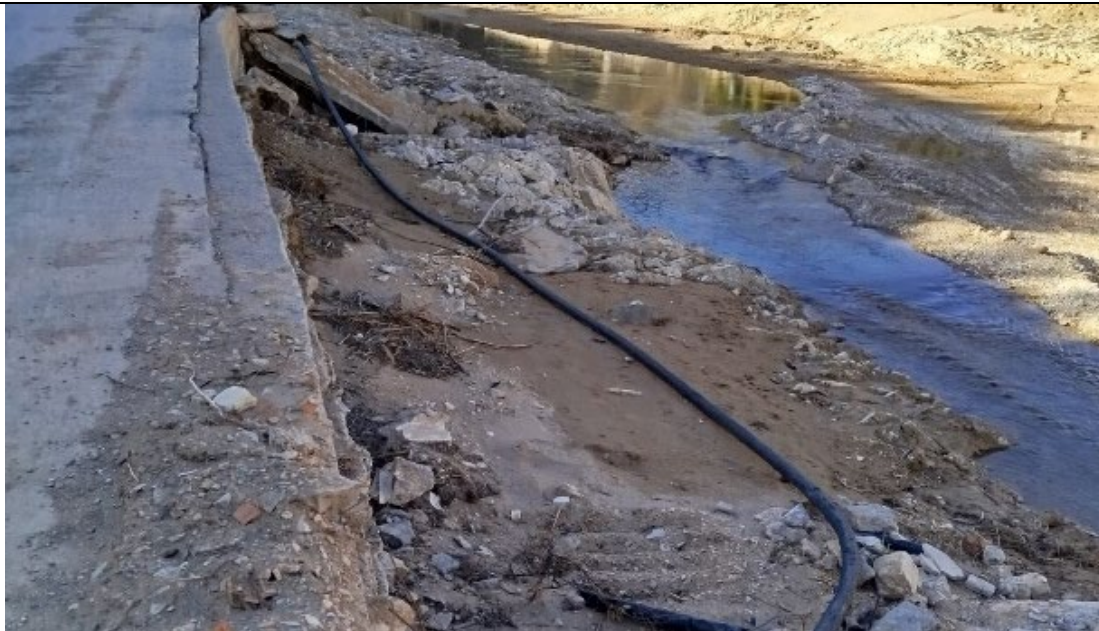
Tirada de abastecimiento provisional por el camino del Río
