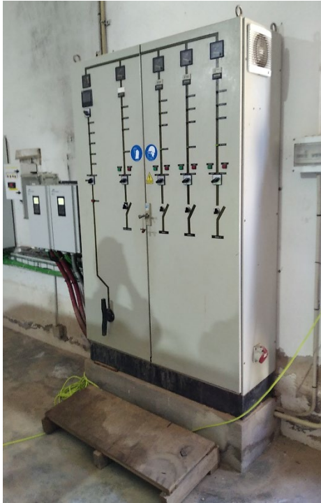
Vistas exterior e interior del cuadro eléctrico del bombeo del depósito viejo. Se aprecia la cota del agua de inundación
