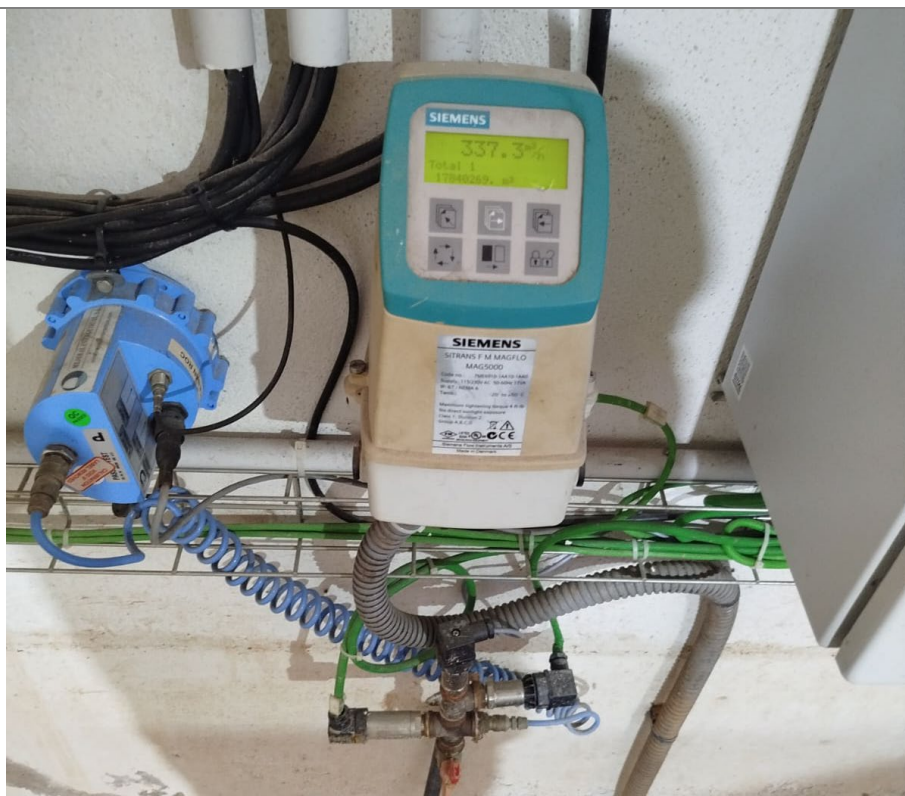
Caudalímetro. Se observa la cota del agua de inundación
