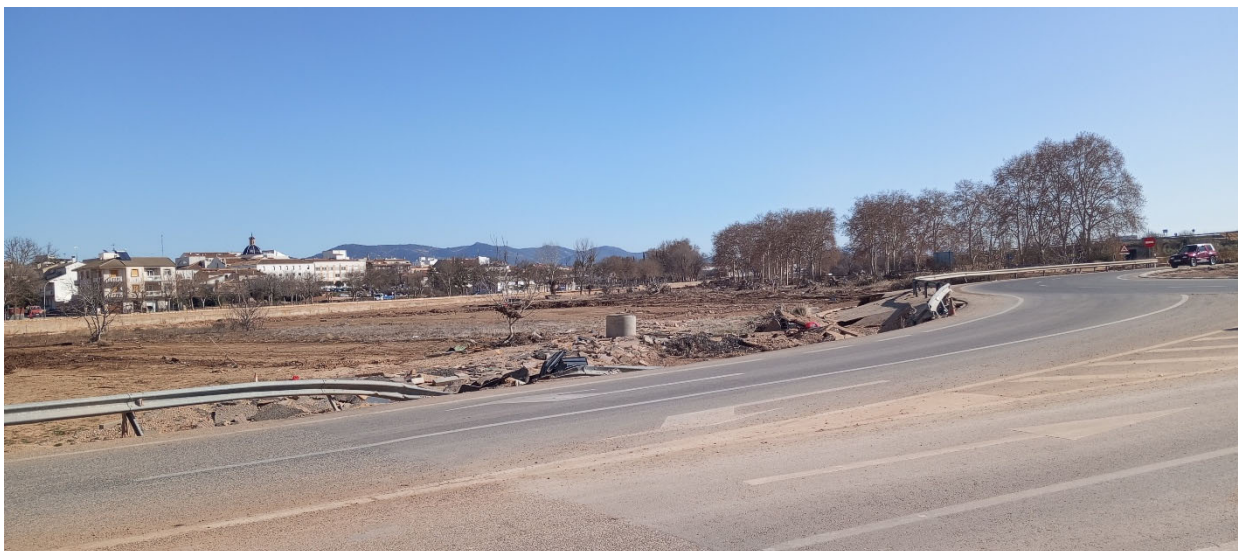
Imagen 2: Daños en el entorno de la antigua N-III
