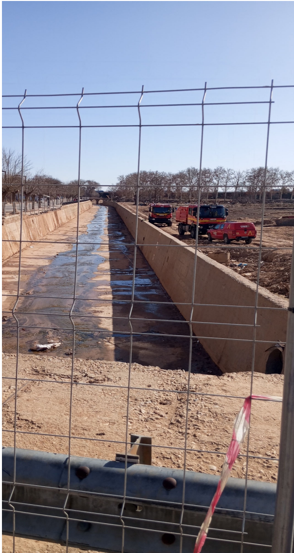
Imagen 3: Canalización río Magro a su paso por Utiel.
