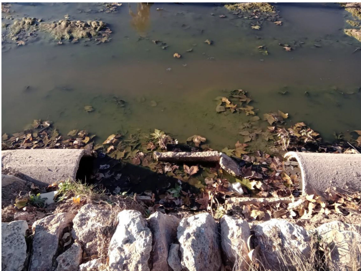
Imagen 5: Colector pedanía la Torre. Fase 0
