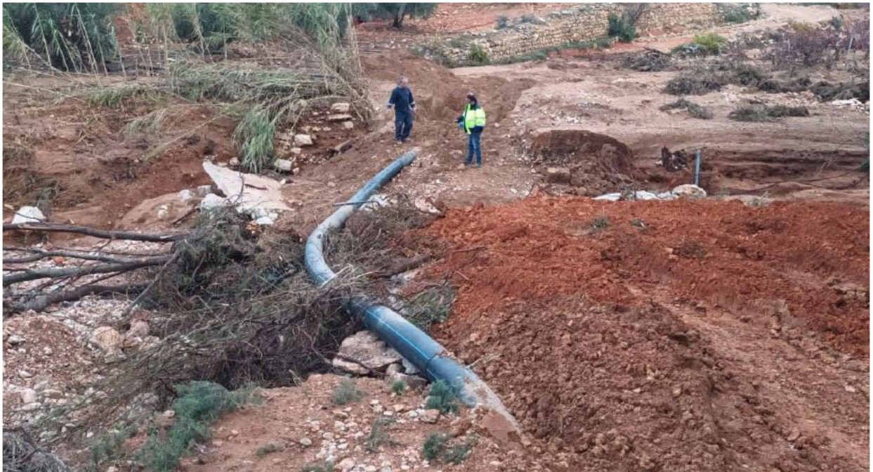
Imagen 1: Conducción del pozo Mustiguillo descubierta en cruce con rambla de Calera
