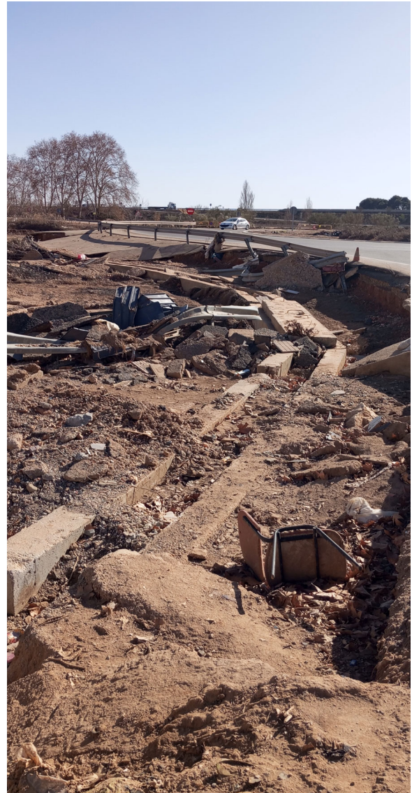
Imagen 4: Canalización de pluviales en el entorno de la N-III
