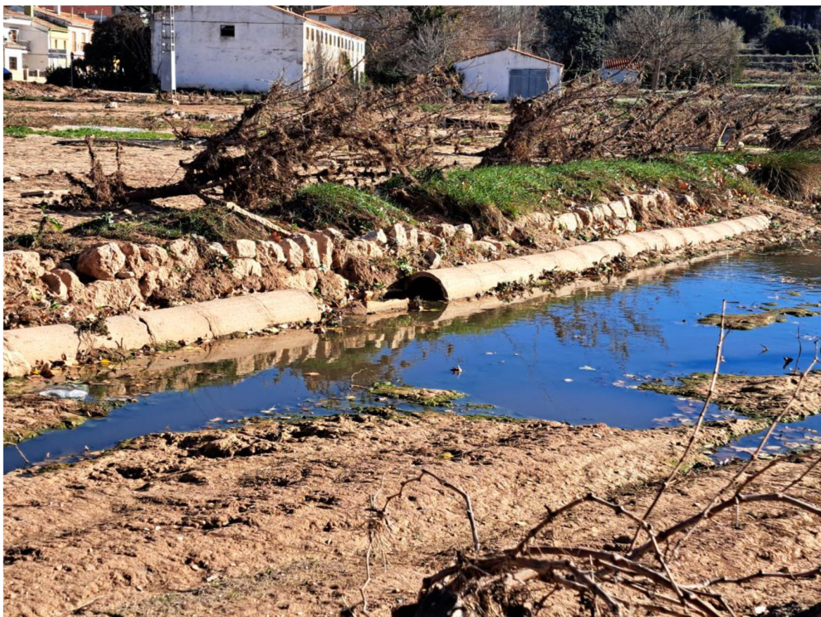
Imagen 5: Colector pedanía la Torre. Fase 0
