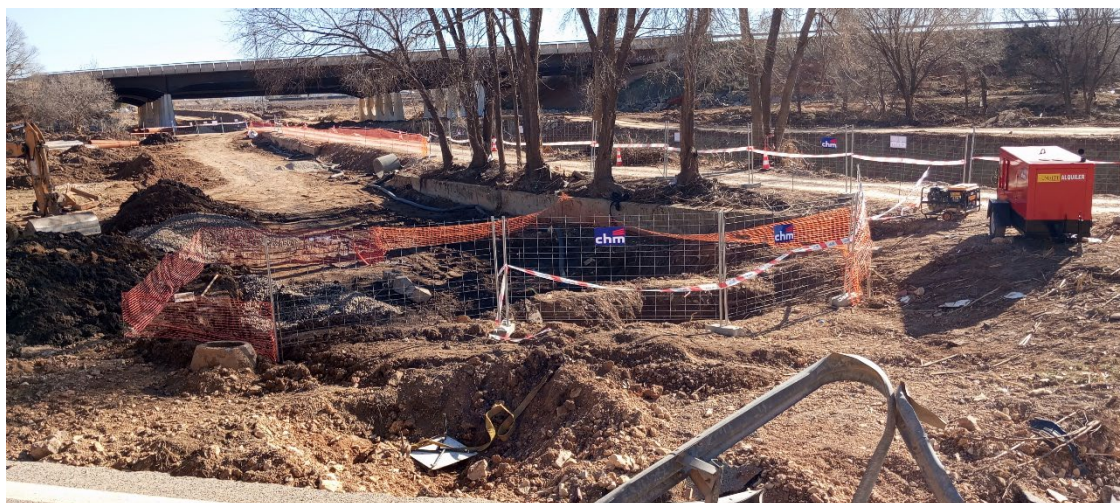
Imagen 3: Obras de reparación colector I
