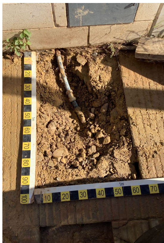
Imagen 8: Reparación averías abastecimiento
