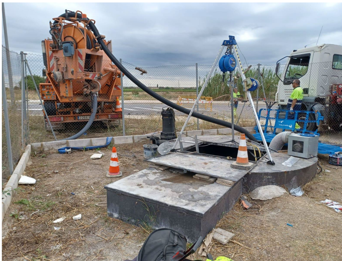
Imagen 5: Reparación EBAR Oficis
