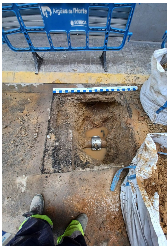
Imagen 7: Reparación averías abastecimiento
