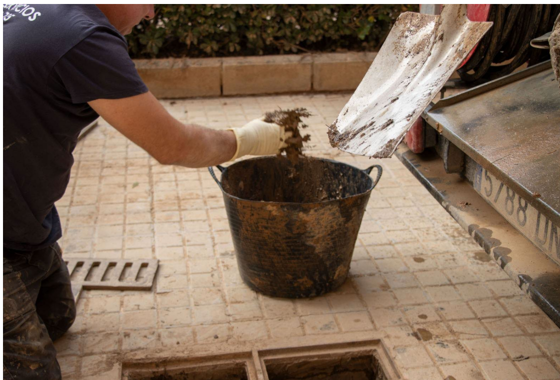
Imagen 3: Limpieza red de saneamiento
