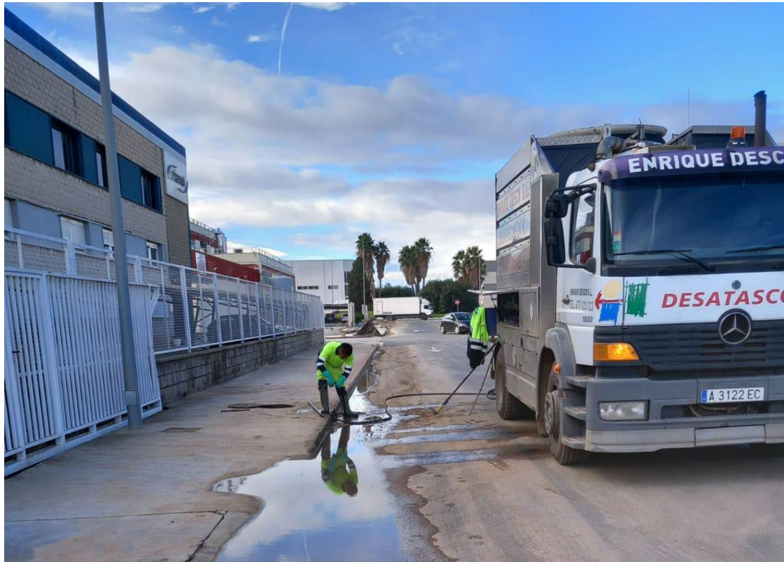
Imagen 4: Limpieza red de saneamiento
