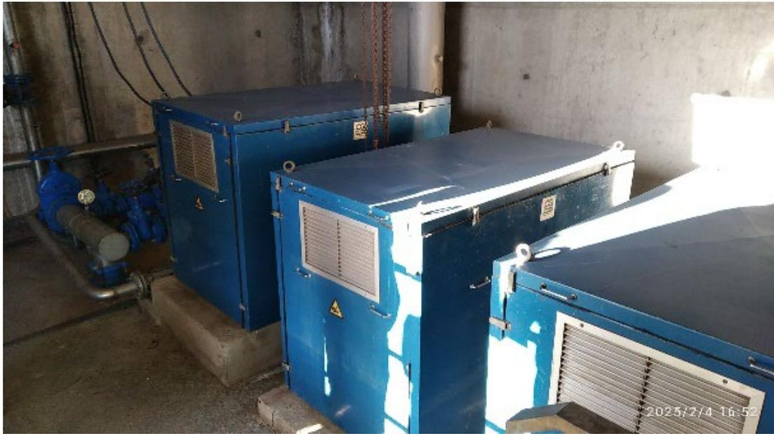
Vistas de los distintos equipos ubicados en la sala de soplantes y bombas de fangos, ubicada a cota inferior a la de urbanización, se observan restos de la inundación en paredes y suelo.
