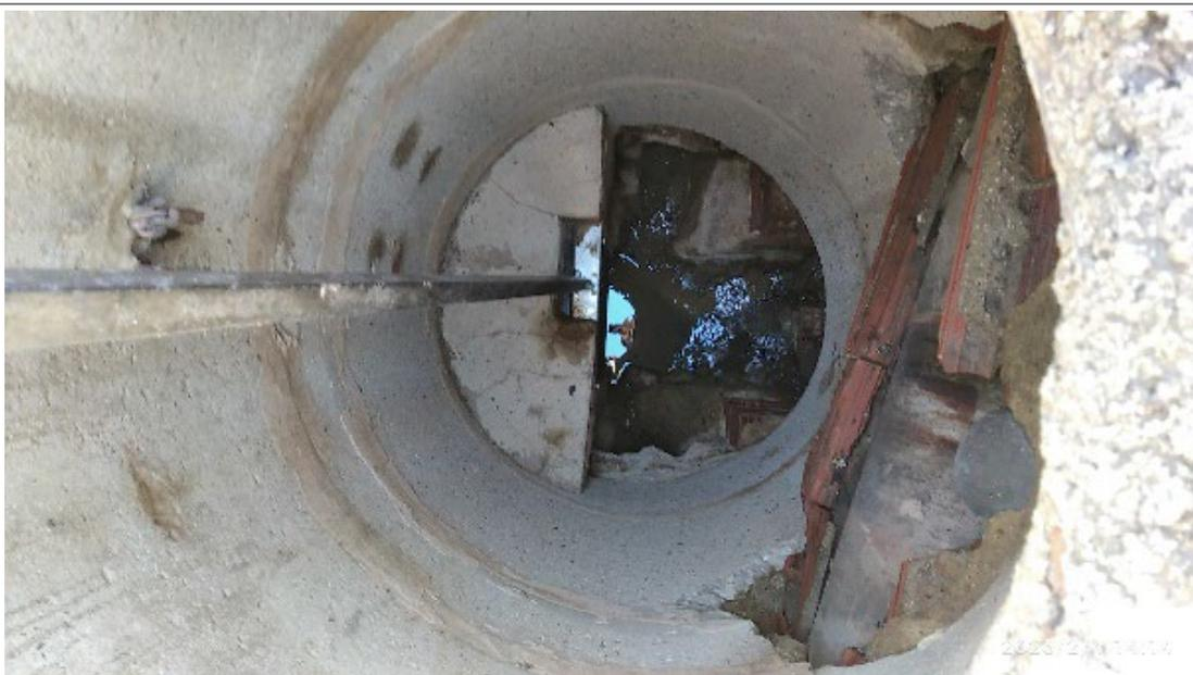
Vista del interior de un pozo del paseo del río, se observan restos de barro en el fondo, y la tajadera existente para control de los alivios al río.
