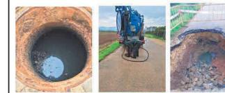
Foto de registro nivel alto (gabarito en abtvo 3) Trabajo de limpieza con agua a presión. Tramo colector roto.
