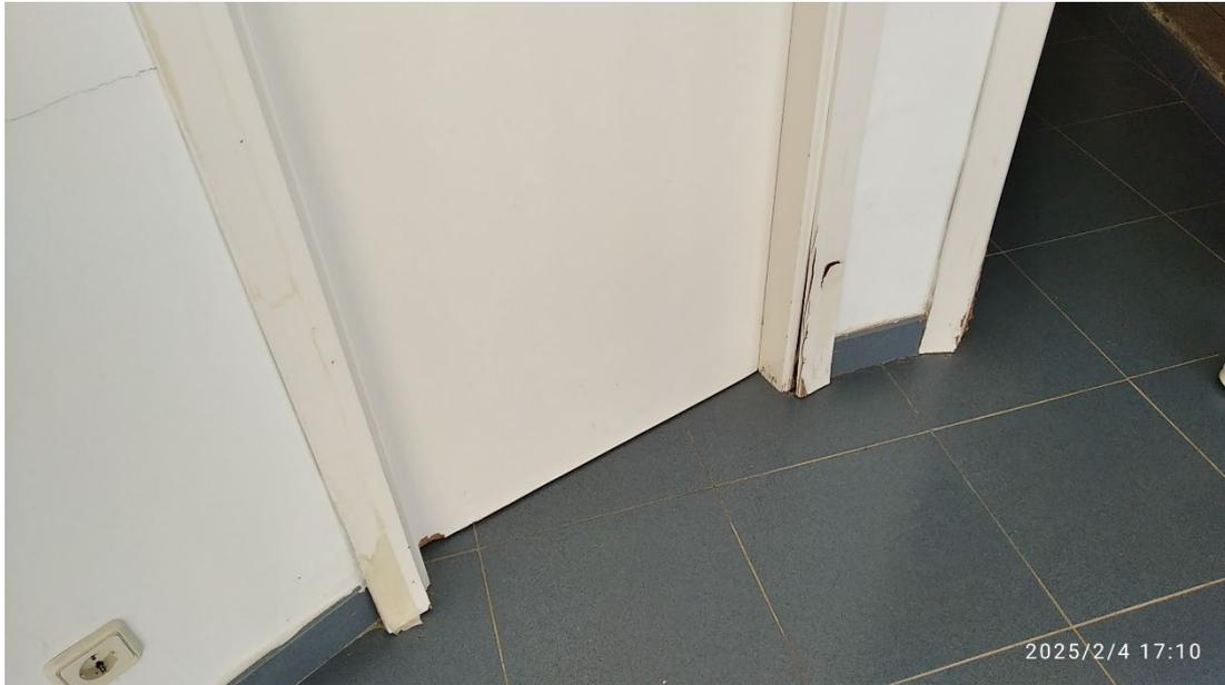
Fotografía de la planta superior del edificio de control, que no fue inundada las puertas y marcos muestran signos de deterioro en su parte inferior.
