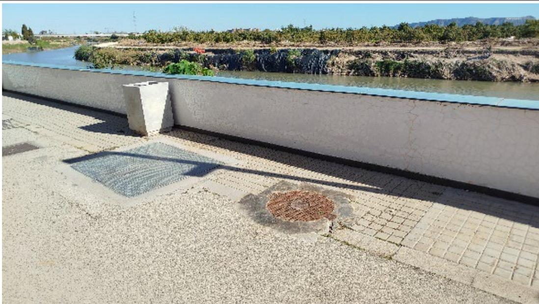
Vista del Paseo del río, el colector entra en carga en días de lluvia cuando se supera la capacidad de la red unitaria. Funciona como un pequeño tanque de tormentas, reteniendo parte del agua antes de verter al río.
