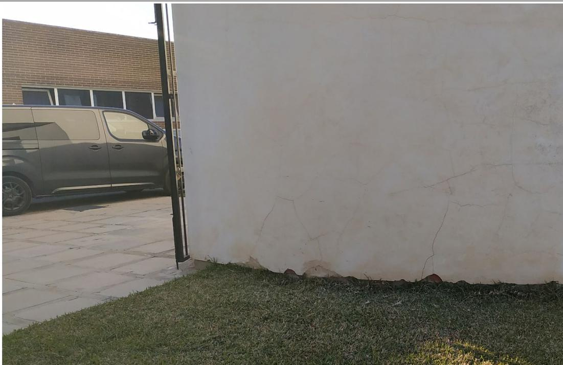
Exterior del edificio de control, se aprecian restos de barro en su parte inferior, pero no hay marca uniforme de la inundación.
