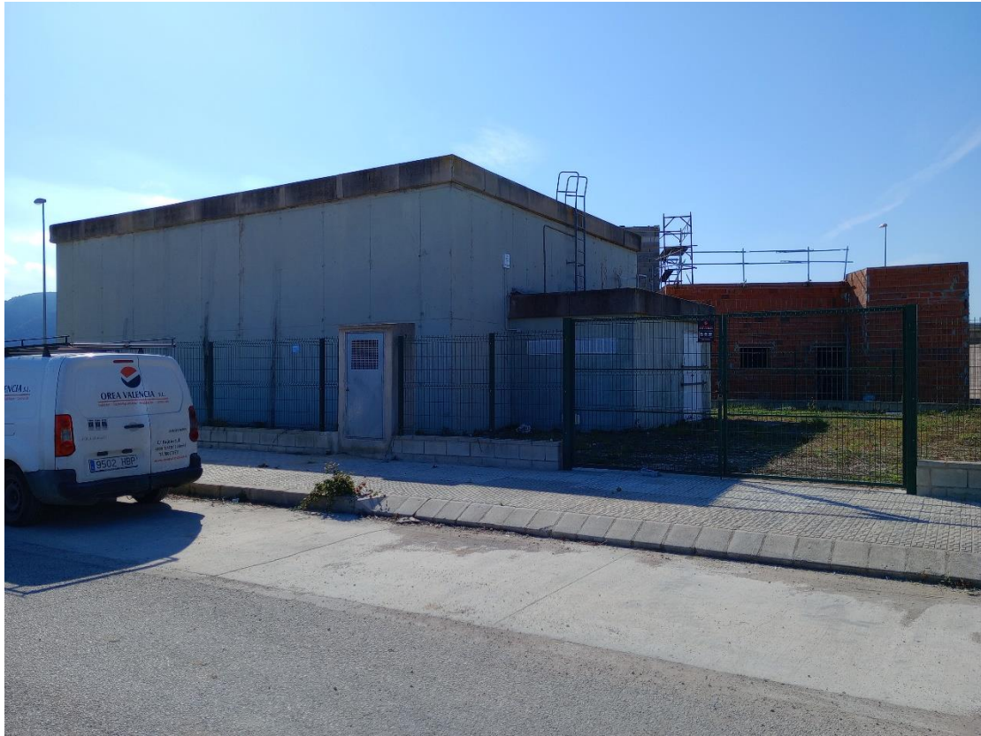
EXTERIOR DE LA ESTACIÓN DE BOMBEO HIDRAQUA
