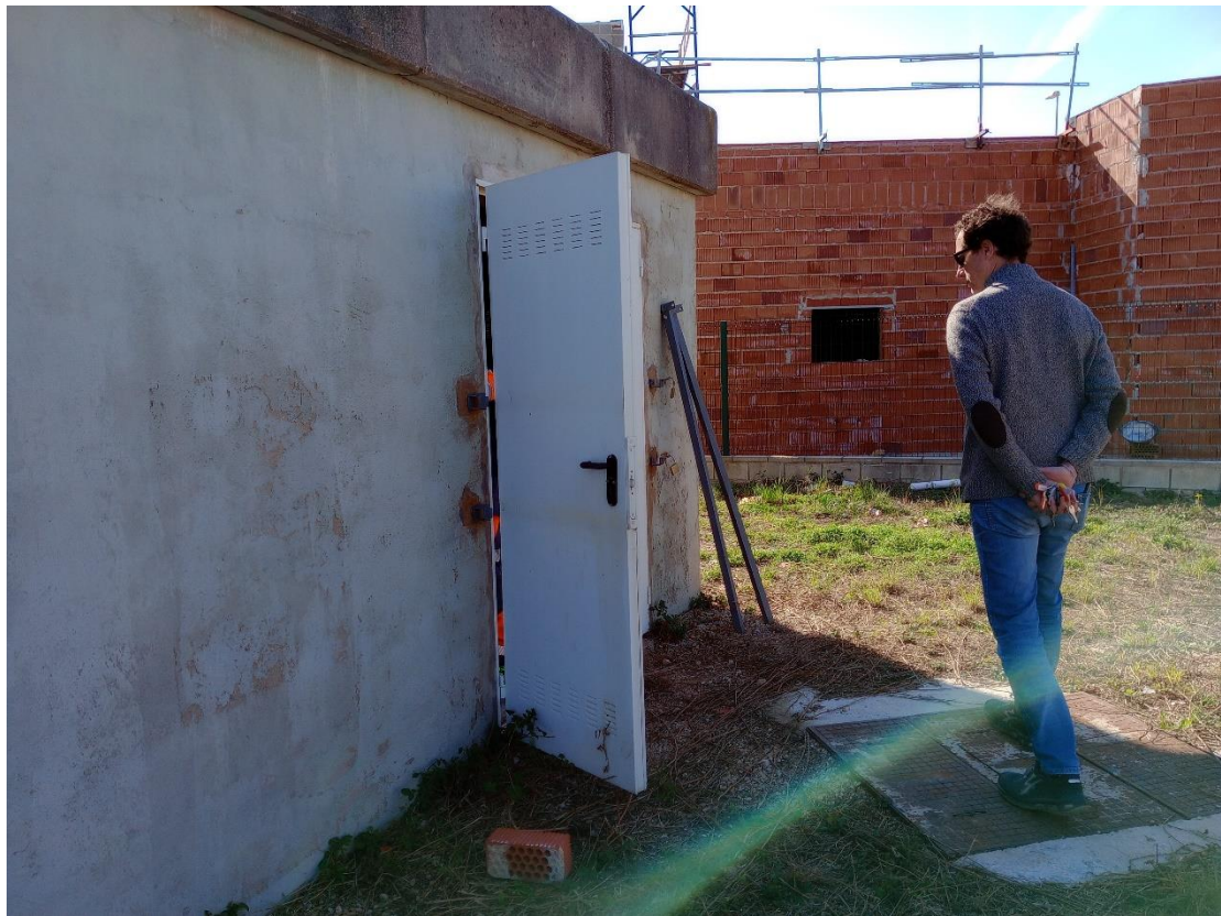
ACCESO A LA ESTACIÓN DE BOMBEO
