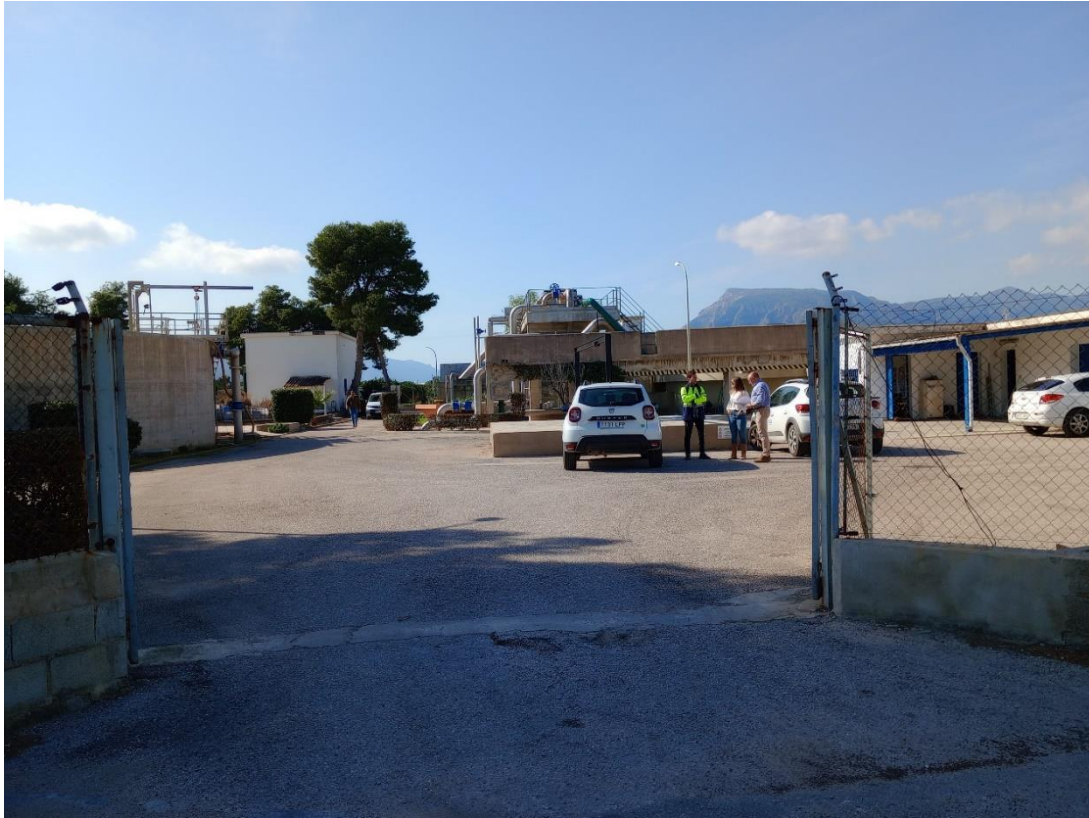
1. ACCESO A EDAR TAVERNES-BASSA
