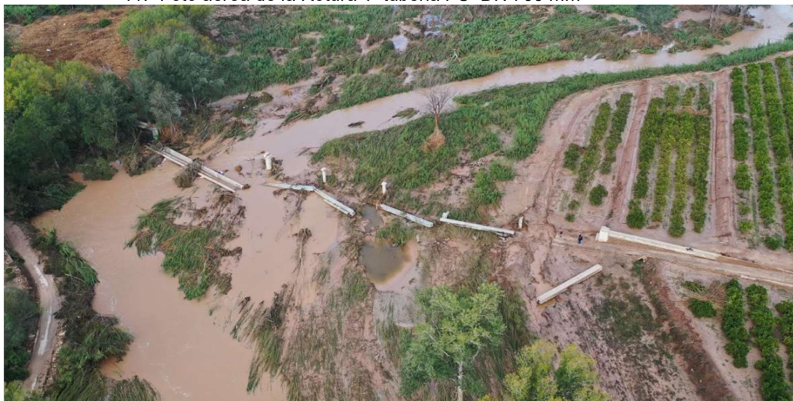
11.- Foto aérea de la Rotura 1 tubería FC DN 700 mm
