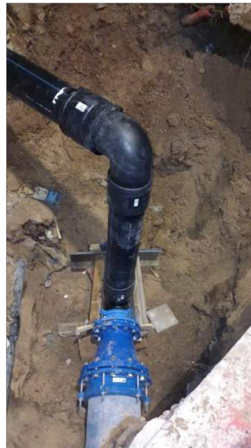
Fotografía 5. Bypass provisional de polietileno DN200 de la tubería general de abastecimiento a Vilamarxant afectada en el cruce del Barranco La Teulada para dar servicio a la población. Detalle 4
