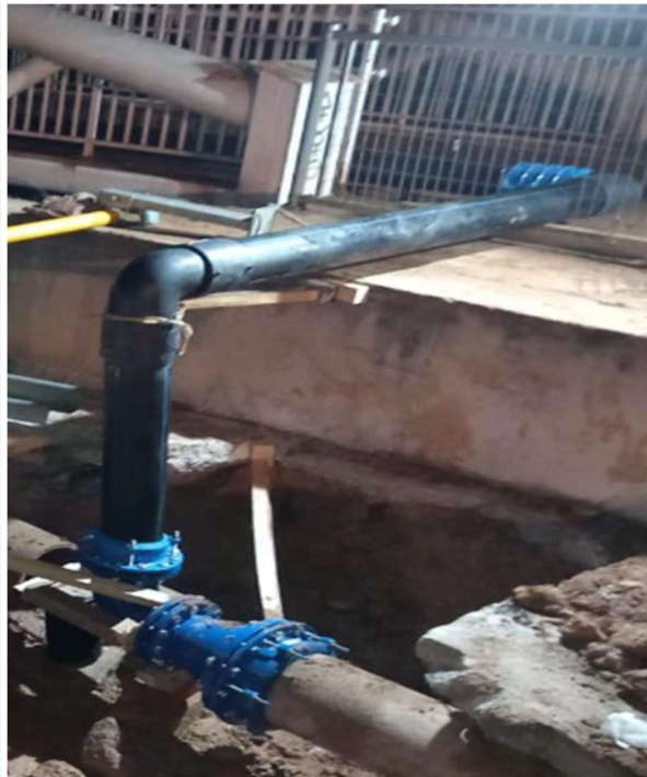
4.- Conexión provisional Urb Les Creuetes
