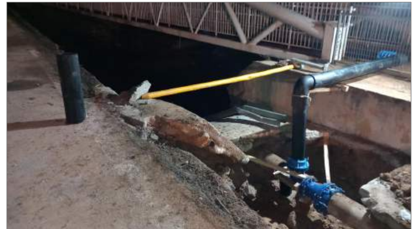
Fotografía 3. Bypass provisional de polietileno DN200 de la tubería general de abastecimiento a Vilamarxant afectada en el cruce del Barranco La Teulada para dar servicio a la población. Detalle 2
