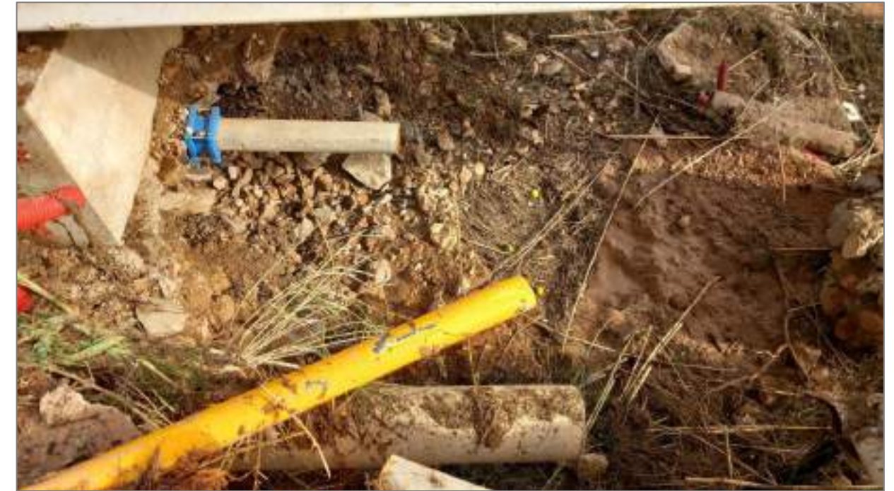
Fotografía 2. Tubería de fibrocemento DN150 afectada en el cruce del Barranco La Teulada
