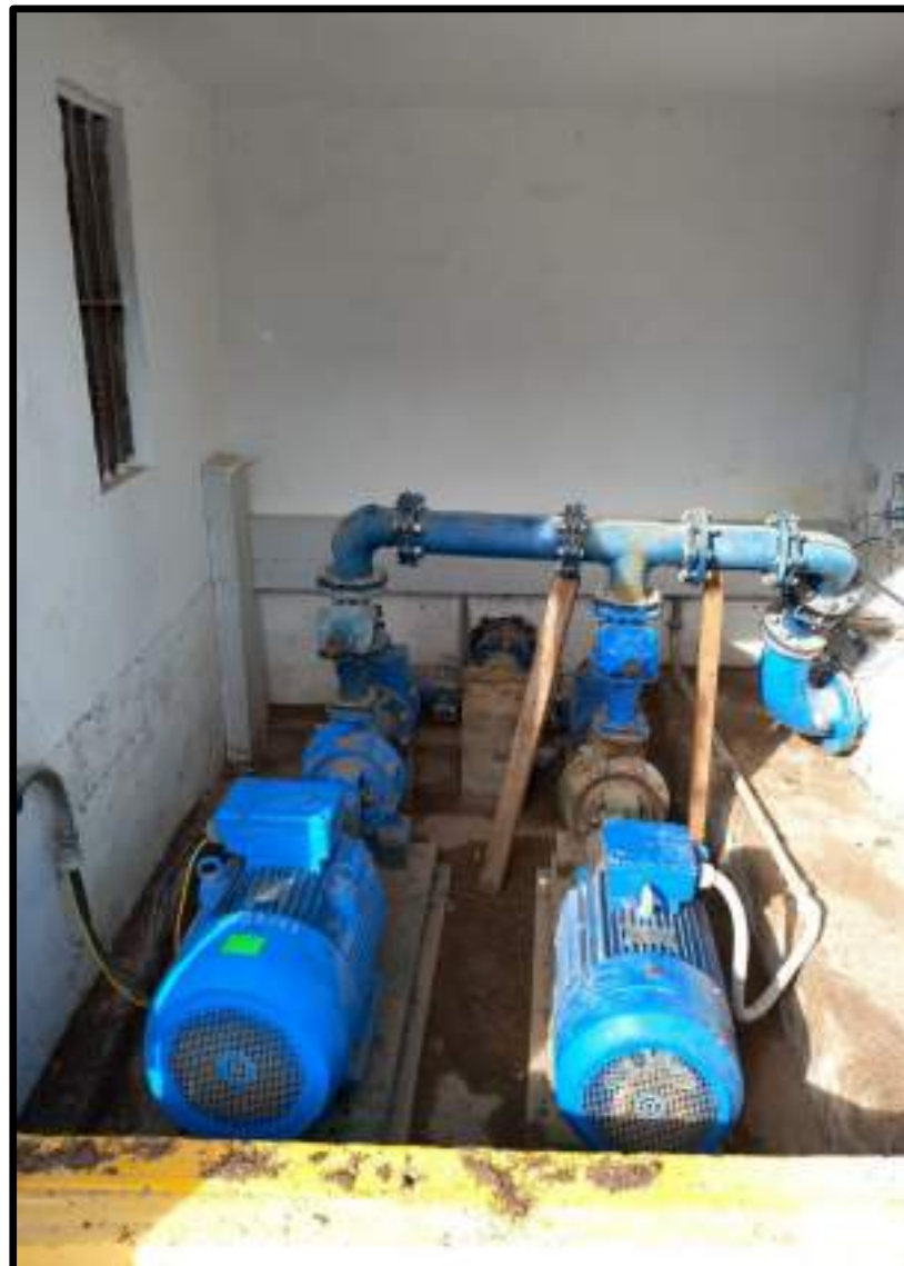
Fotografía nº 1. Bombeo tras inundación
