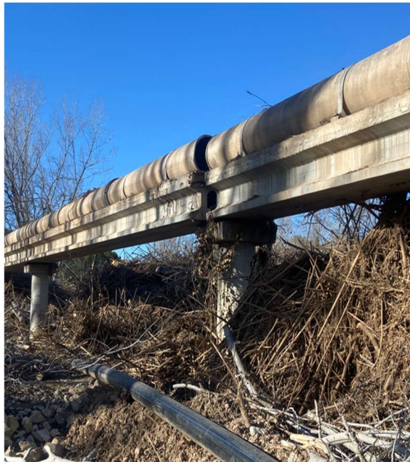
21.- Rotura entre pozos de V1 a V2
