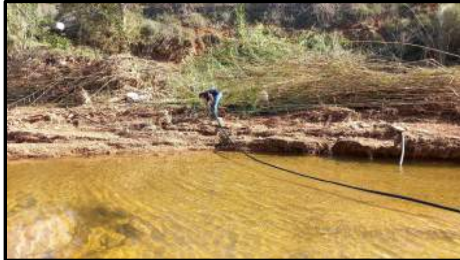
Fotografía nº 1. Zona de actuación tubería afectada. Bypass provisional en ramal de abonado afectado. Detalle 1
