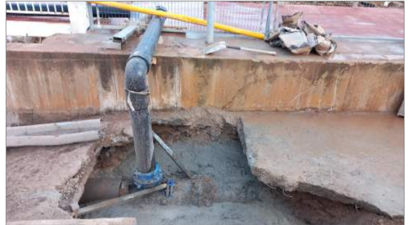
Fotografía 2. Bypass provisional de polietileno DN200 de la tubería general de abastecimiento a Vilamarxant afectada en el cruce del Barranco La Teulada para dar servicio a la población. Detalle 1
