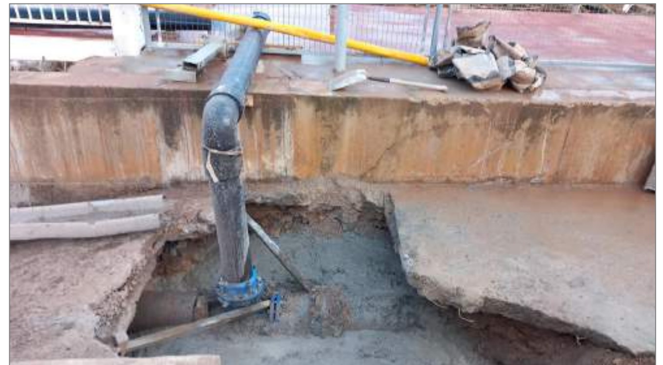
Fotografía 2. Tubería de fibrocemento DN150 afectada en el cruce del Barranco La Teulada
