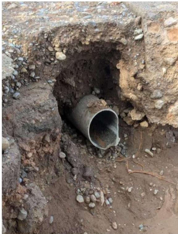
21.- Rotura entre pozos de V1 a V2
