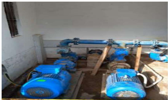
5.- Cambio motores EBAP Vilamarxant
