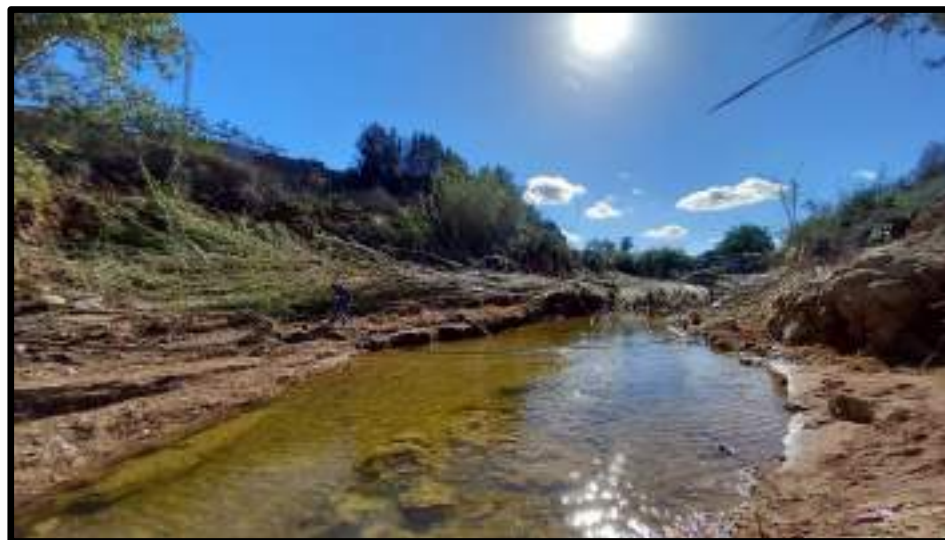
Fotografía nº 2. Zona de actuación tubería afectada. Bypass provisional en ramal de abonado afectado. Detalle 2
