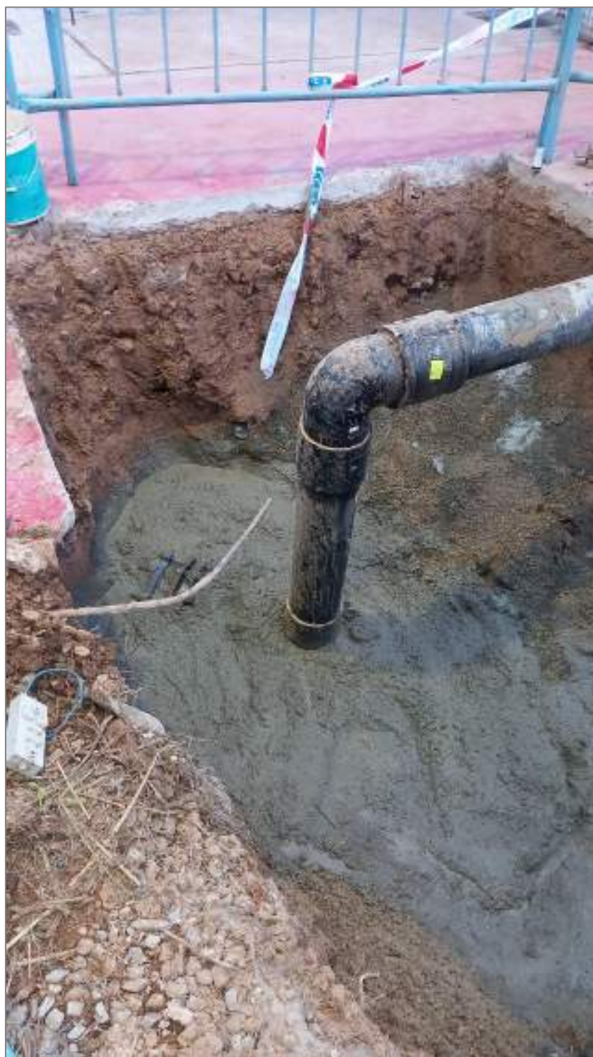
Fotografía 4. Bypass provisional de polietileno DN200 de la tubería general de abastecimiento a Vilamarxant afectada en el cruce del Barranco La Teulada para dar servicio a la población. Detalle 3
