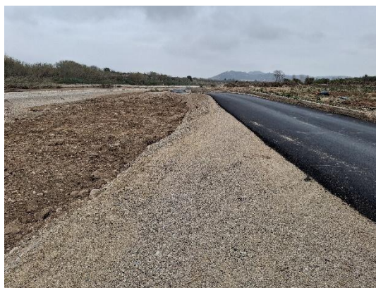
Continuación de la impulsión de Rafol paralela al barranco (del barranco hasta el pozo)
