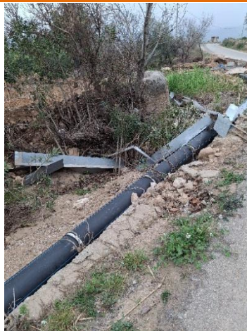
Impulsión El Rafol. Tubería provisional (tramo en PE para hacer curvatura)
