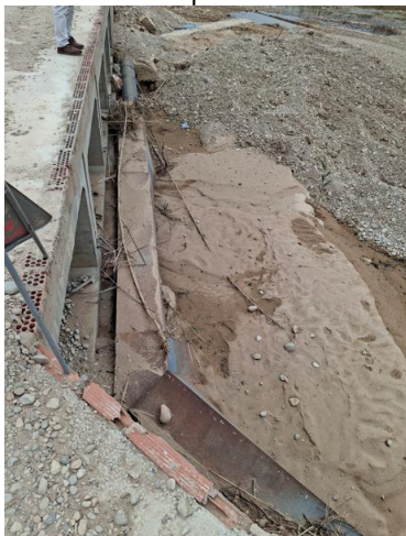
Cruce de barranco
