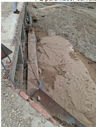
Cruce de barranco
