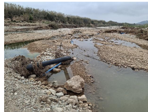
Cruce de barranco.
