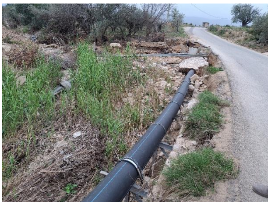
Impulsión El Rafol. Tubería provisional (tramo en PE para hacer curvatura)
