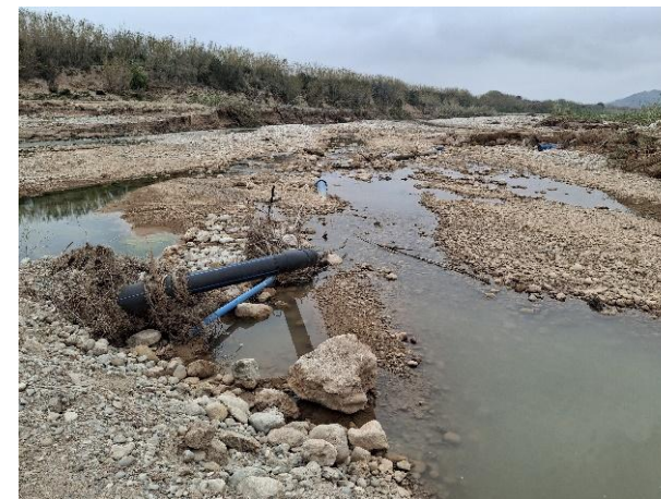
Cruce de barranco.
