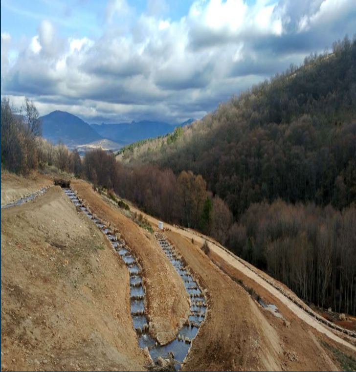
Rampa de la presa de Santa Lucía
