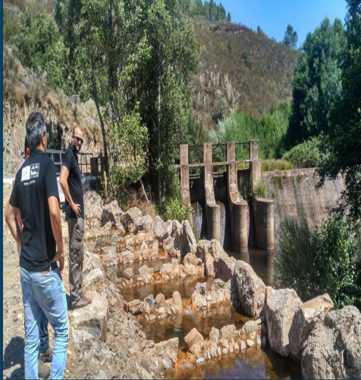
Rampa del azud del Agadón
