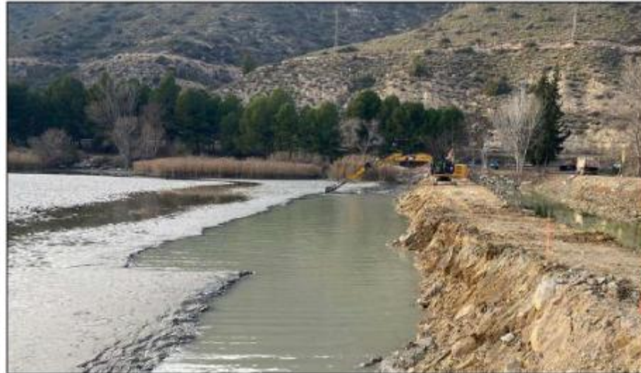
Retirada de lodos desde el espigón
