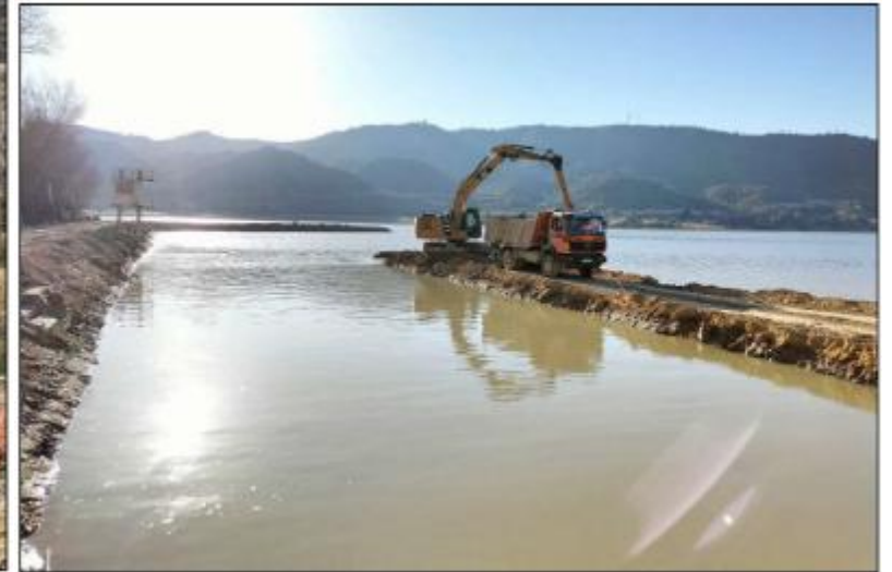
Retirada de los espigones tras completar el dragado
