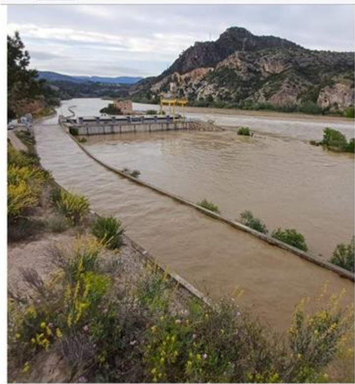
Crecida controlada 7 de mayo de 2025 a su paso por el azud de Xerta
