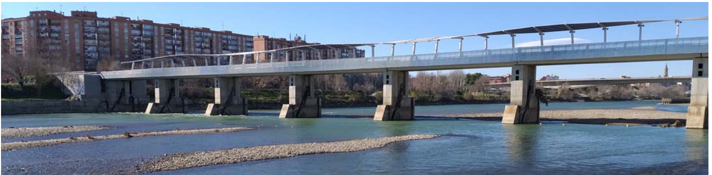
Figura 9.1. Vista hacia aguas arriba del azud sobre el río Ebro con las compuertas abatidas.
