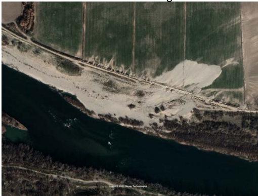
Figura 8.3. Roturas de mota y depósitos de gravas tras la crecida de diciembre de 2021
