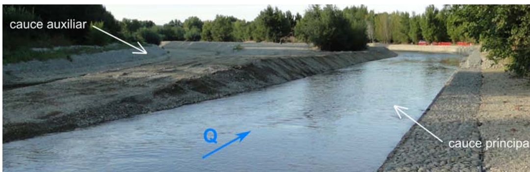
Figura 6.2. Vista desde aguas arriba del cauce auxiliar (izquierda) y del cauce principal del río Gállego (derecha) poco después de que finalizaran las obras. A la derecha de la imagen se aprecian los gaviones para proteger dicha margen de la erosión. Fotografía gentileza de José Bellosta.
