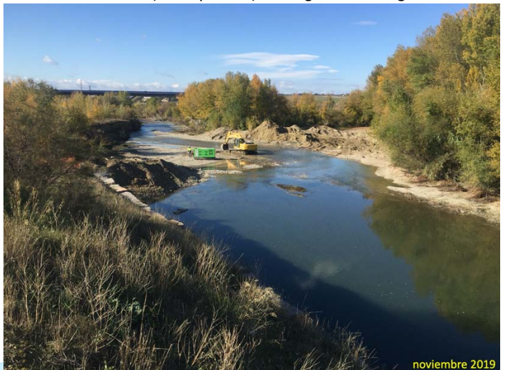
Figura 5.9. En noviembre de 2019 obras para enterrar el gasoducto
