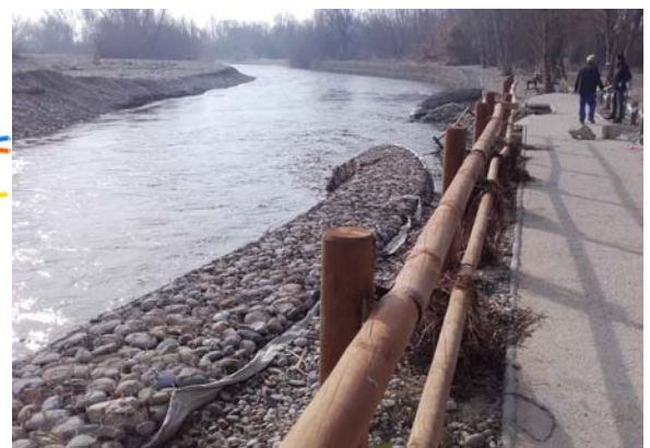
Figura 6.3. Acumulación de material en una sección del cauce auxiliar (izquierda) y destrucción de la protección de gaviones y del andador (derecha) en la crecida de 2016.
